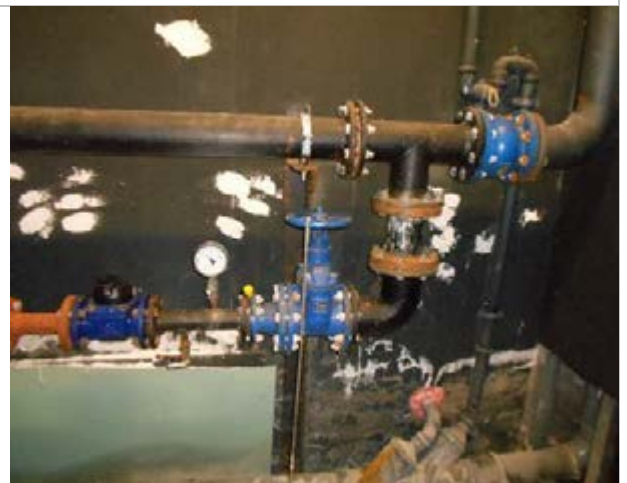
Фото 106. Внутренне состояние помещений, расположенных на цокольном этаже
