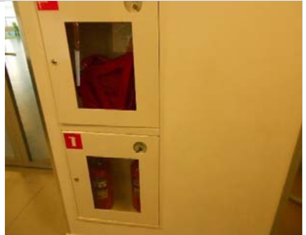
Фото 44. Внутреннее состояние помещений, расположенных на 3-ем этаже
