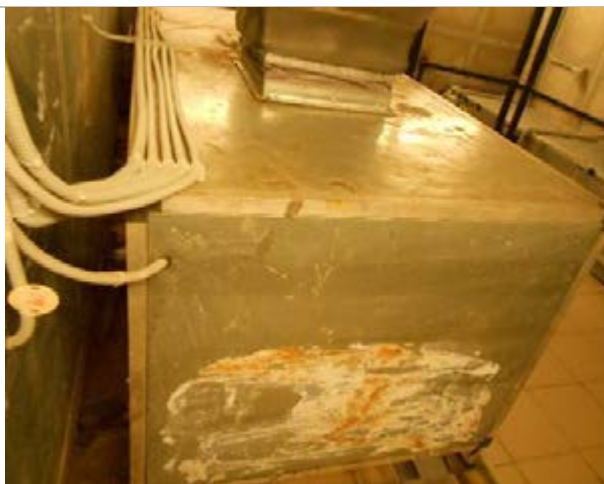
Фото 122. Внутренне состояние помещений, расположенных на цокольном этаже
