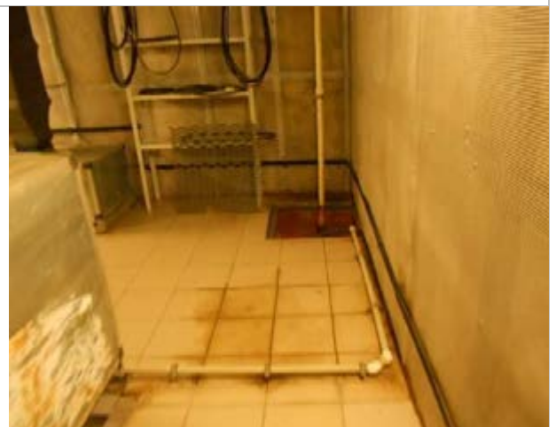
Фото 120. Внутренне состояние помещений, расположенных на цокольном этаже
