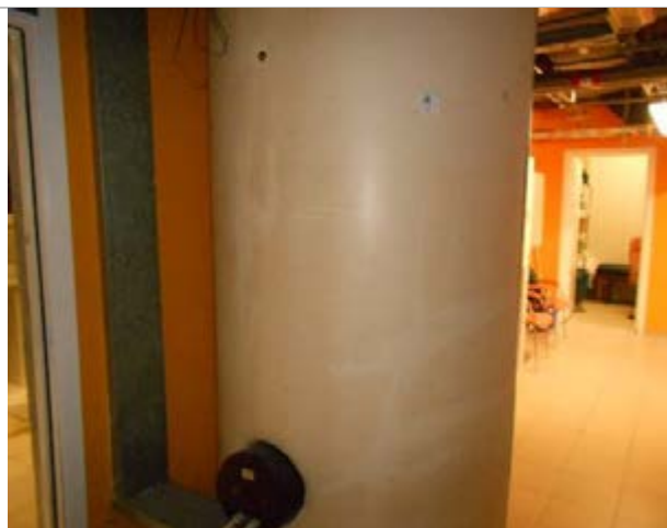
Фото 128. Внутренне состояние помещений, расположенных на цокольном этаже
