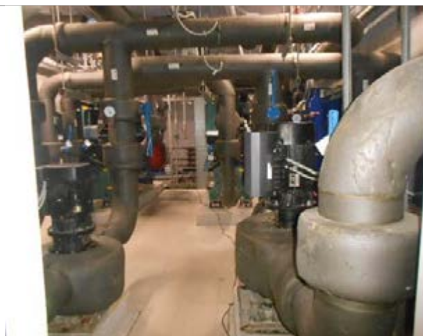
Фото 130. Внутренне состояние помещений, расположенных на цокольном этаже
