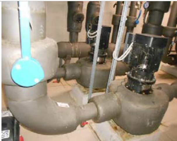
Фото 134. Внутренне состояние помещений, расположенных на цокольном этаже
