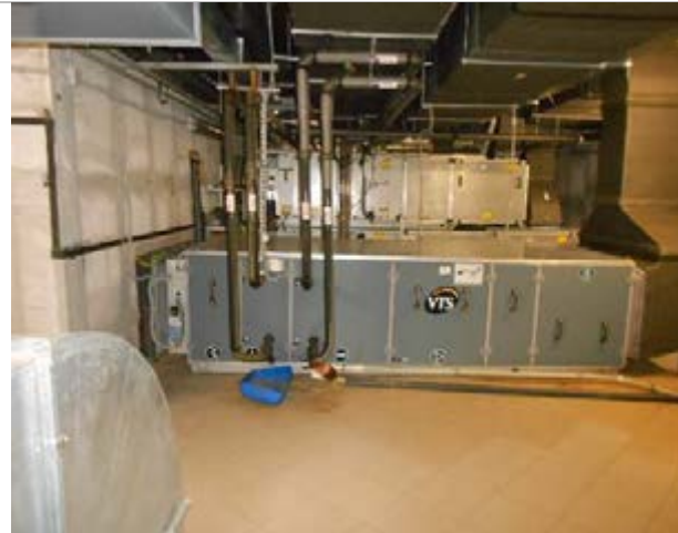
Фото 55. Внутреннее состояние помещений, расположенных на 3-ем этаже
