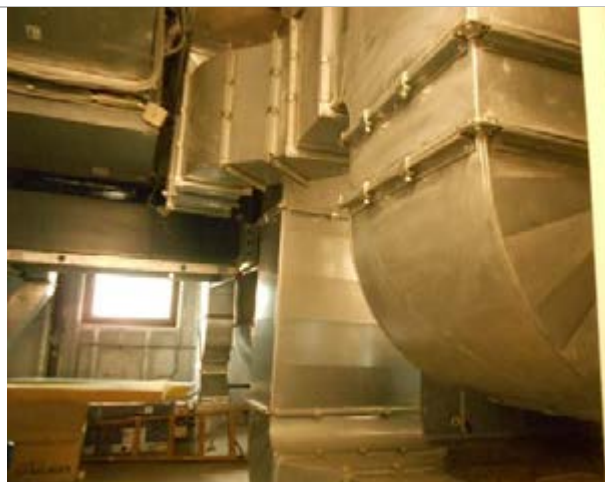
Фото 49. Внутреннее состояние помещений, расположенных на 3-ем этаже
