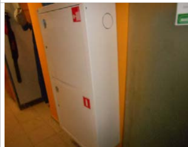
Фото 125. Внутренне состояние помещений, расположенных на цокольном этаже
