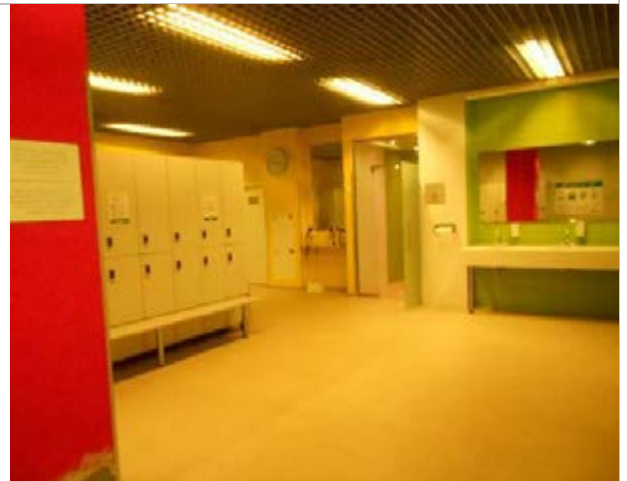
Фото 94. Внутренне состояние помещений, расположенных на цокольном этаже
