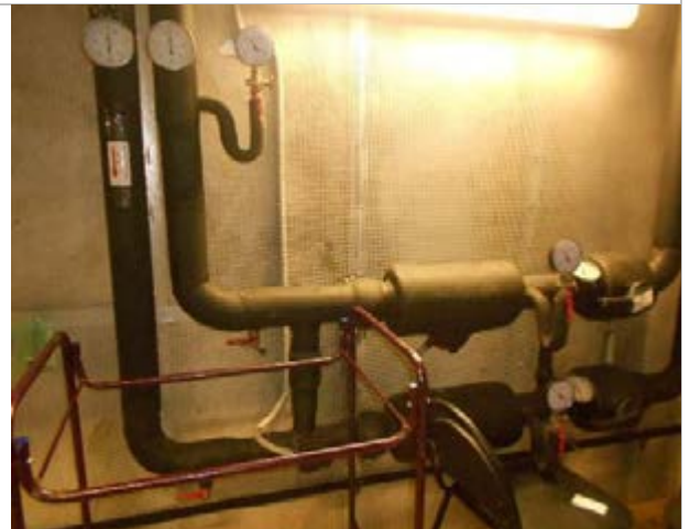
Фото 118. Внутренне состояние помещений, расположенных на цокольном этаже
