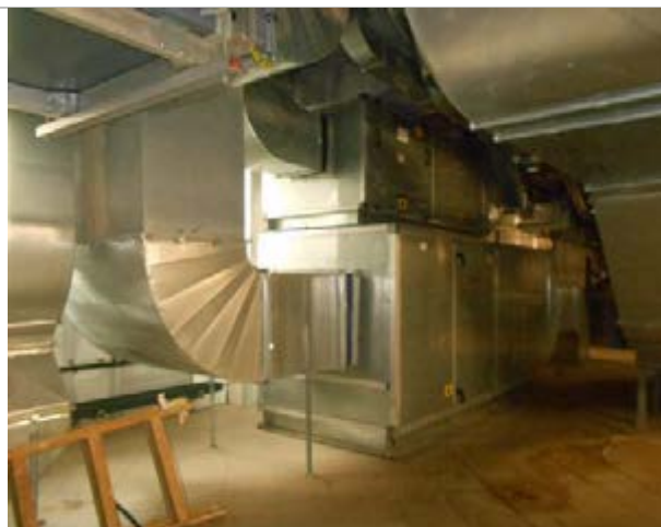
Фото 53. Внутреннее состояние помещений, расположенных на 3-ем этаже
