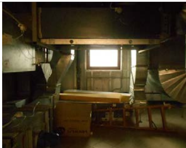
Фото 51. Внутреннее состояние помещений, расположенных на 3-ем этаже
