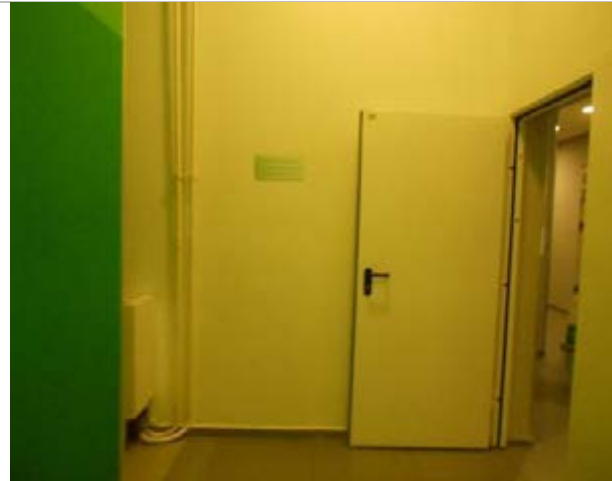
Фото 91. Внутренне состояние помещений, расположенных на цокольном этаже
