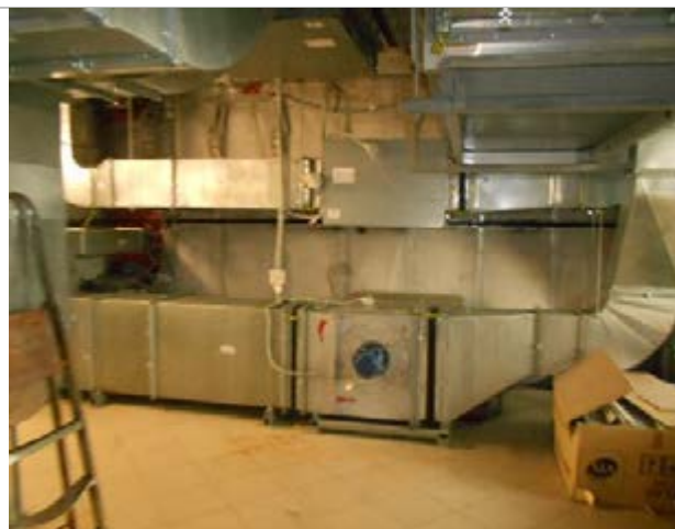
Фото 61. Внутреннее состояние помещений, расположенных на 3-ем этаже
