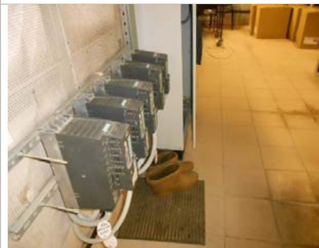
Фото 123. Внутренне состояние помещений, расположенных на цокольном этаже
