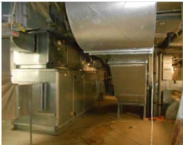
Фото 52. Внутреннее состояние помещений, расположенных на 3-ем этаже
