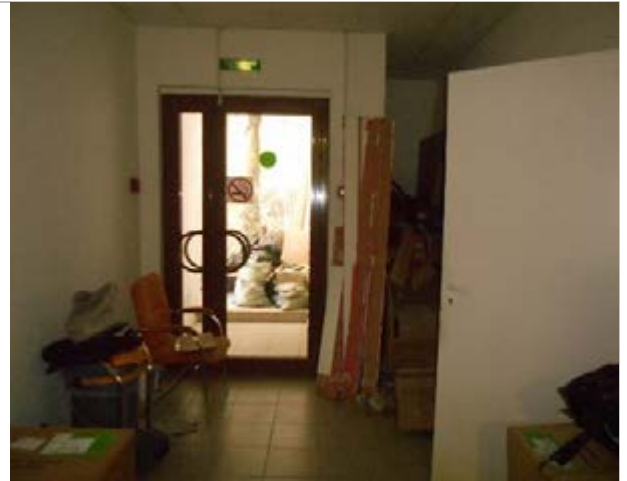
Фото 104. Внутренне состояние помещений, расположенных на цокольном этаже
