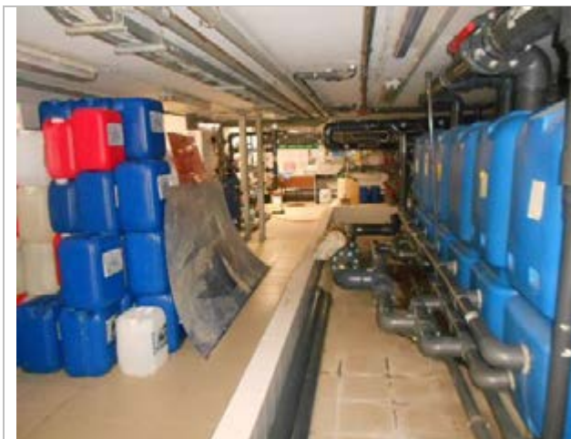
Фото 109. Внутренне состояние помещений, расположенных на цокольном этаже
