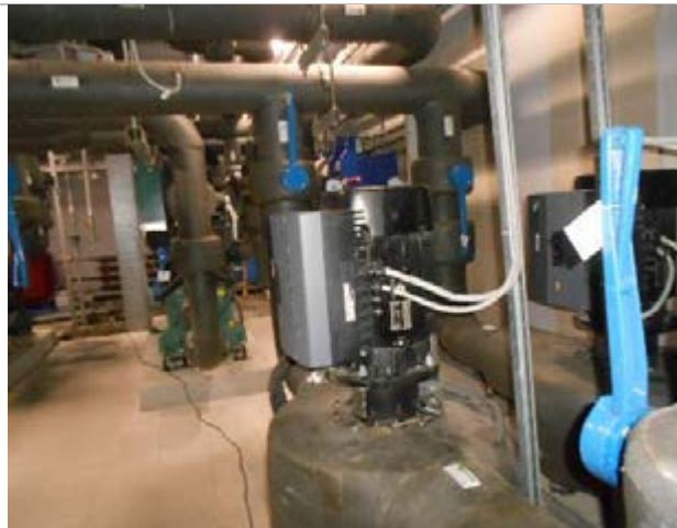
Фото 133. Внутренне состояние помещений, расположенных на цокольном этаже
