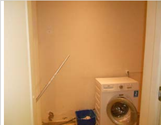
Фото 103. Внутренне состояние помещений, расположенных на цокольном этаже
