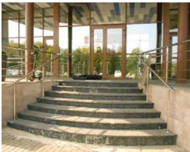
Фото 88. Подъездные пути и фасад здания
