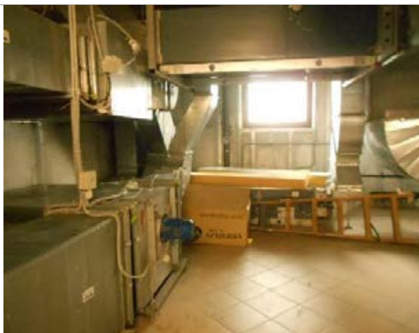
Фото 50. Внутреннее состояние помещений, расположенных на 3-ем этаже
