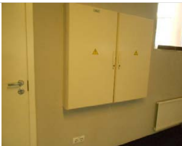
Фото 30. Внутреннее состояние помещений, расположенных на 2-ом этаже
