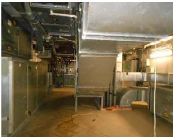
Фото 54. Внутреннее состояние помещений, расположенных на 3-ем этаже
