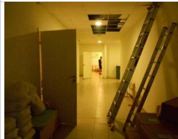
Фото 105. Внутренне состояние помещений, расположенных на цокольном этаже
