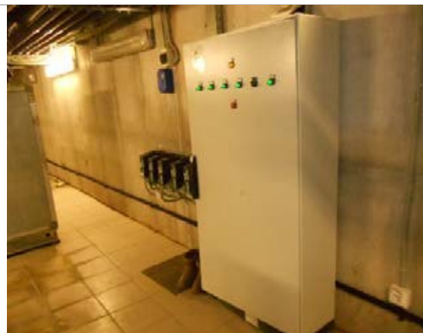
Фото 119. Внутренне состояние помещений, расположенных на цокольном этаже
