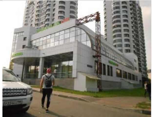
Фото 80. Подъездные пути и фасад здания
