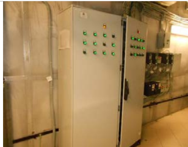
Фото 57. Внутреннее состояние помещений, расположенных на 3-ем этаже
