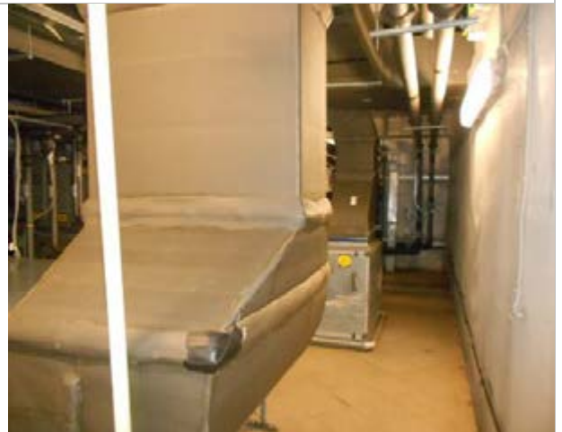
Фото 58. Внутреннее состояние помещений, расположенных на 3-ем этаже
