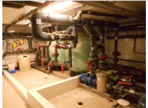
Фотография 3.4. Внутреннее состояние помещений цоколя, входящих в состав объекта оценки
