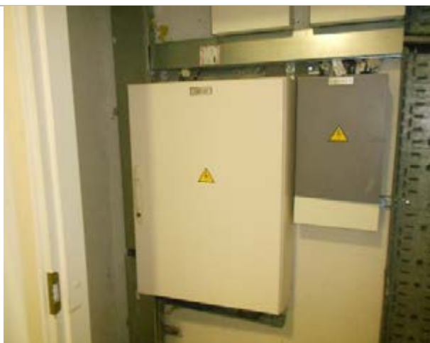
Фото 100. Внутренне состояние помещений, расположенных на цокольном этаже
