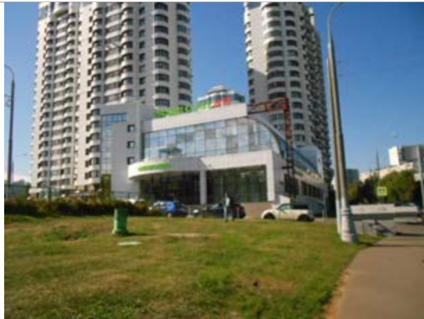
Фотография 3.1. Внешний вид здания
