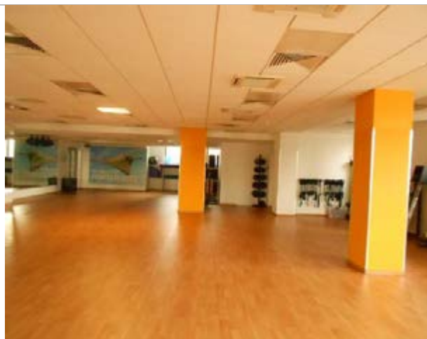
Фото 36. Внутреннее состояние помещений, расположенных на 2-ом этаже
