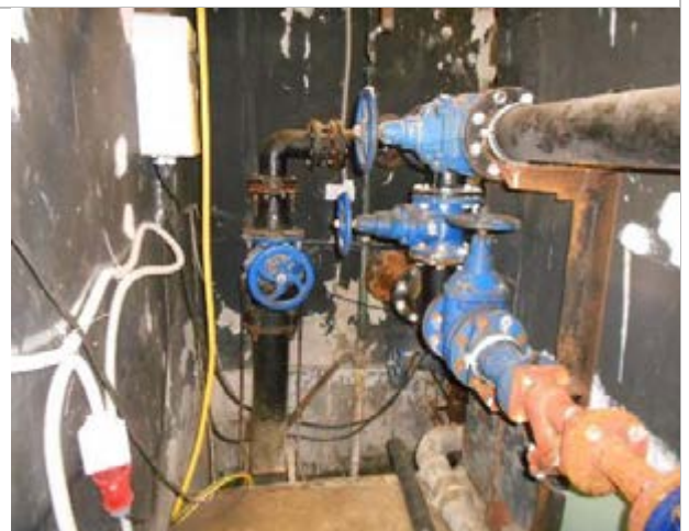
Фото 108. Внутренне состояние помещений, расположенных на цокольном этаже
