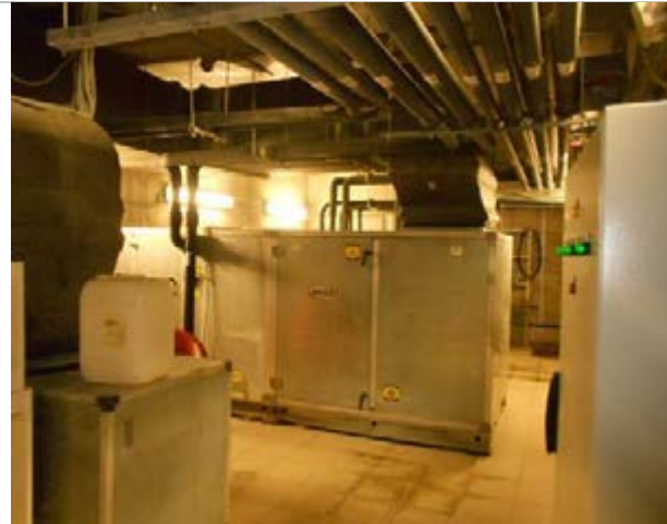
Фото 115. Внутренне состояние помещений, расположенных на цокольном этаже
