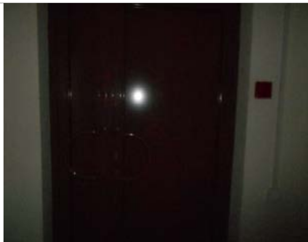
Фото 39. Внутреннее состояние помещений, расположенных на 2-ом этаже
