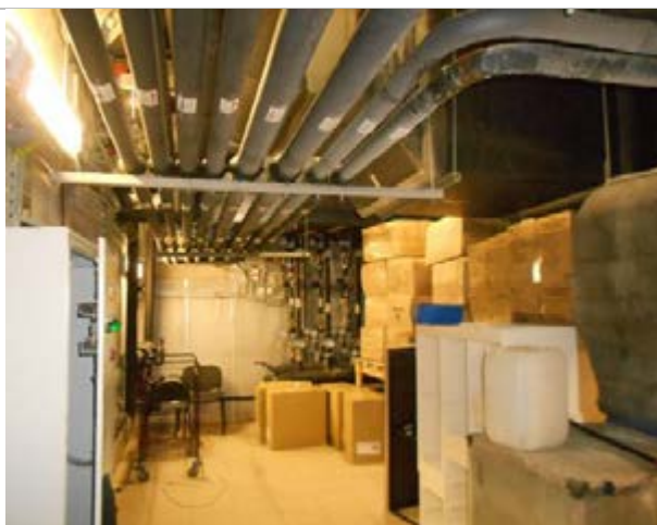
Фото 124. Внутренне состояние помещений, расположенных на цокольном этаже
