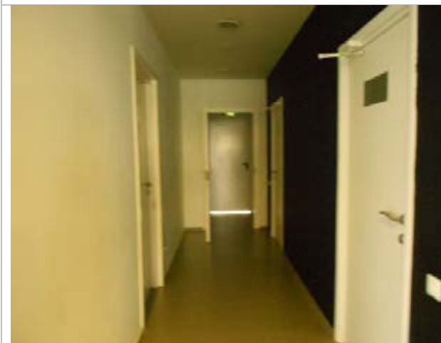
Фото 23. Внутреннее состояние помещений, расположенных на 2-ом этаже
