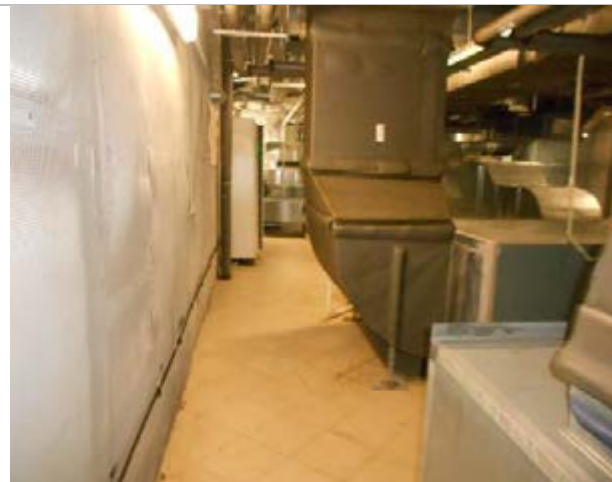
Фото 59. Внутреннее состояние помещений, расположенных на 3-ем этаже
