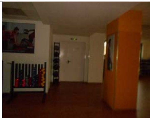
Фото 35. Внутреннее состояние помещений, расположенных на 2-ом этаже
