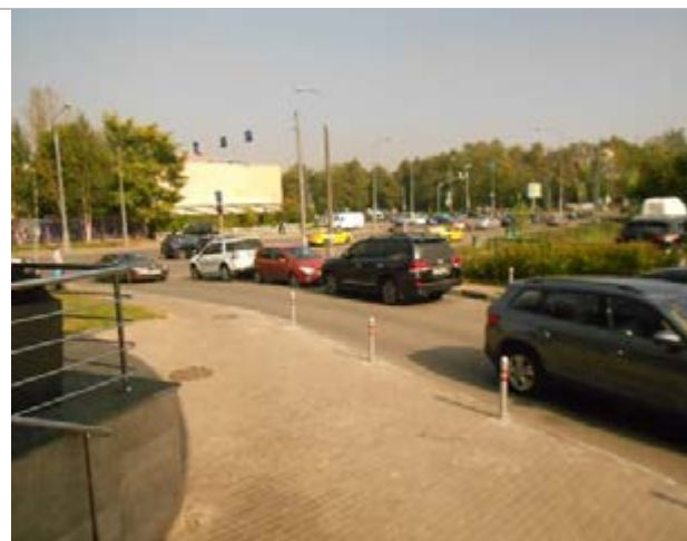
Фото 87. Подъездные пути и фасад здания
