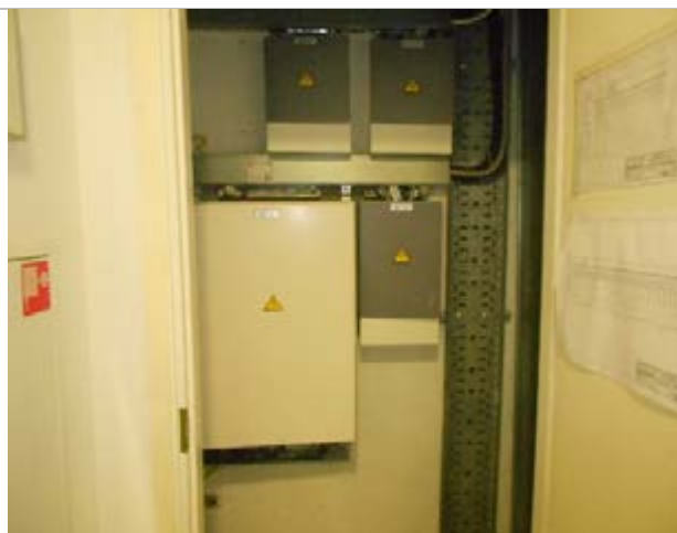
Фото 99. Внутренне состояние помещений, расположенных на цокольном этаже
