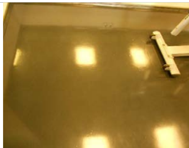
Фото 69. Внутреннее состояние помещений, расположенных на 3-ем этаже
