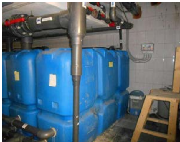
Фото 110. Внутренне состояние помещений, расположенных на цокольном этаже
