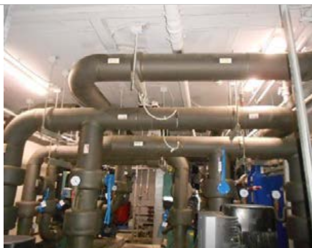
Фото 132. Внутренне состояние помещений, расположенных на цокольном этаже
