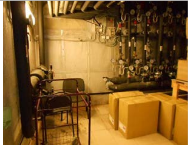
Фото 116. Внутренне состояние помещений, расположенных на цокольном этаже
