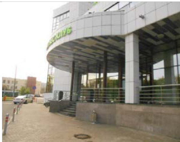
Фото 83. Подъездные пути и фасад здания
