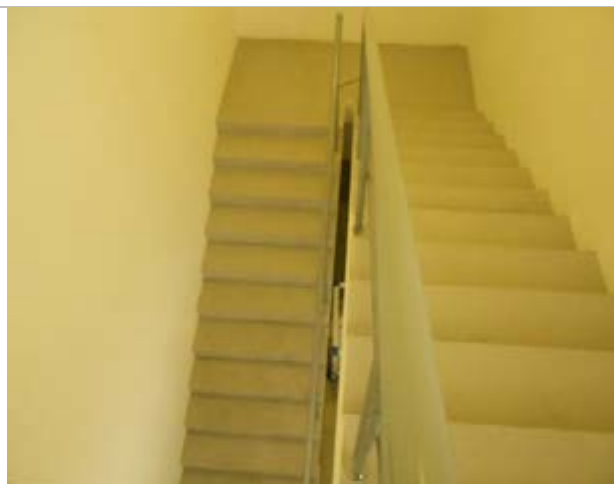
Фото 41. Внутреннее состояние помещений, расположенных на 3-ем этаже
