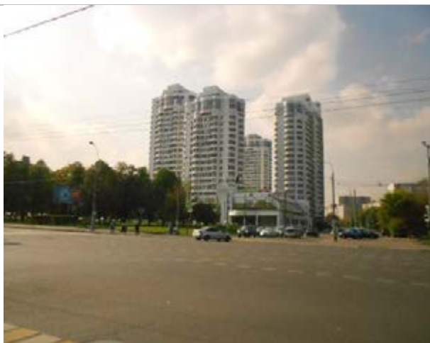
Фото 74. Подъездные пути и фасад здания
