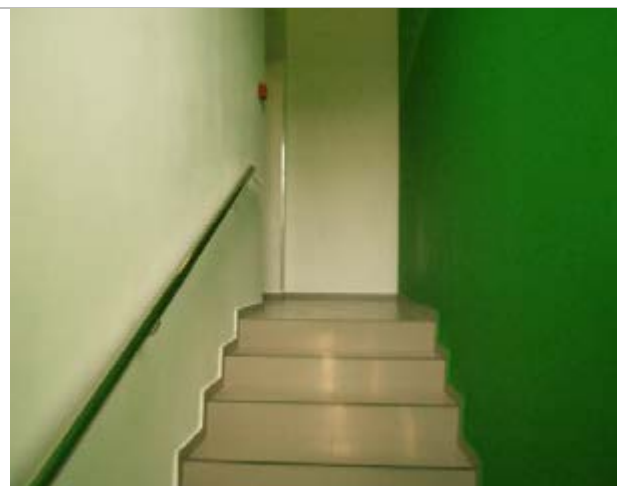
Фото 89. Внутренне состояние помещений, расположенных на цокольном этаже
