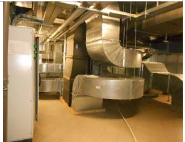
Фото 60. Внутреннее состояние помещений, расположенных на 3-ем этаже
