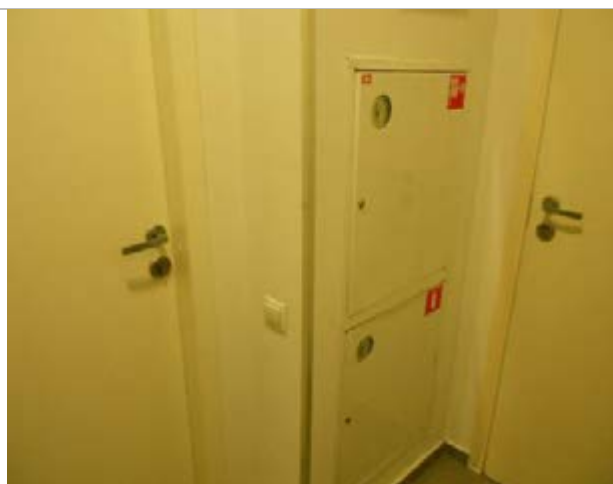
Фото 101. Внутренне состояние помещений, расположенных на цокольном этаже
