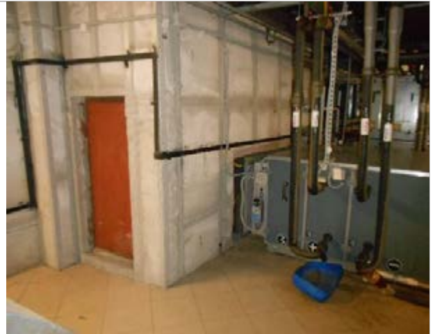
Фото 56. Внутреннее состояние помещений, расположенных на 3-ем этаже
