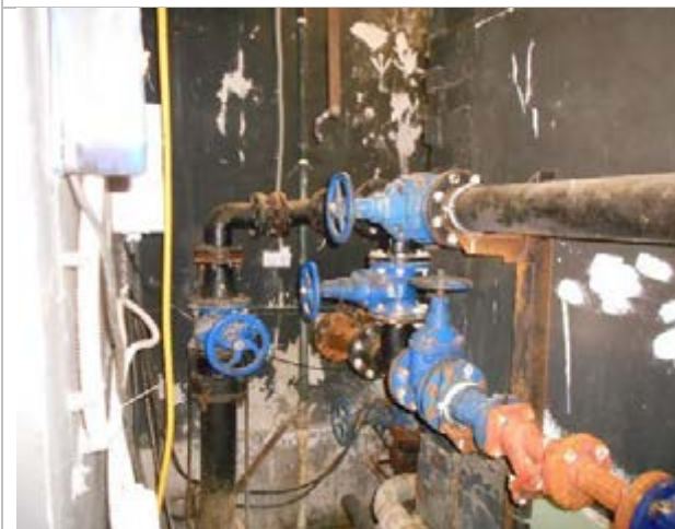
Фото 107. Внутренне состояние помещений, расположенных на цокольном этаже
