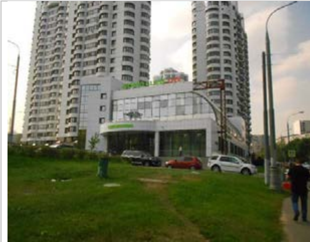
Фото 79. Подъездные пути и фасад здания
