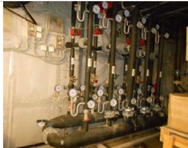
Фото 117. Внутренне состояние помещений, расположенных на цокольном этаже
