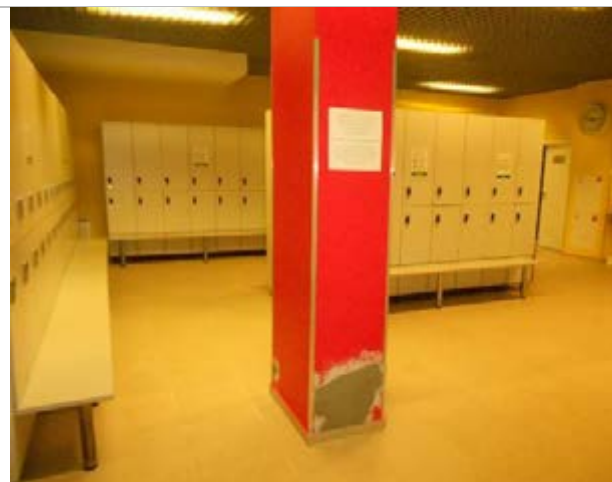
Фото 95. Внутренне состояние помещений, расположенных на цокольном этаже
