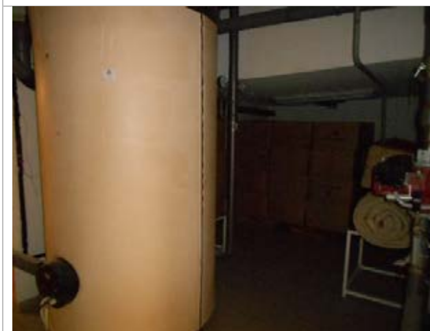
Фото 113. Внутренне состояние помещений, расположенных на цокольном этаже
