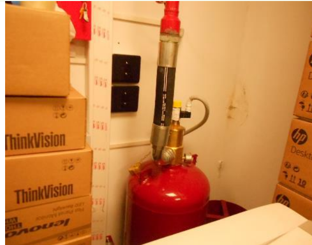
Фото 37. -5 эт. Помещение 67,8 кв. м.
