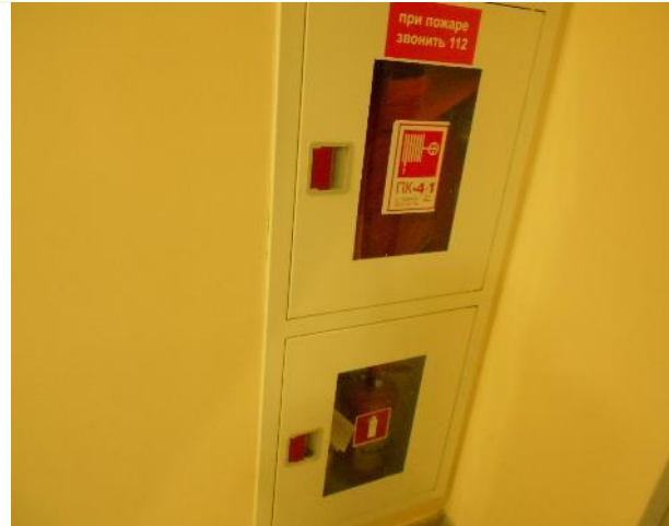
Фото 97. 4 эт. Помещение 72 226 кв. м.
