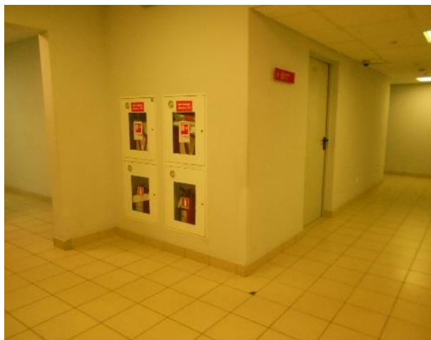
Фото 25. -5 эт. Помещение 67,8 кв. м.
