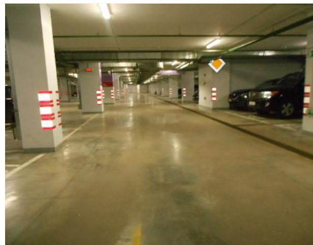
Фото 61. -5 эт. Помещение 72 226 кв. м.
