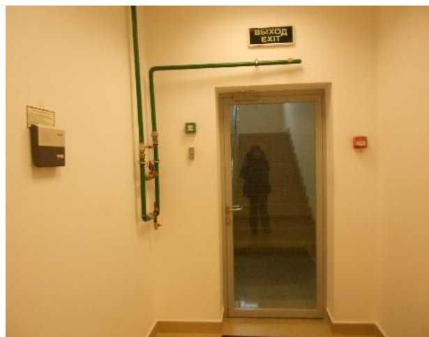
Фото 167. 7 эт. Помещение 72 226 кв. м.
