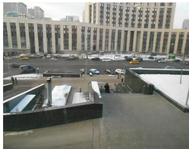
Фото 87. 3 эт. Помещение 72 226 кв. м.
