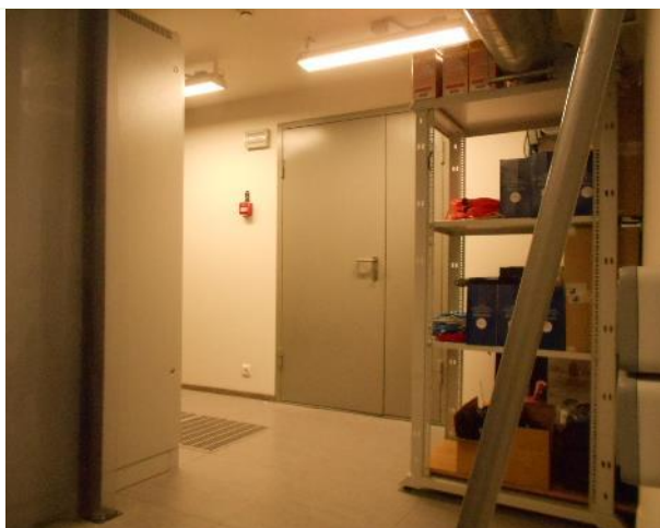
Фото 12. -4 эт. Вход в помещении 316,6 кв. м.
