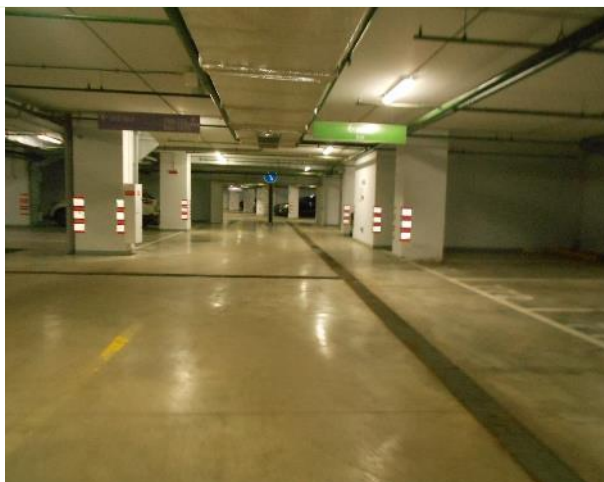
Фото 56. -5 эт. Помещение 72 226 кв. м.
