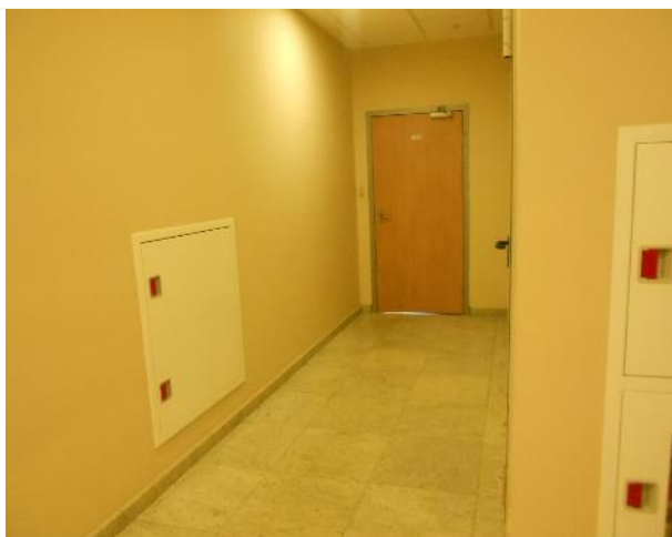
Фото 94. 4 эт. Помещение 72 226 кв. м.
