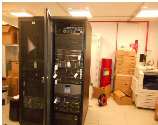
Фото 35. -5 эт. Помещение 67,8 кв. м.
