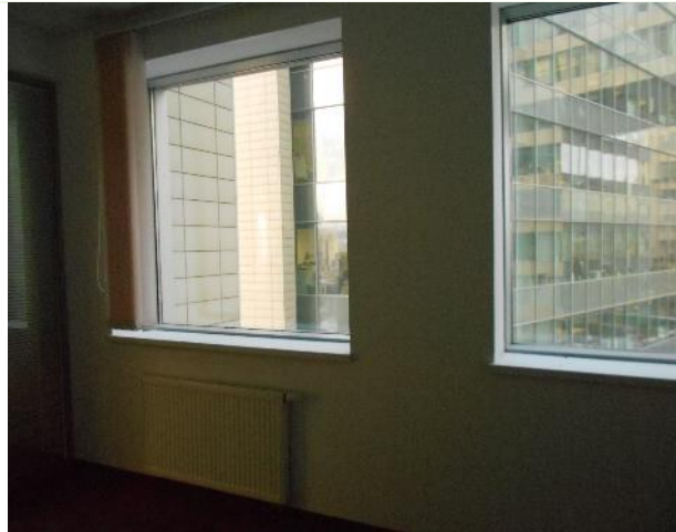
Фото 121. 4 эт. Помещение 72 226 кв. м.
