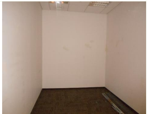
Фото 124. 4 эт. Помещение 72 226 кв. м.
