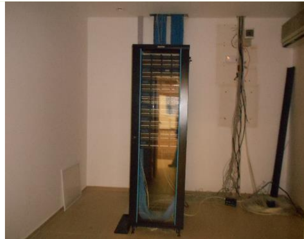
Фото 135. 4 эт. Помещение 72 226 кв. м.
