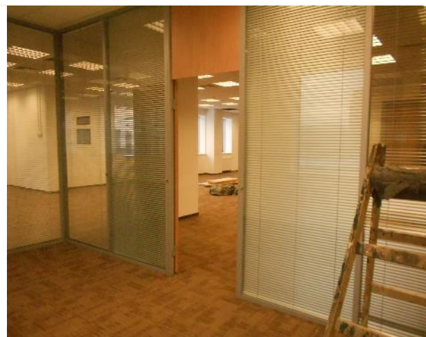
Фото 147. 4 эт. Помещение 72 226 кв. м.
