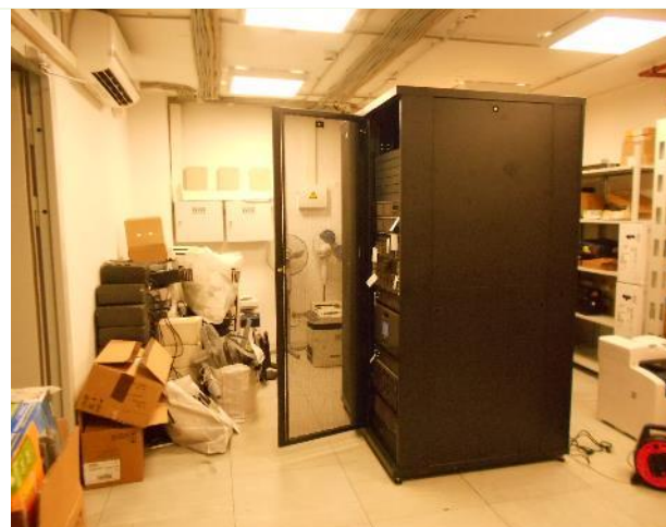
Фото 41. -5 эт. Помещение 67,8 кв. м.
