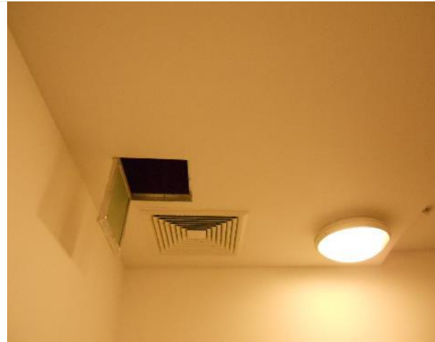
Фото 133. 4 эт. Помещение 72 226 кв. м.
