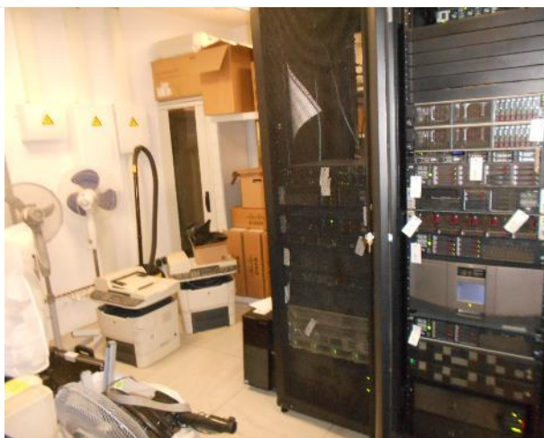
Фото 34. -5 эт. Помещение 67,8 кв. м.
