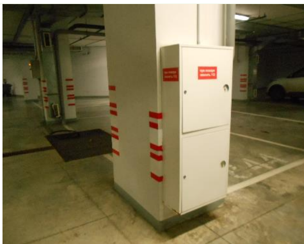
Фото 58. -5 эт. Помещение 72 226 кв. м.
