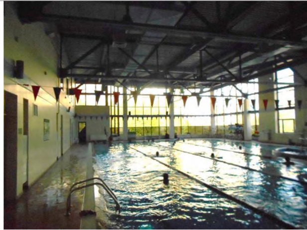
Фотография 3.12. Внутреннее состояние бассейна
