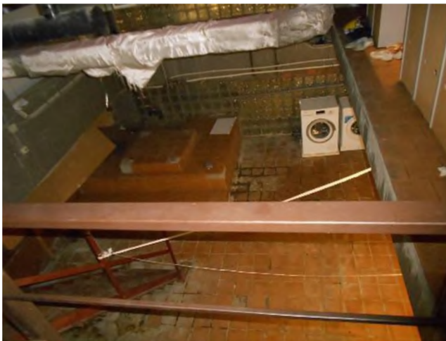
Фотография 45. Внутреннее состояние помещений, входящих в состав объекта оценки
