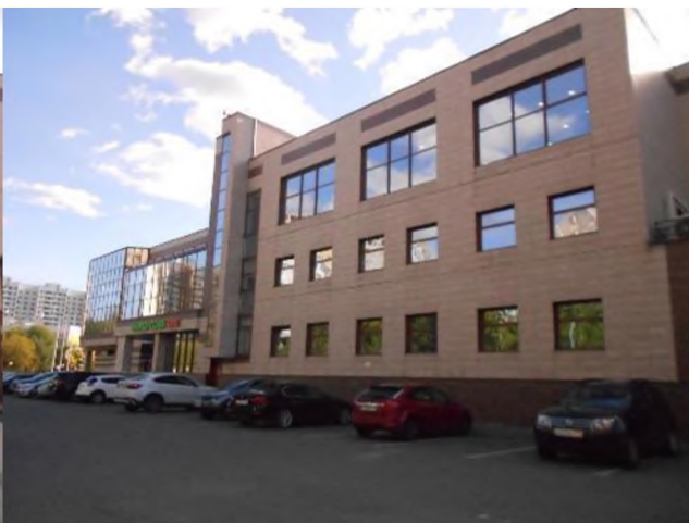
Фотография 98. Здание, в котором расположены оцениваемые помещения
