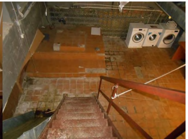
Фотография 46. Внутреннее состояние помещений, входящих в состав объекта оценки
