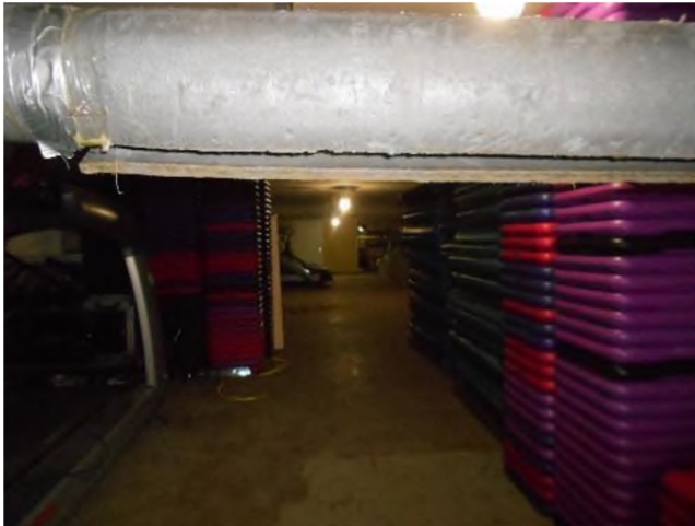
Фотография 103. Внутреннее состояние помещений, входящих в состав объекта оценки
