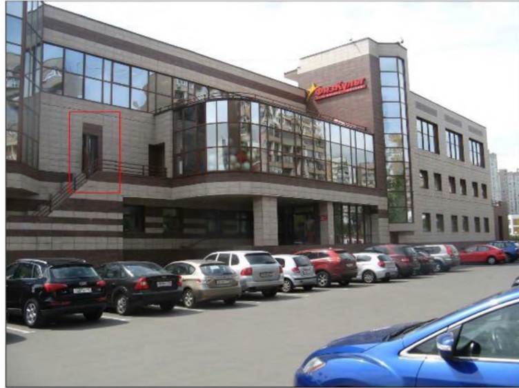
Фотоэскизы проектного предложения по устройству дверного проема на 2-ом этаже и остеклению балкона в осях Е-Ж/8-11
