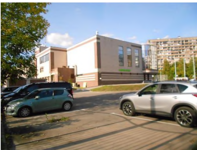
Фотография 95. Подъездные пути к зданию
