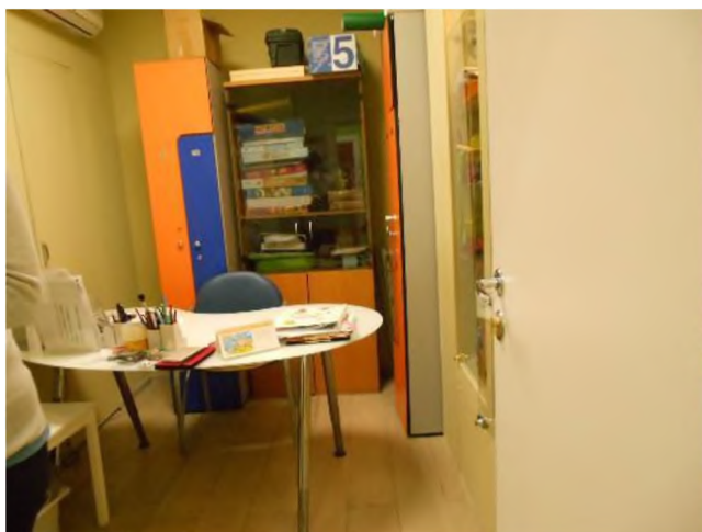
Фотография 11. Внутреннее состояние помещений, входящих в состав объекта оценки
