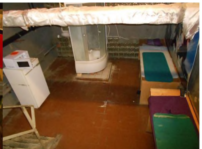
Фотография 48. Внутреннее состояние помещений, входящих в состав объекта оценки
