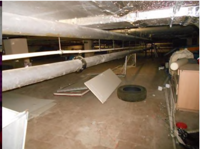
Фотография 104. Внутреннее состояние помещений, входящих в состав объекта оценки
