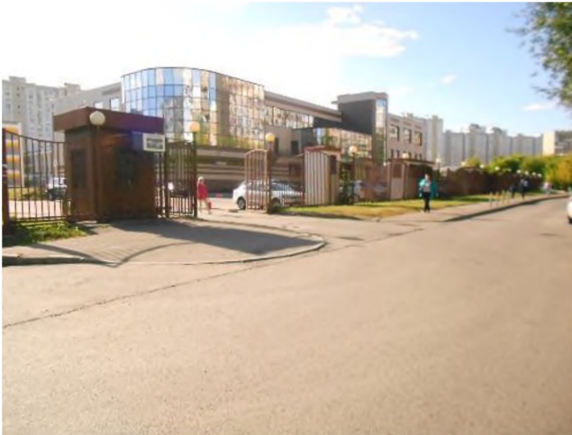
Фотография 91. Подъездные пути к зданию
