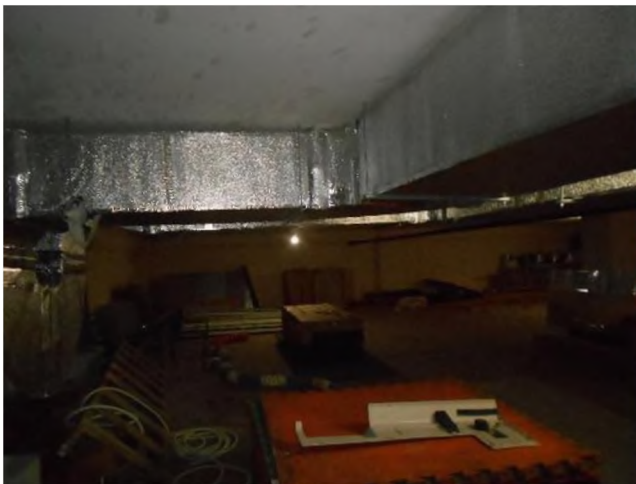
Фотография 105. Внутреннее состояние помещений, входящих в состав объекта оценки
