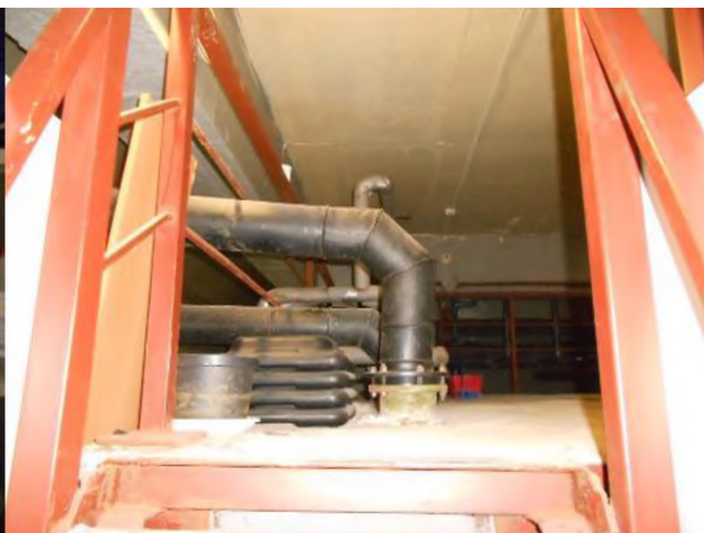
Фотография 38. Внутреннее состояние помещений, входящих в состав объекта оценки
