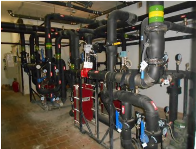
Фотография 43. Внутреннее состояние помещений, входящих в состав объекта оценки
