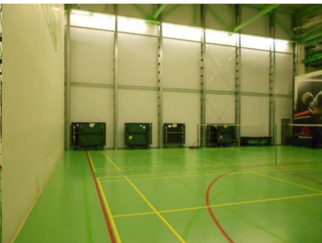
Фотография 20. Внутреннее состояние помещений, входящих в состав объекта оценки
