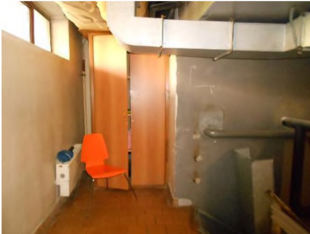
Фотография 49. Внутреннее состояние помещений, входящих в состав объекта оценки
