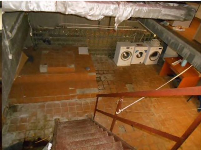
Фотография 50. Внутреннее состояние помещений, входящих в состав объекта оценки
