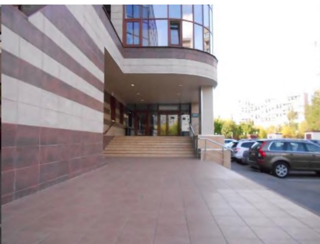
Фотография 100. Здание, в котором расположены оцениваемые помещения
