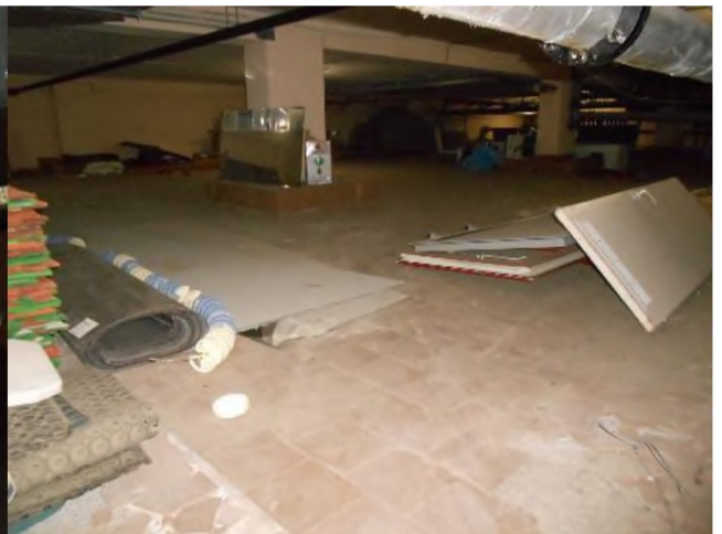
Фотография 106. Внутреннее состояние помещений, входящих в состав объекта оценки
