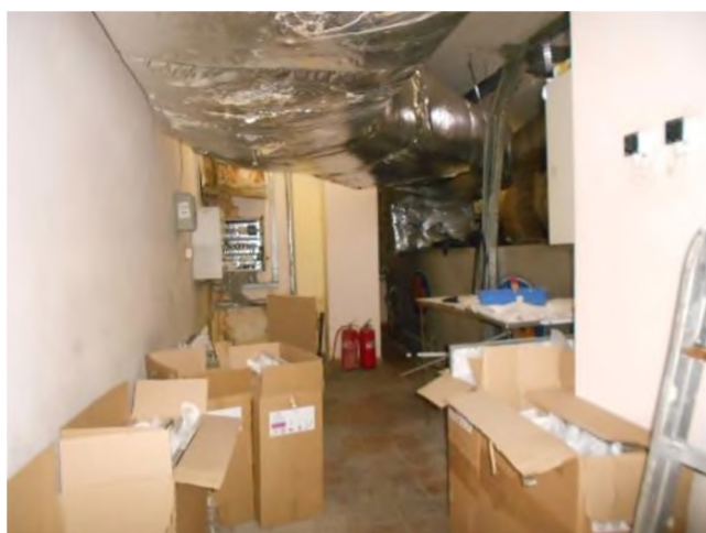
Фотография 41. Внутреннее состояние помещений, входящих в состав объекта оценки
