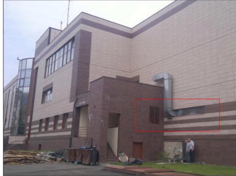
Фотомонтаж проектного предложения по устройству оконного проема и вентиляционной решетки в осях А-Б/12-13
