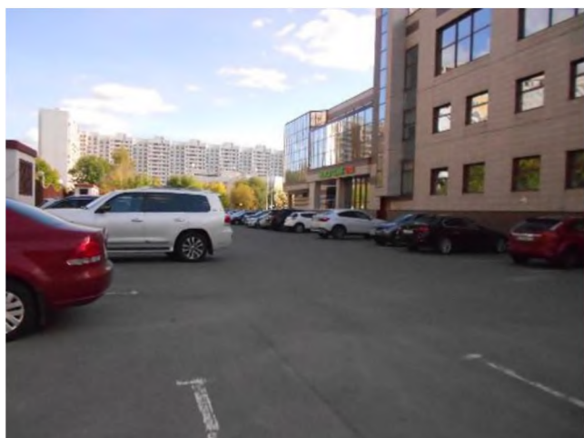
Фотография 99. Здание, в котором расположены оцениваемые помещения
