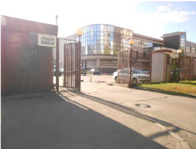
Фотография 93. Подъездные пути к зданию
