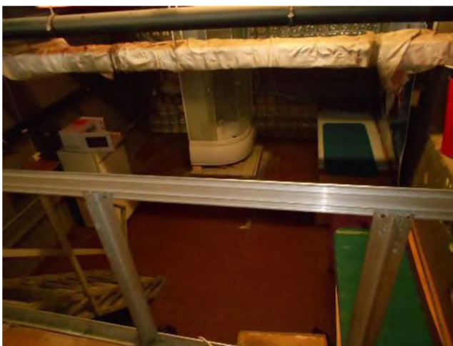
Фотография 47. Внутреннее состояние помещений, входящих в состав объекта оценки
