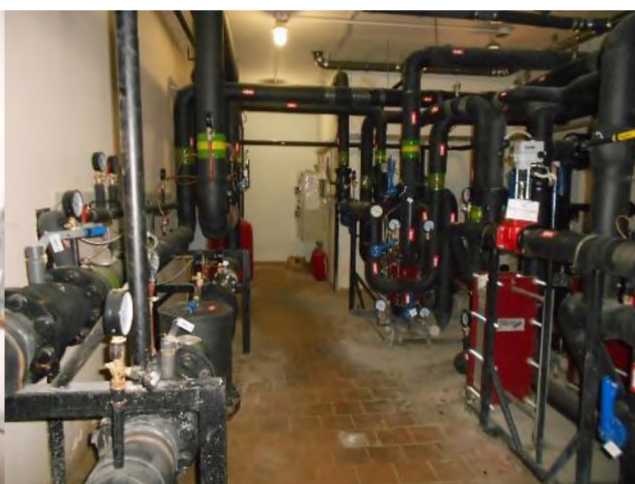
Фотография 42. Внутреннее состояние помещений, входящих в состав объекта оценки
