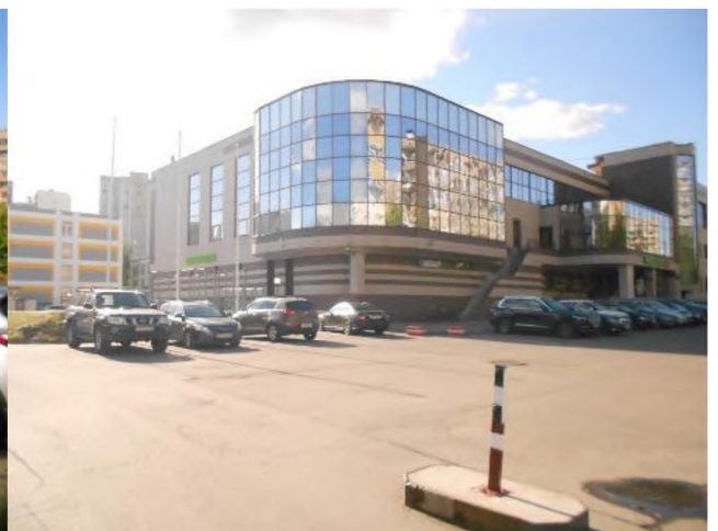
Фотография 96. Здание, в котором расположены оцениваемые помещения
