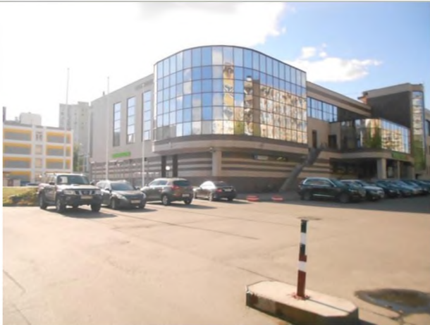
Фотография 3.1. Внешний вид здания
