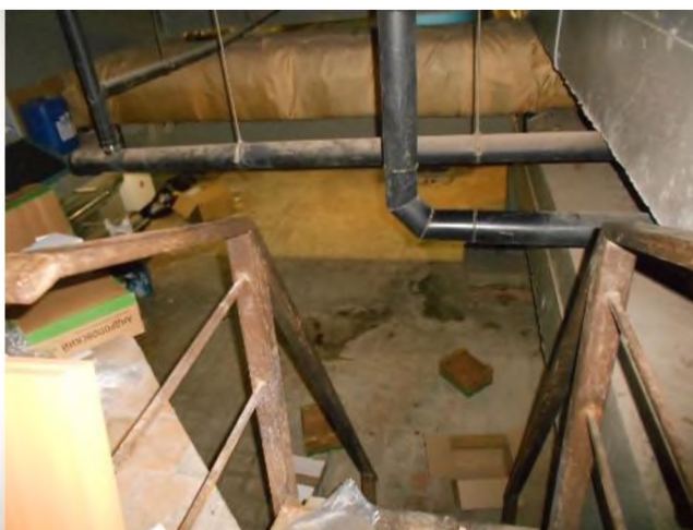
Фотография 40. Внутреннее состояние помещений, входящих в состав объекта оценки
