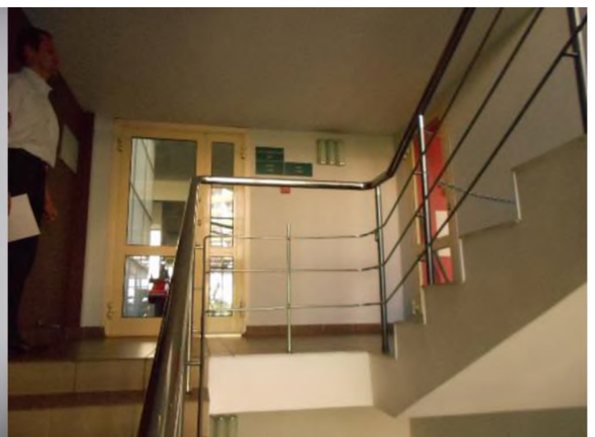
Фотография 72. Внутреннее состояние помещений, входящих в состав объекта оценки
