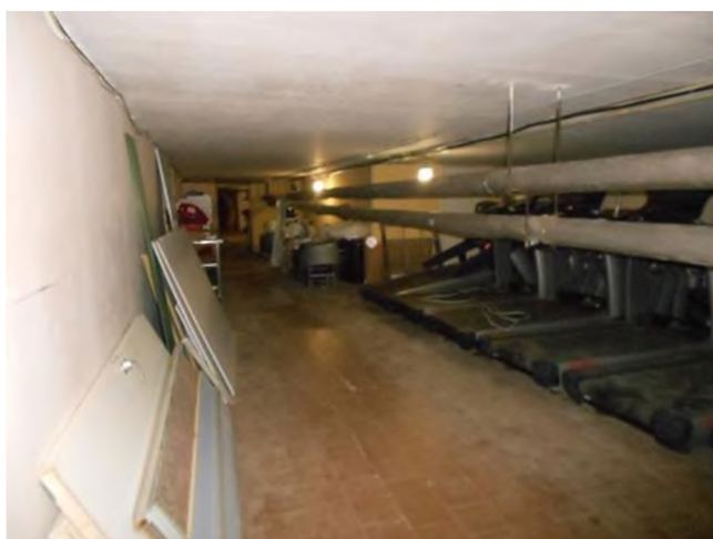
Фотография 101. Внутреннее состояние помещений, входящих в состав объекта оценки
