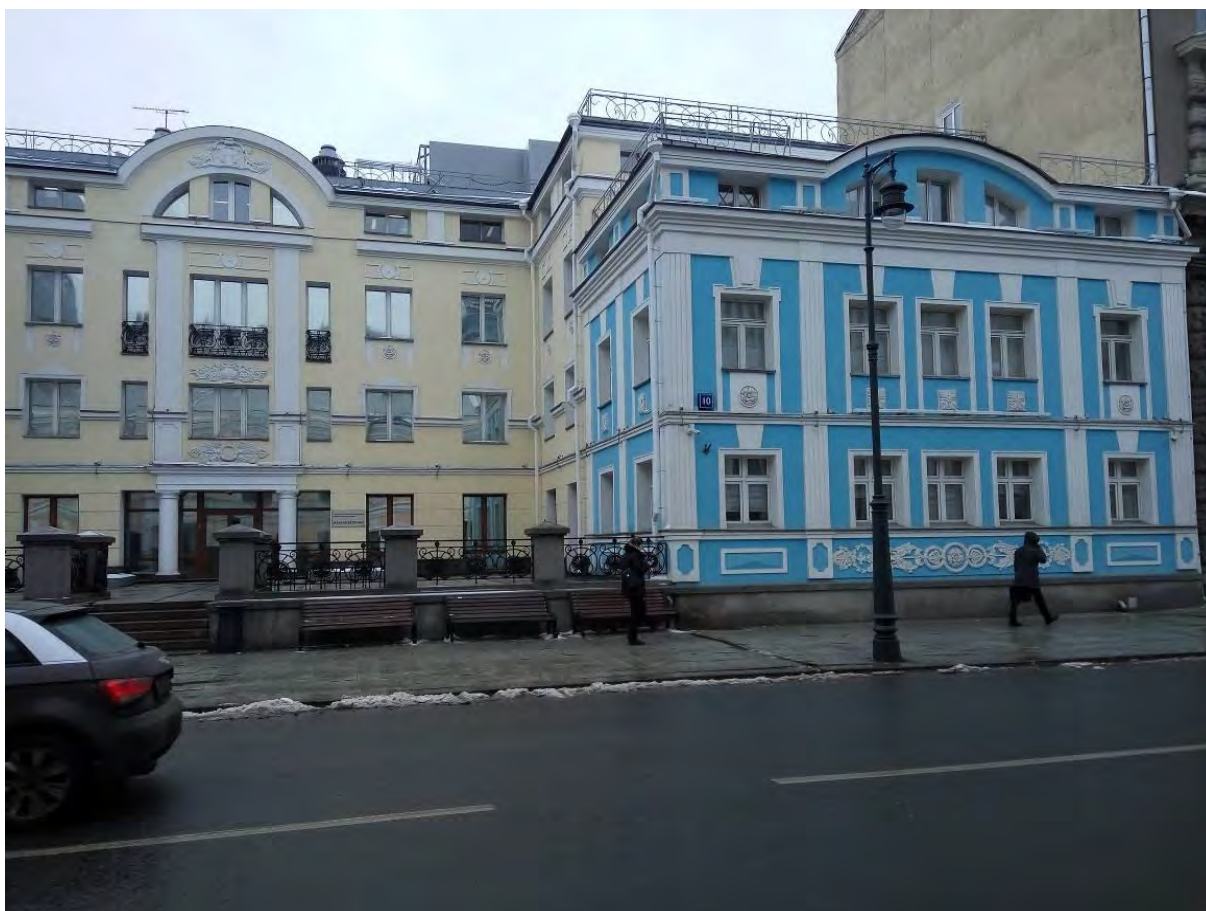
Фото 4. Общий вид здания
