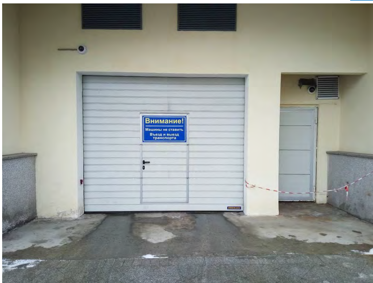
Фото 9. Въезд в подземную автостоянку (подвал)
