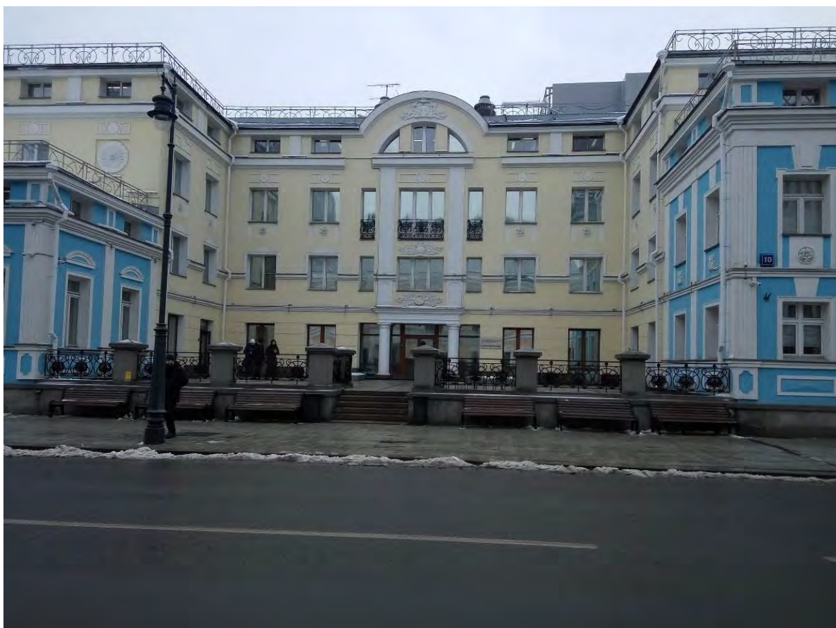
Фото 5. Ограждение и главный вход в здание
