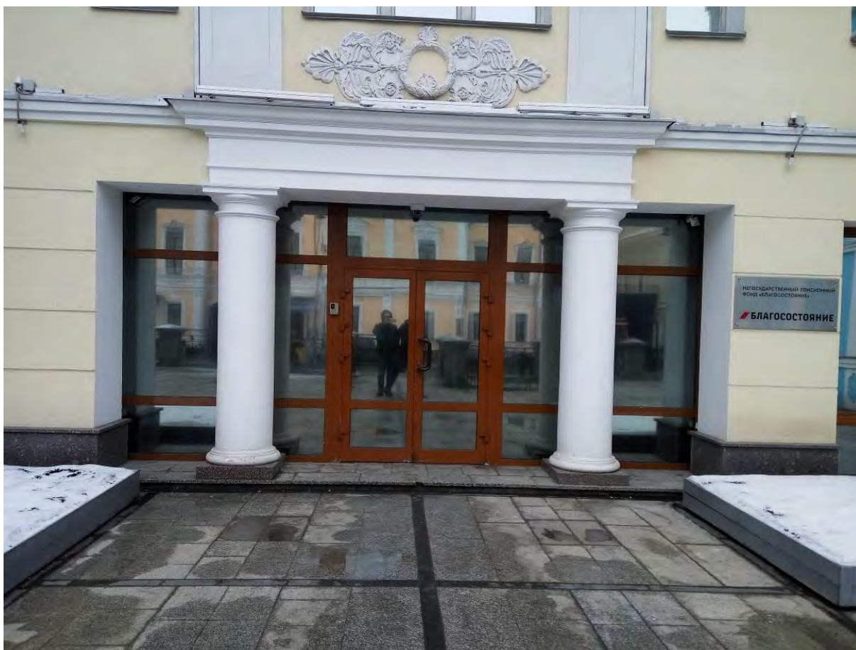
Фото 7. Главный вход в здание
