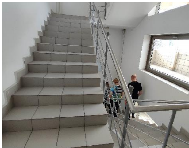
Фото 156. Состояние внутренних помещений (9 этаж)
