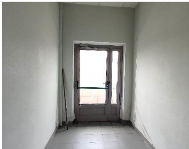
Фото 145. Состояние внутренних помещений (9 этаж)
