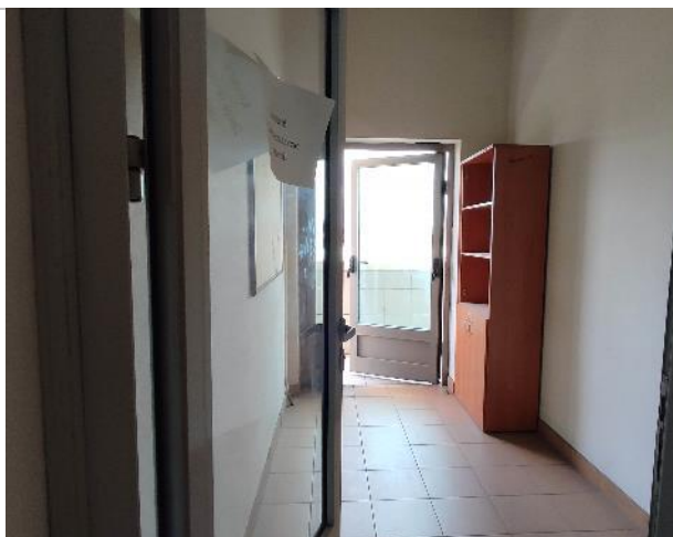
Фото 12. Состояние внутренних помещений (6 этаж)
