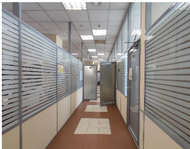
Фото 59. Состояние внутренних помещений (7 этаж)
