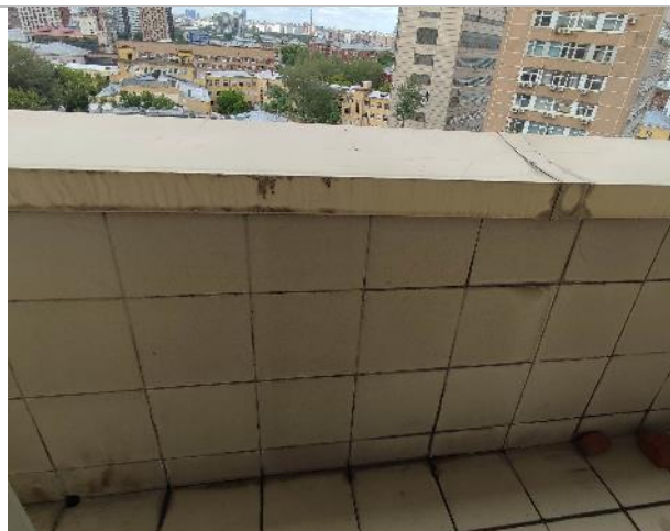
Фото 146. Состояние внутренних помещений (9 этаж)
