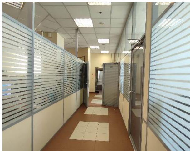
Фото 62. Состояние внутренних помещений (7 этаж)
