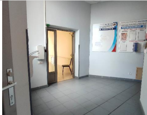
Фото 116. Состояние внутренних помещений (8 этаж)
