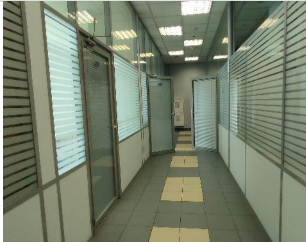
Фото 99. Состояние внутренних помещений (8 этаж)
