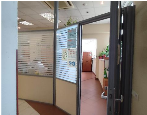
Фото 43. Состояние внутренних помещений (7 этаж)
