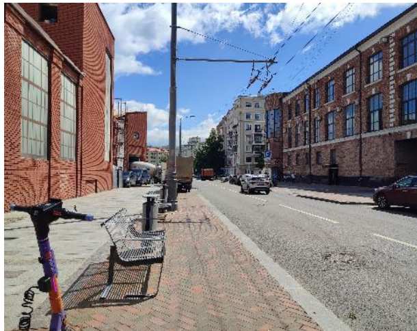
Фото 3. Подъездные пути и фасад здания
