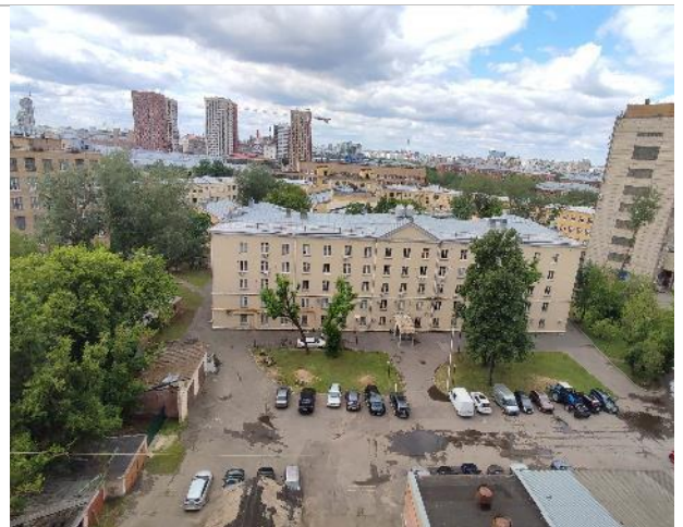
Фото 90. Состояние внутренних помещений (8 этаж)
