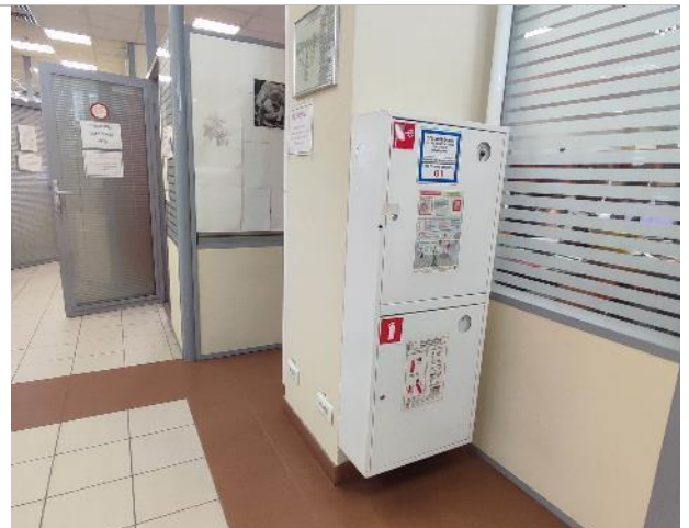
Фото 54. Состояние внутренних помещений (7 этаж)
