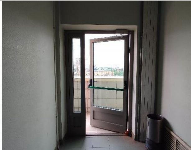
Фото 151. Состояние внутренних помещений (9 этаж)
