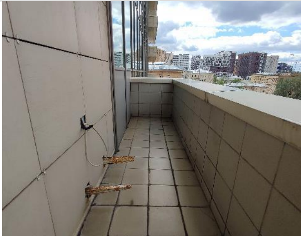
Фото 79. Состояние внутренних помещений (7 этаж)
