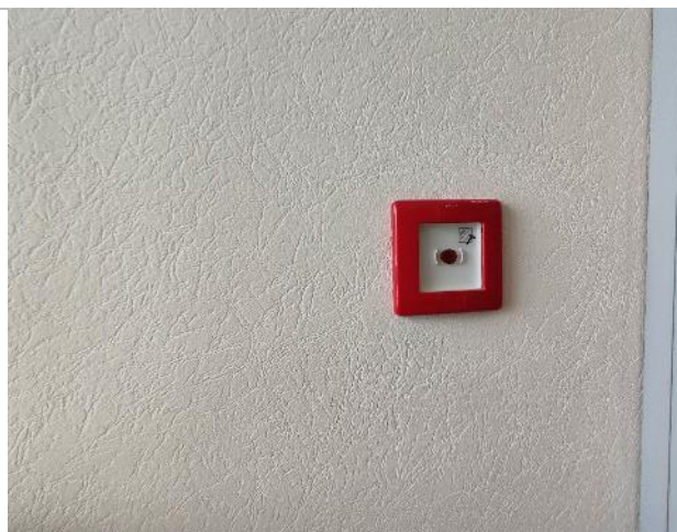
Фото 24. Состояние внутренних помещений (6 этаж)
