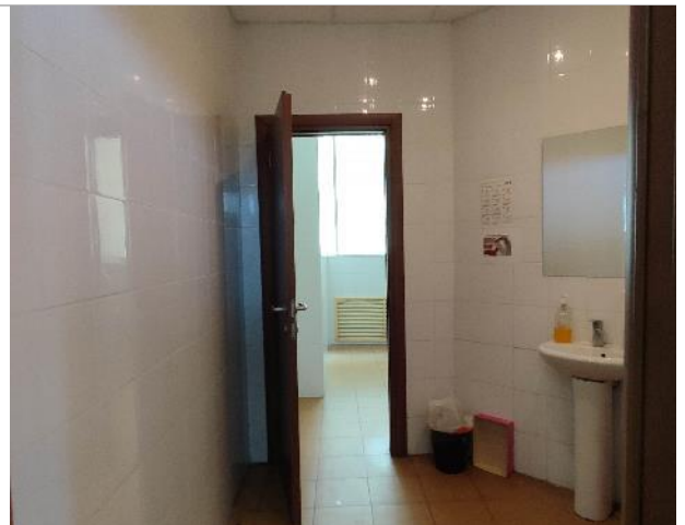
Фото 18. Состояние внутренних помещений (6 этаж)
