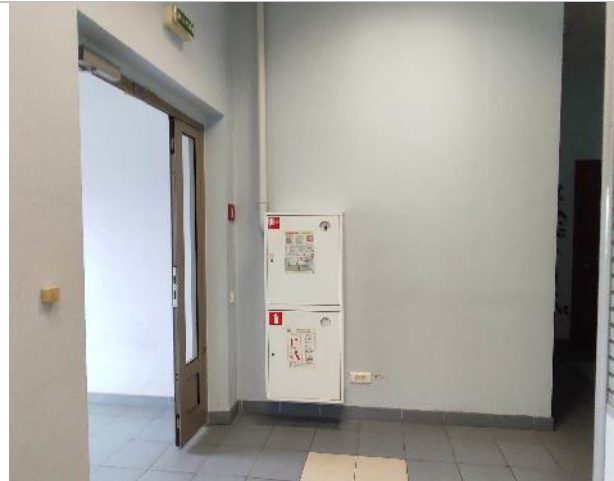
Фото 104. Состояние внутренних помещений (8 этаж)
