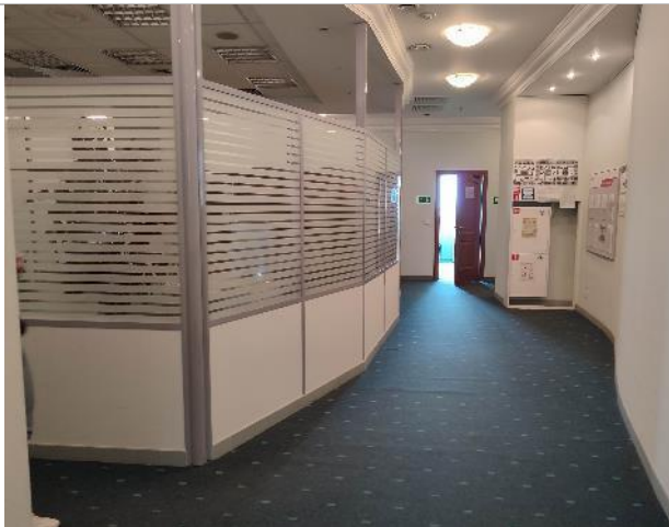
Фото 129. Состояние внутренних помещений (9 этаж)
