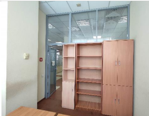
Фото 57. Состояние внутренних помещений (7 этаж)
