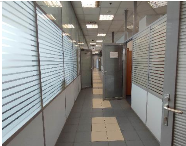
Фото 92. Состояние внутренних помещений (8 этаж)
