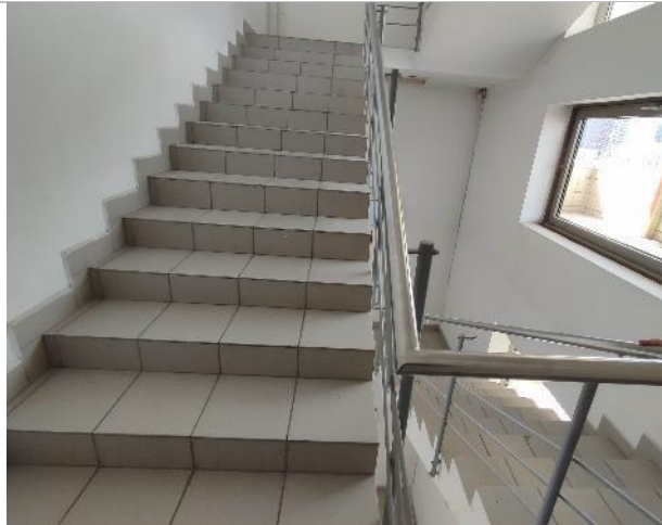
Фото 85. Состояние внутренних помещений (7 этаж)
