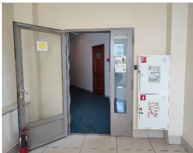
Фото 123. Состояние внутренних помещений (9 этаж)
