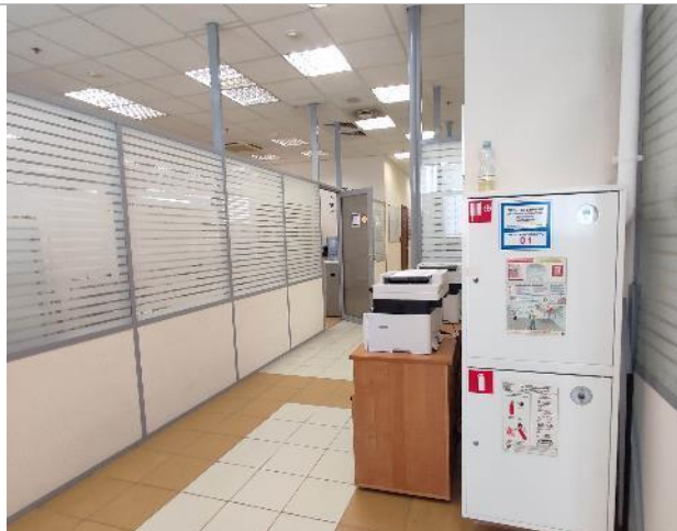
Фото 31. Состояние внутренних помещений (6 этаж)
