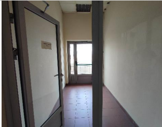
Фото 67. Состояние внутренних помещений (7 этаж)
