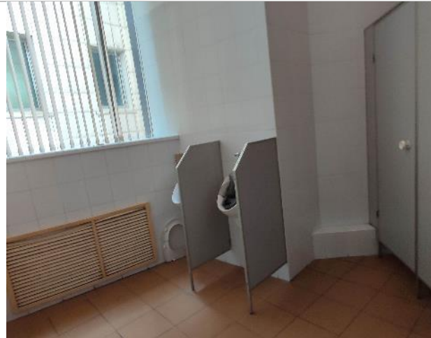
Фото 19. Состояние внутренних помещений (6 этаж)
