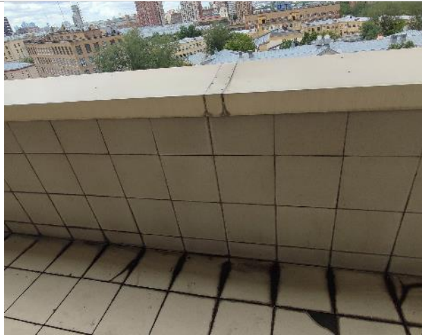
Фото 87. Состояние внутренних помещений (8 этаж)
