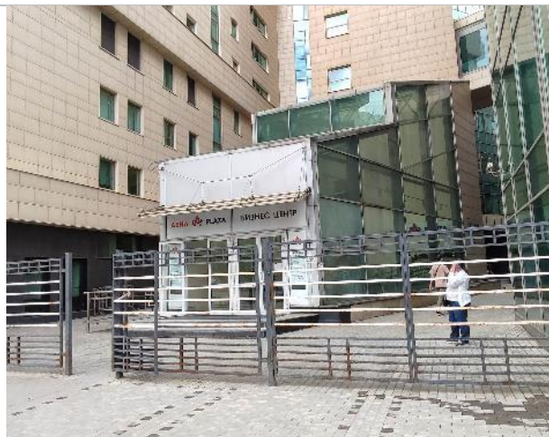
Фото 2. Подъездные пути, фасад здание, вход в здание
