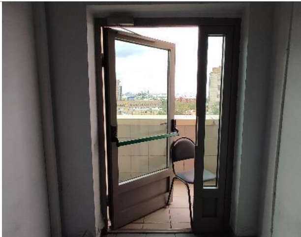
Фото 105. Состояние внутренних помещений (8 этаж)
