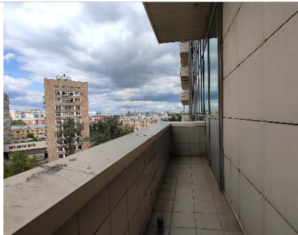
Фото 70. Состояние внутренних помещений (7 этаж)
