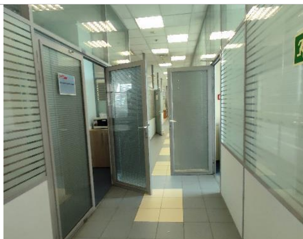
Фото 109. Состояние внутренних помещений (8 этаж)
