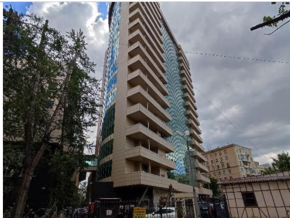
Фотография 3. Внешний вид здания
