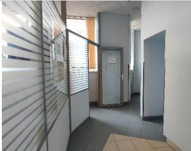
Фото 115. Состояние внутренних помещений (8 этаж)
