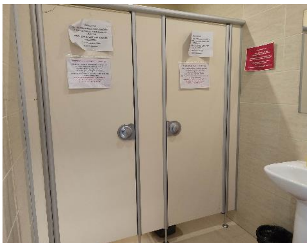
Фото 24. Состояние внутренних помещений (2 этаж)
