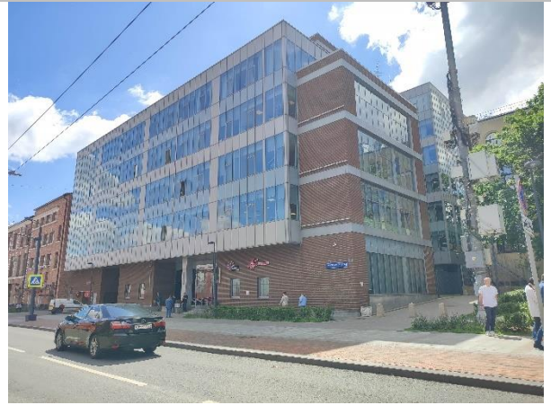
Фотография 14. Внешний вид здания
