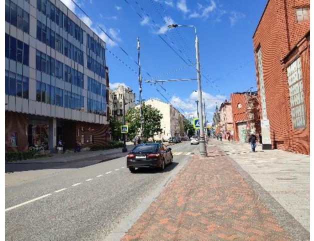
Фото 2. Подъездные пути и фасад здания
