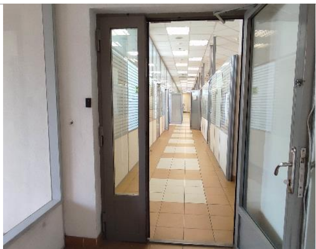
Фото 11. Состояние внутренних помещений (6 этаж)
