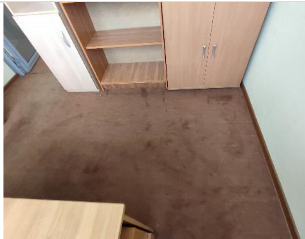
Фото 58. Состояние внутренних помещений (7 этаж)
