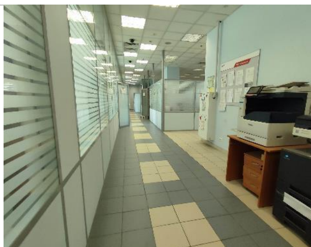
Фото 96. Состояние внутренних помещений (8 этаж)
