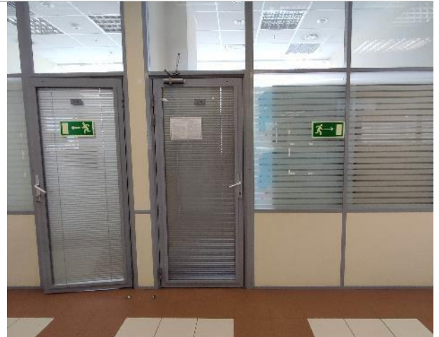
Фото 52. Состояние внутренних помещений (7 этаж)
