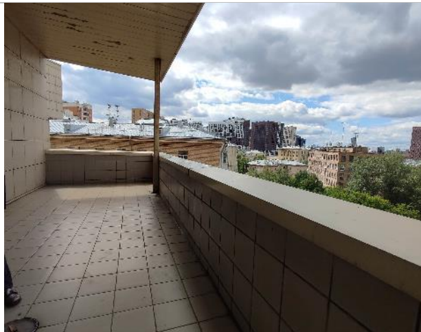
Фото 69. Состояние внутренних помещений (7 этаж)
