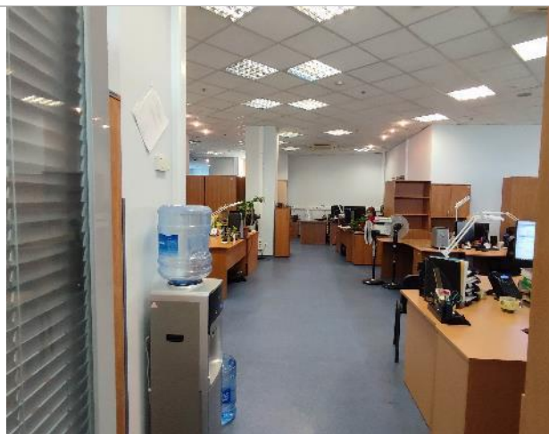
Фото 93. Состояние внутренних помещений (8 этаж)
