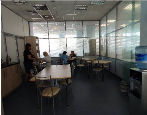
Фото 103. Состояние внутренних помещений (8 этаж)
