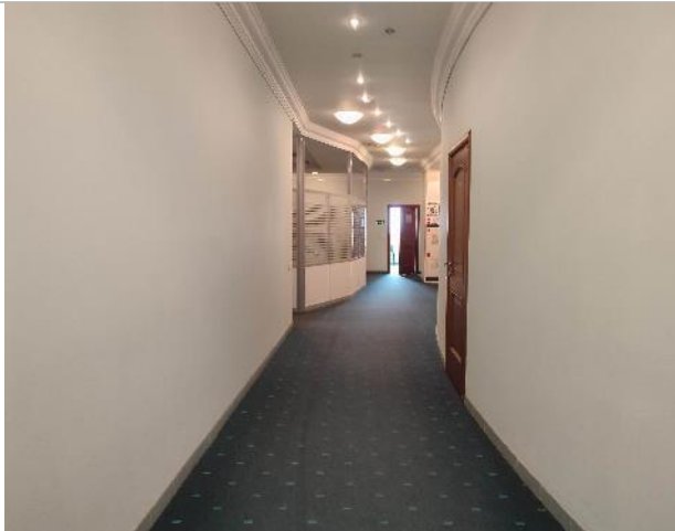
Фото 127. Состояние внутренних помещений (9 этаж)
