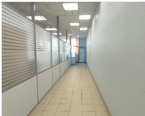
Фото 114. Состояние внутренних помещений (8 этаж)
