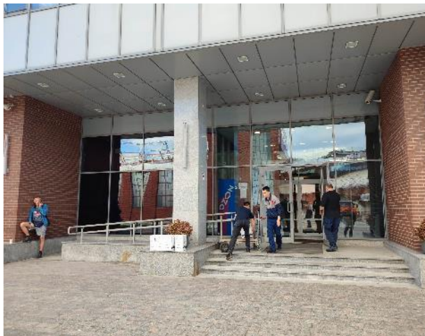
Фото 8. Подъездные пути и фасад здания
