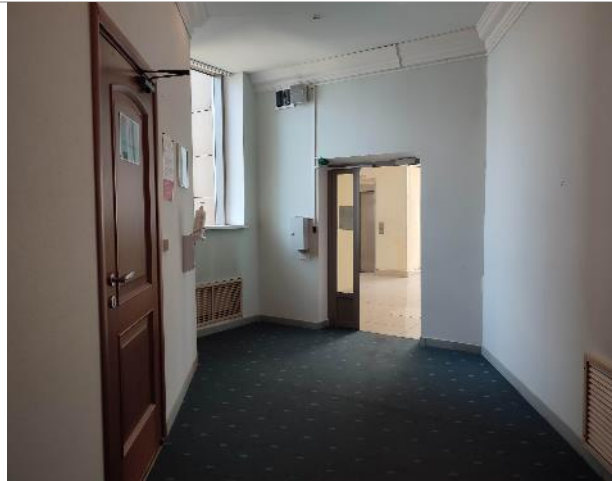
Фото 128. Состояние внутренних помещений (9 этаж)
