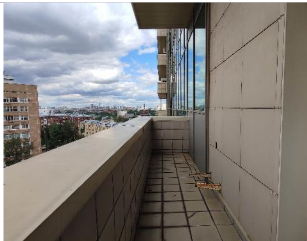
Фото 154. Состояние внутренних помещений (9 этаж)
