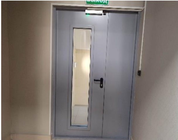
Фото 27. Состояние внутренних помещений (2 этаж)
