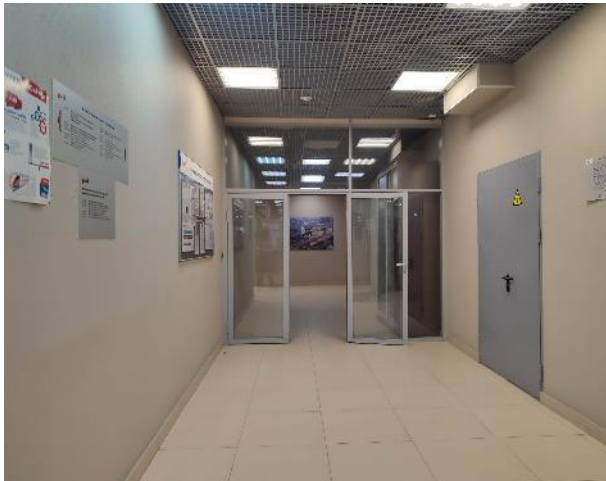
Фото 13. Состояние внутренних помещений (2 этаж)
