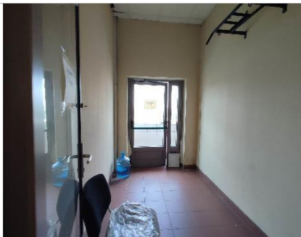
Фото 77. Состояние внутренних помещений (7 этаж)
