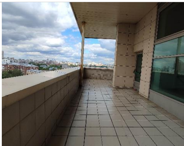
Фото 147. Состояние внутренних помещений (9 этаж)
