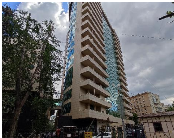
Фото 6. Подъездные пути, фасад здание
