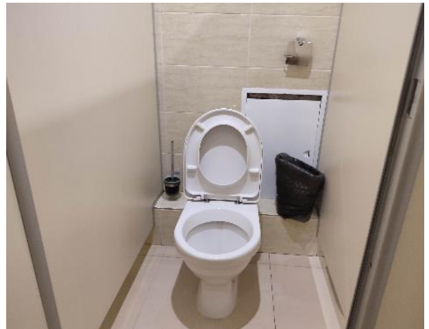
Фото 52. Состояние внутренних помещений (3 этаж)
