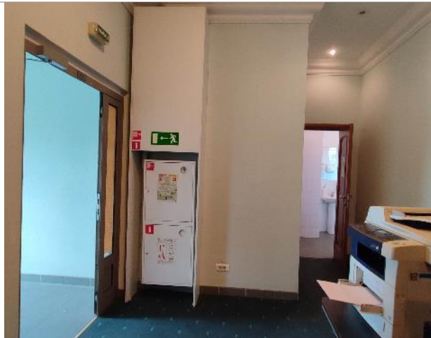
Фото 141. Состояние внутренних помещений (9 этаж)
