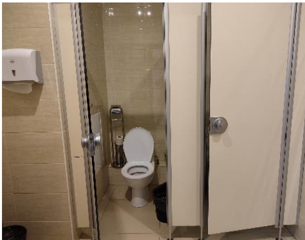
Фото 43. Состояние внутренних помещений (3 этаж)
