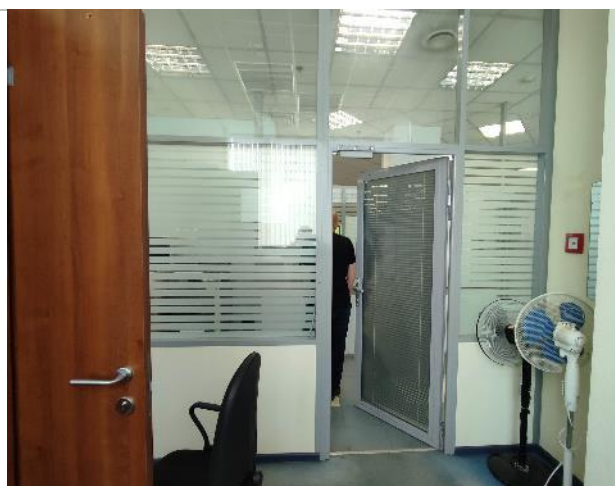
Фото 95. Состояние внутренних помещений (8 этаж)
