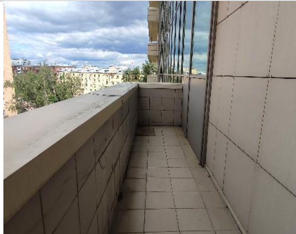
Фото 15. Состояние внутренних помещений (6 этаж)
