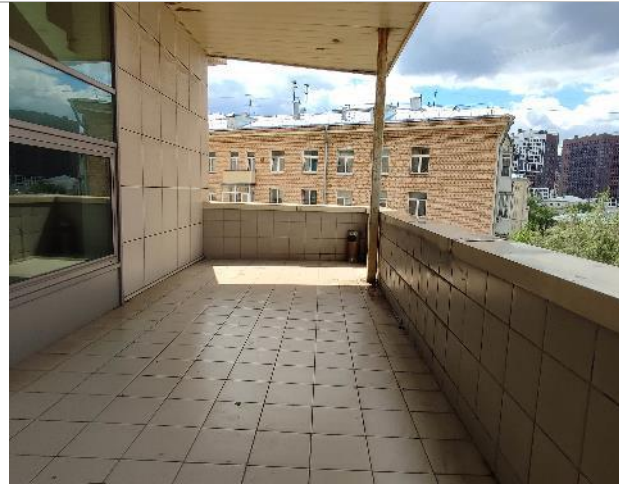
Фото 14. Состояние внутренних помещений (6 этаж)
