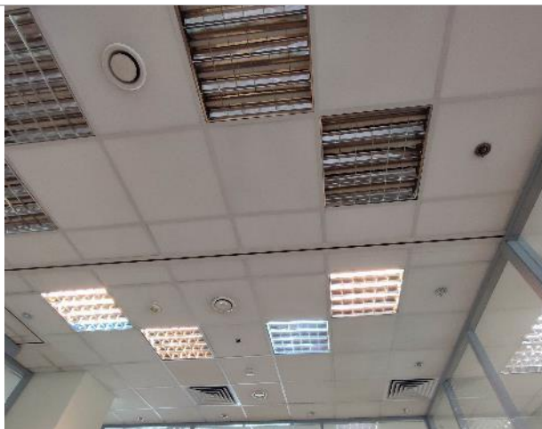
Фото 76. Состояние внутренних помещений (7 этаж)
