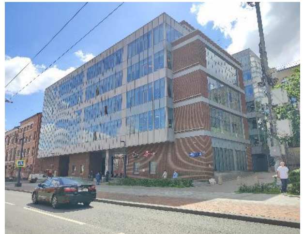
Фото 4. Подъездные пути и фасад здания
