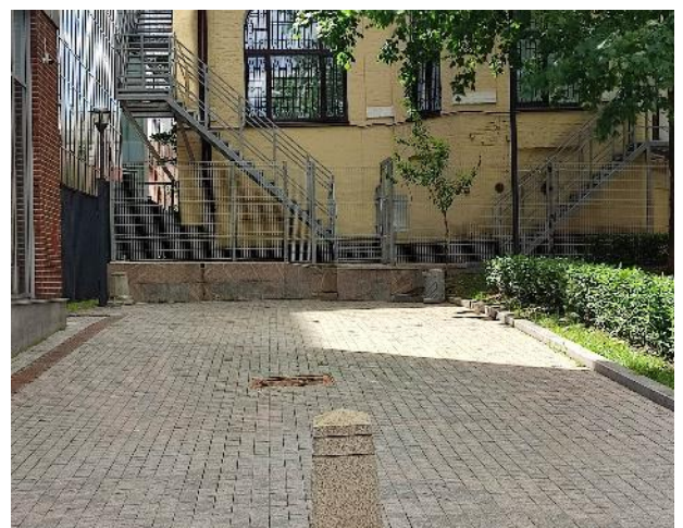
Фото 6. Подъездные пути и фасад здания
