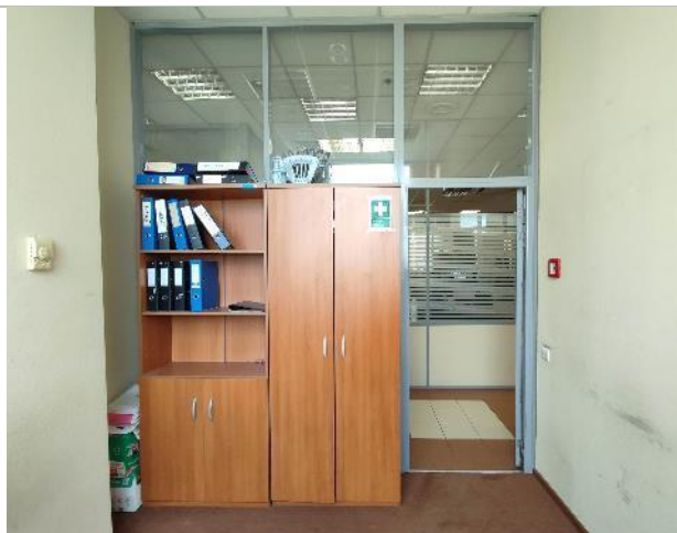
Фото 73. Состояние внутренних помещений (7 этаж)
