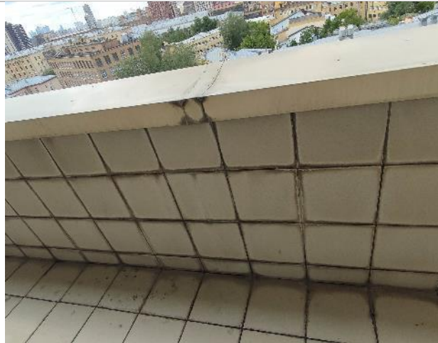
Фото 152. Состояние внутренних помещений (9 этаж)
