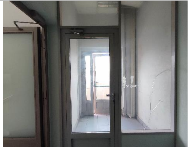
Фото 86. Состояние внутренних помещений (8 этаж)
