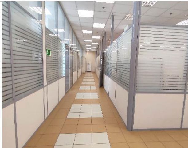
Фото 32. Состояние внутренних помещений (6 этаж)
