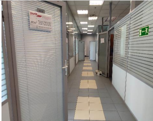
Фото 97. Состояние внутренних помещений (8 этаж)
