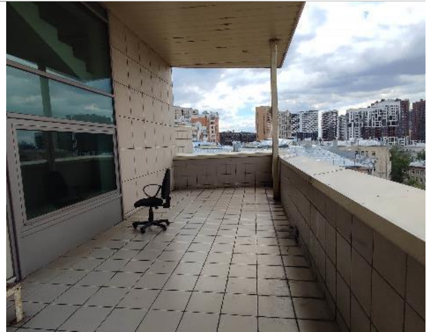
Фото 88. Состояние внутренних помещений (8 этаж)
