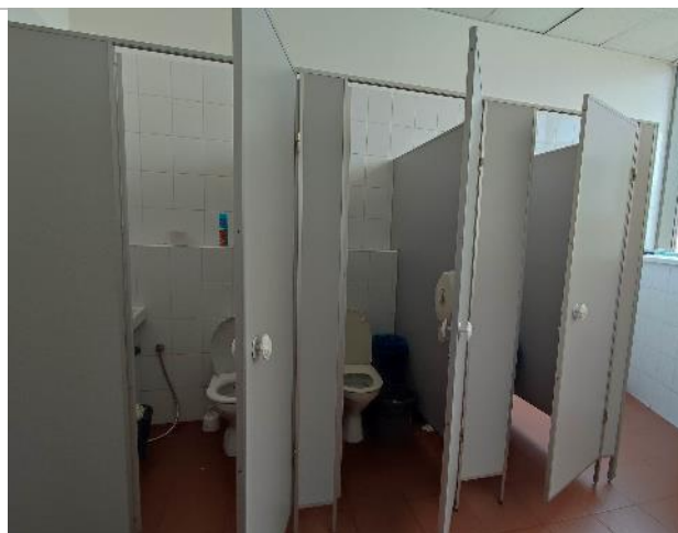
Фото 84. Состояние внутренних помещений (7 этаж)
