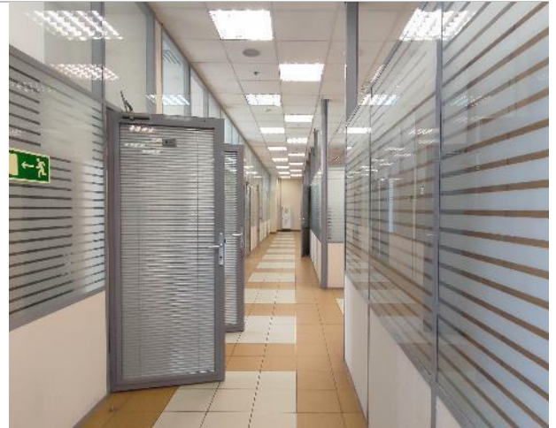
Фото 28. Состояние внутренних помещений (6 этаж)
