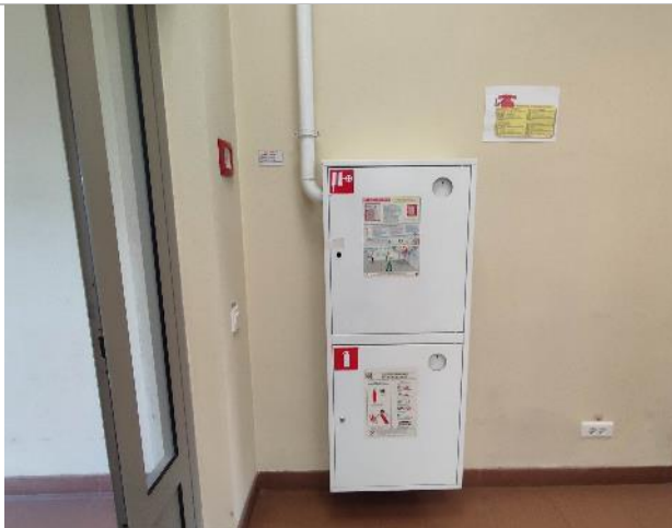
Фото 81. Состояние внутренних помещений (7 этаж)
