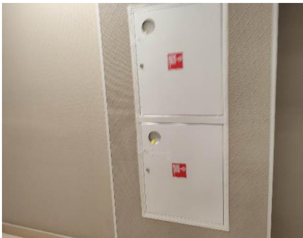
Фото 21. Состояние внутренних помещений (2 этаж)
