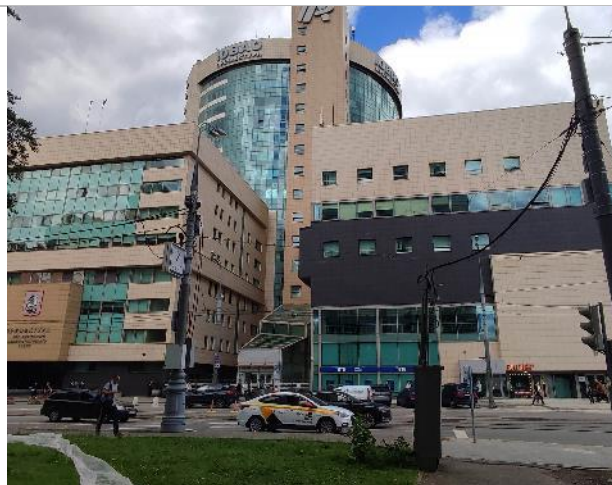
Фото 1. Подъездные пути, фасад здание
