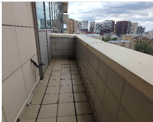
Фото 148. Состояние внутренних помещений (9 этаж)
