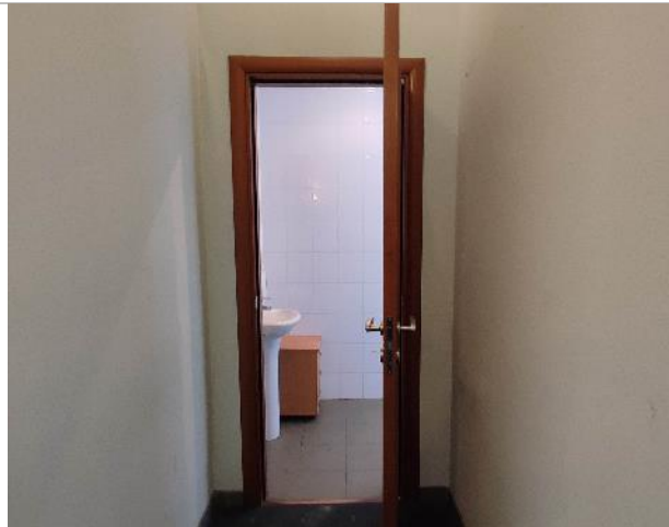
Фото 142. Состояние внутренних помещений (9 этаж)
