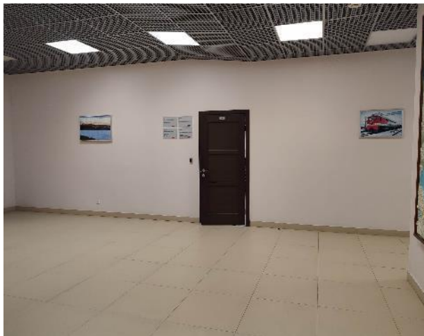
Фото 44. Состояние внутренних помещений (3 этаж)
