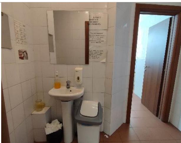
Фото 83. Состояние внутренних помещений (7 этаж)
