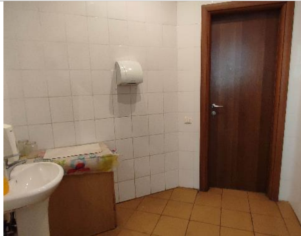
Фото 20. Состояние внутренних помещений (6 этаж)
