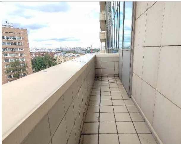
Фото 89. Состояние внутренних помещений (8 этаж)
