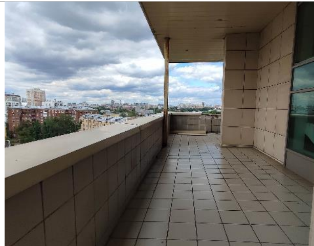
Фото 106. Состояние внутренних помещений (8 этаж)
