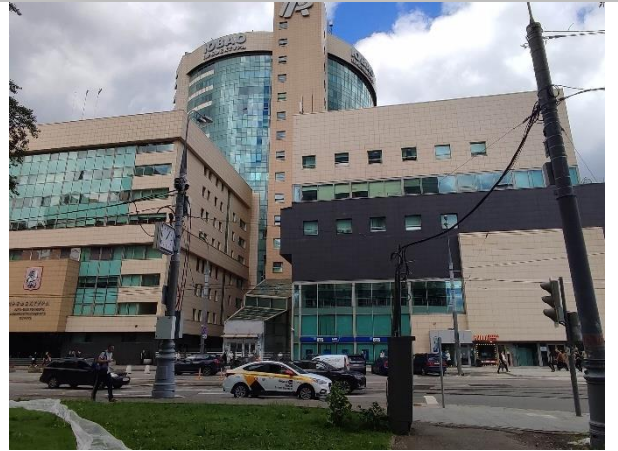
Фотография 2. Внешний вид здания
