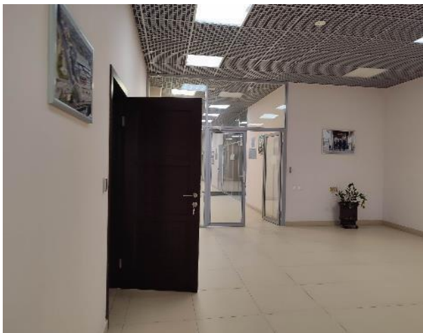
Фото 45. Состояние внутренних помещений (3 этаж)
