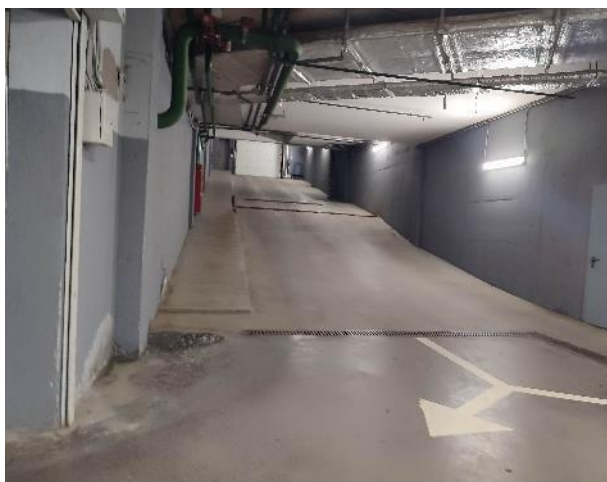
Фото 62. Состояние внутренних помещений (цокольный этаж, машино-места).
