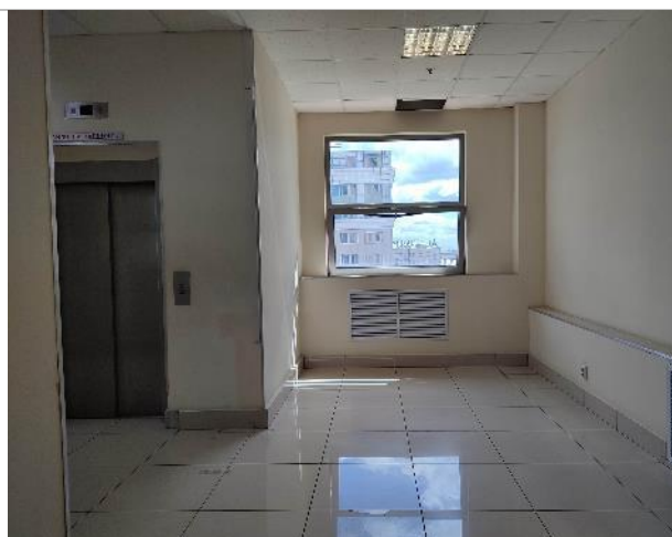
Фото 124. Состояние внутренних помещений (9 этаж)
