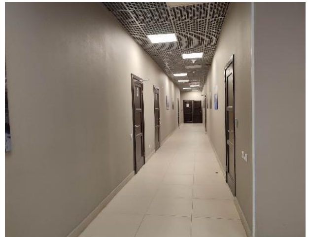
Фото 16. Состояние внутренних помещений (2 этаж)
