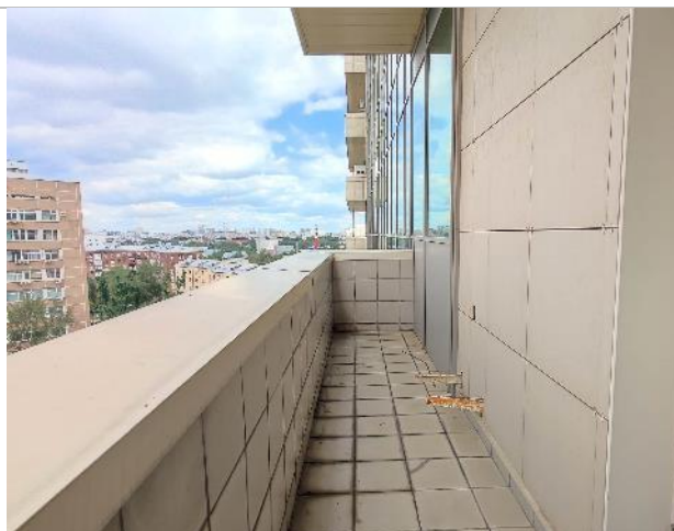
Фото 155. Состояние внутренних помещений (9 этаж)
