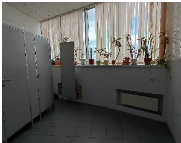
Фото 111. Состояние внутренних помещений (8 этаж)
