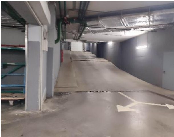
Фото 57. Состояние внутренних помещений (цокольный этаж, машино-места)
