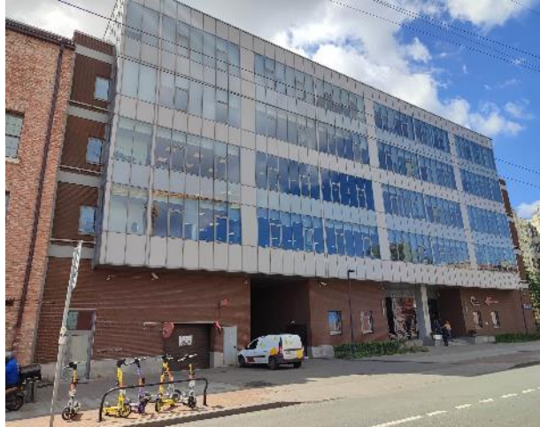
Фото 1. Подъездные пути и фасад здания
