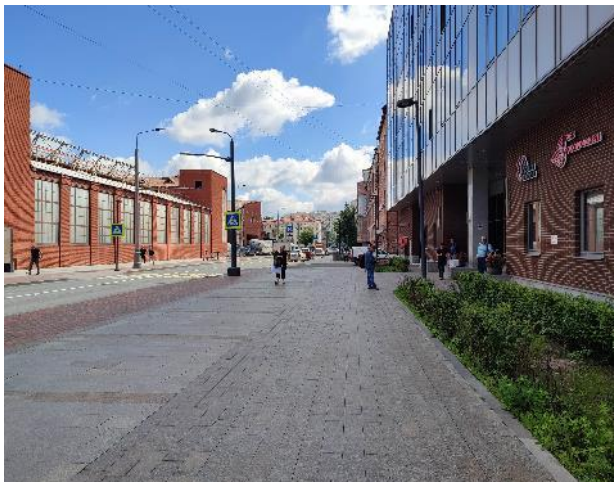
Фото 7. Подъездные пути и фасад здания
