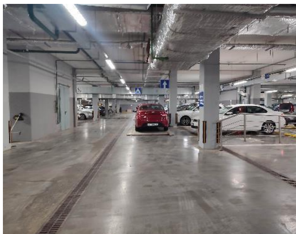
Фото 61. Состояние внутренних помещений (цокольный этаж, машино-места).
