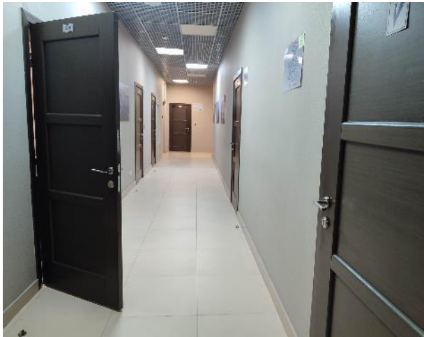
Фото 25. Состояние внутренних помещений (2 этаж)
