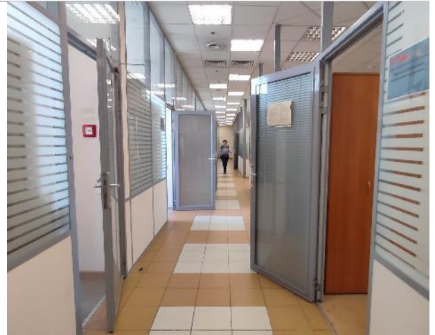
Фото 26. Состояние внутренних помещений (6 этаж)
