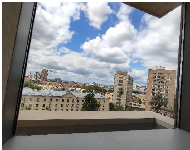
Фото 64. Состояние внутренних помещений (7 этаж)
