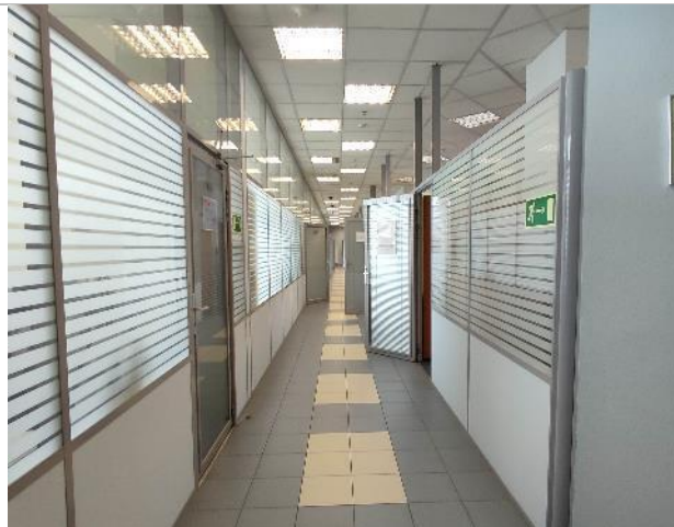
Фото 91. Состояние внутренних помещений (8 этаж)
