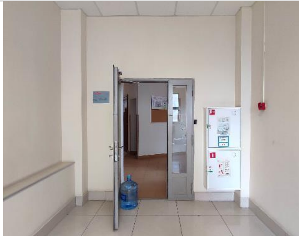
Фото 37. Состояние внутренних помещений (6 этаж)
