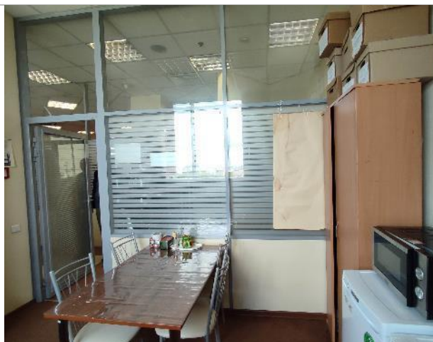
Фото 65. Состояние внутренних помещений (7 этаж)
