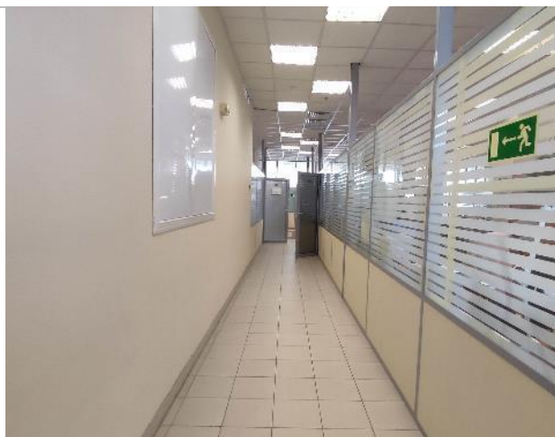
Фото 47. Состояние внутренних помещений (7 этаж)
