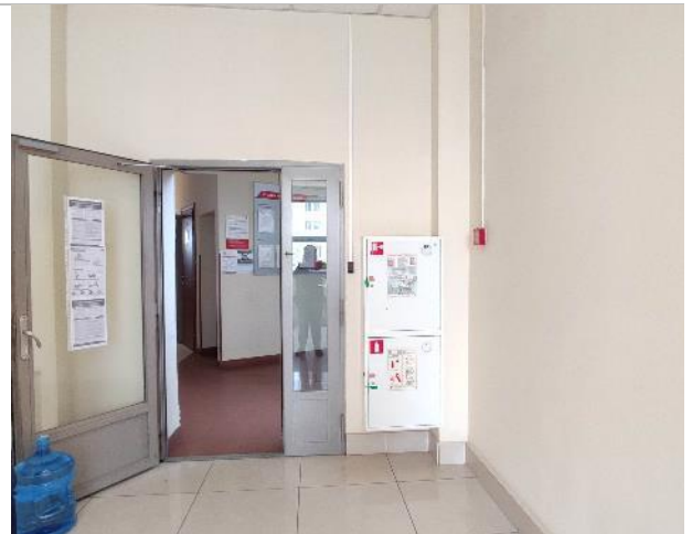
Фото 40. Состояние внутренних помещений (7 этаж)
