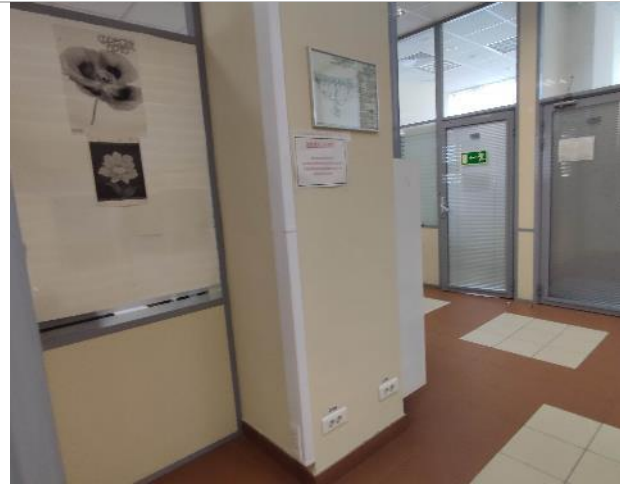
Фото 50. Состояние внутренних помещений (7 этаж)
