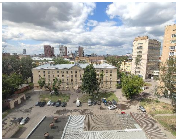
Фото 72. Состояние внутренних помещений (7 этаж)
