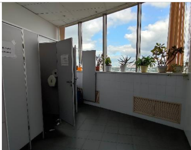
Фото 143. Состояние внутренних помещений (9 этаж)
