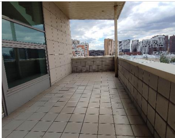
Фото 153. Состояние внутренних помещений (9 этаж)
