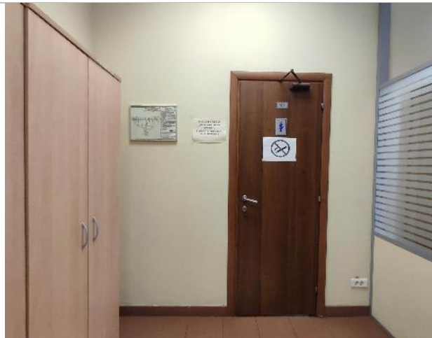
Фото 82. Состояние внутренних помещений (7 этаж)
