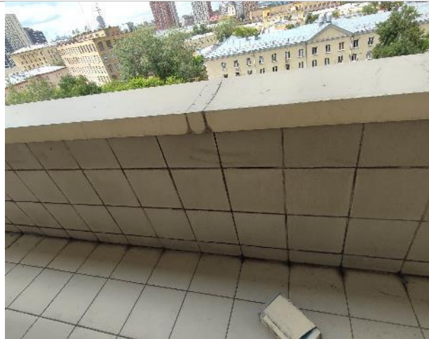
Фото 68. Состояние внутренних помещений (7 этаж)
