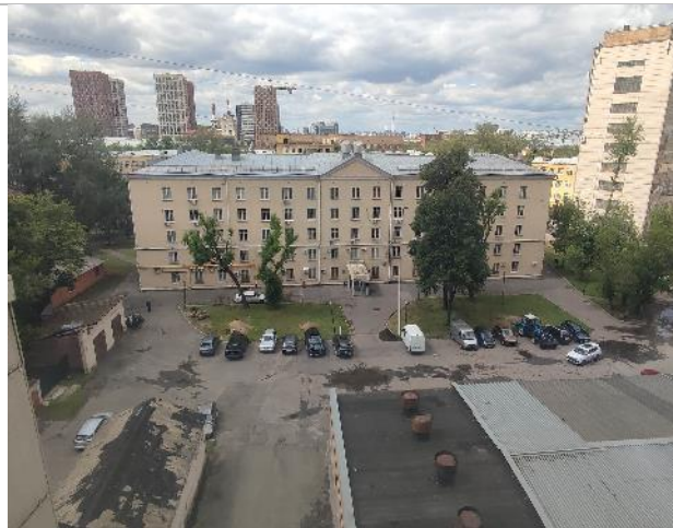
Фото 22. Состояние внутренних помещений (6 этаж)
