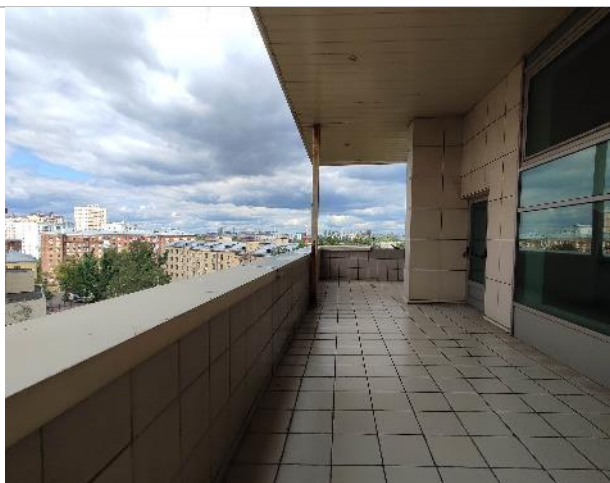
Фото 78. Состояние внутренних помещений (7 этаж)
