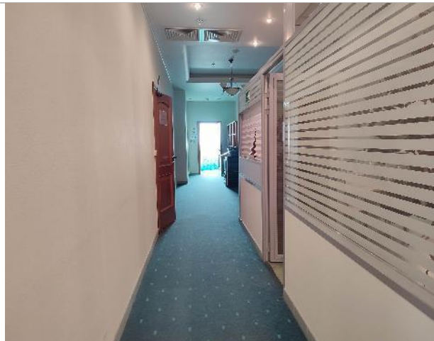
Фото 130. Состояние внутренних помещений (9 этаж)
