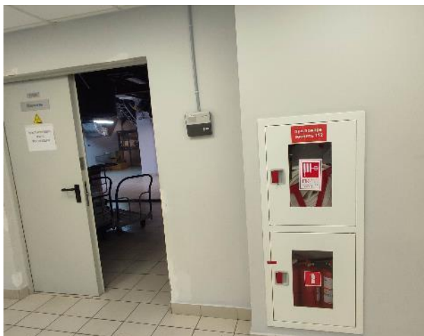
Фото 64. Внутренние помещения (14 этаж)
