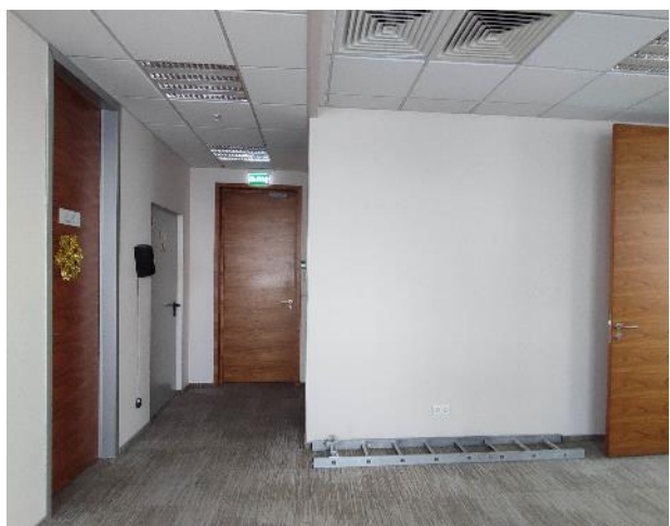
Фото 99. Внутренние помещения (21 этаж)
