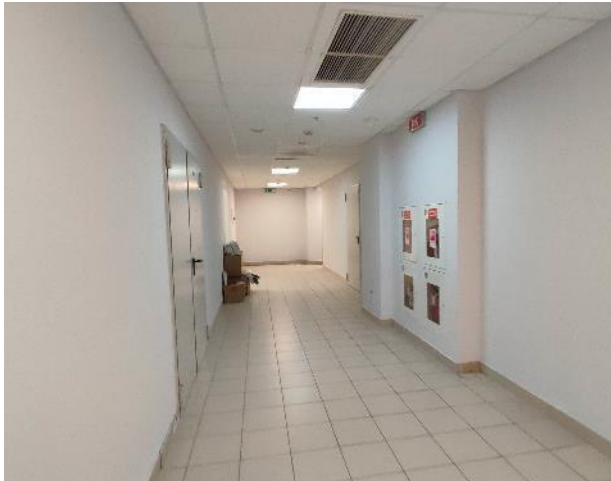
Фото 169. Внутренние помещения (-5 этаж)
