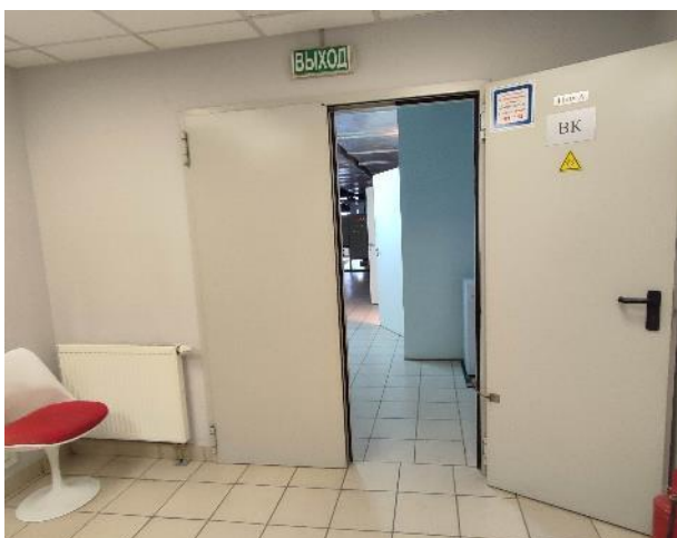
Фото 76. Внутренние помещения (14 этаж)
