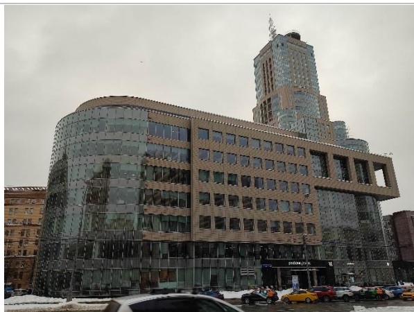
Фотография 1. Внешний вид здания
