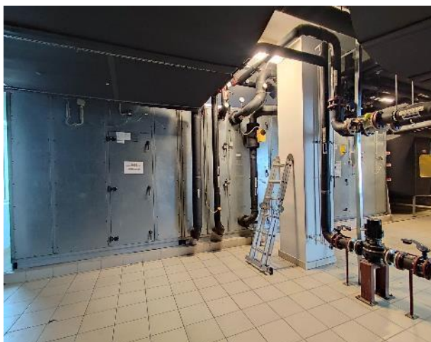
Фото 88. Внутренние помещения (14 этаж)
