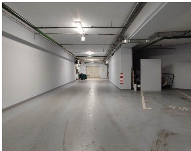
Фото 142. Внутренние помещения (-1 этаж)
