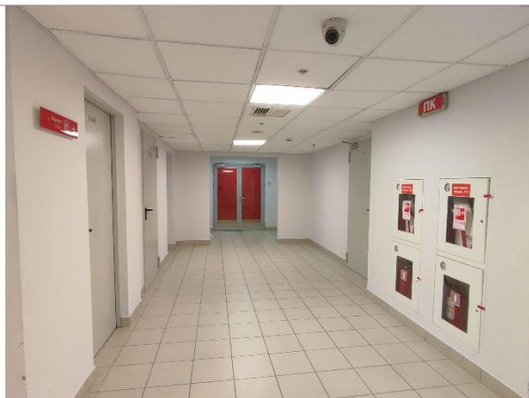
Фотография 3. Внутреннее состояние помещений -4 этажа
