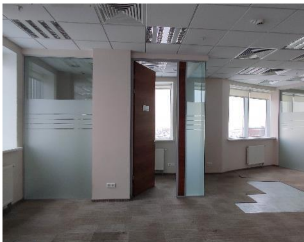
Фото 104. Внутренние помещения (21 этаж)
