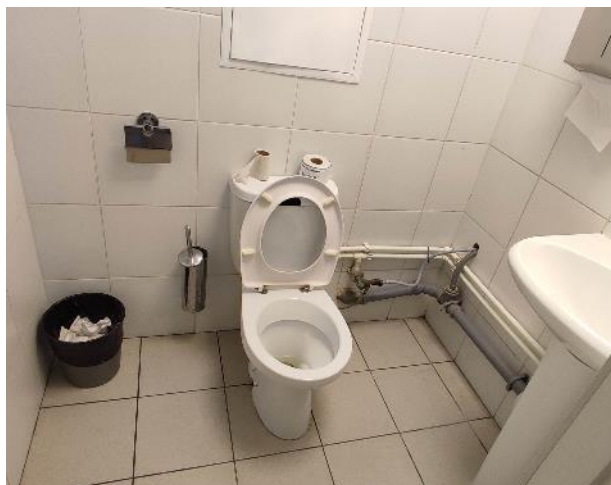
Фото 71. Внутренние помещения (14 этаж)
