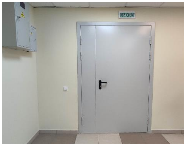
Фото 27. Внутренние помещения (1 этаж)
