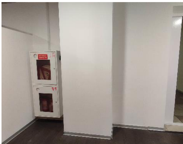
Фото 38. Внутренние помещения (1 этаж)
