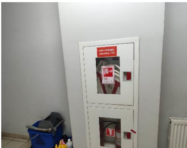
Фото 74. Внутренние помещения (14 этаж)
