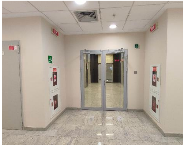
Фото 55. Внутренние помещения (3 этаж)
