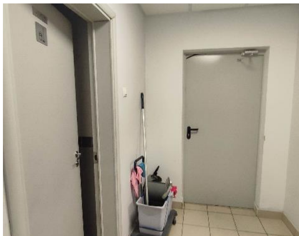
Фото 167. Внутренние помещения (-5 этаж)
