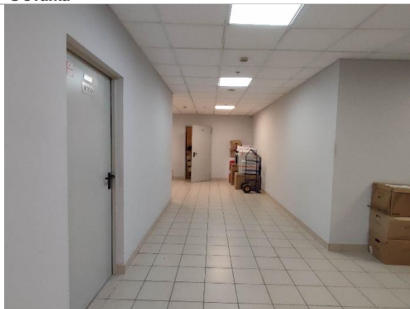
Фотография 4. Внутреннее состояние помещений -3 этажа
