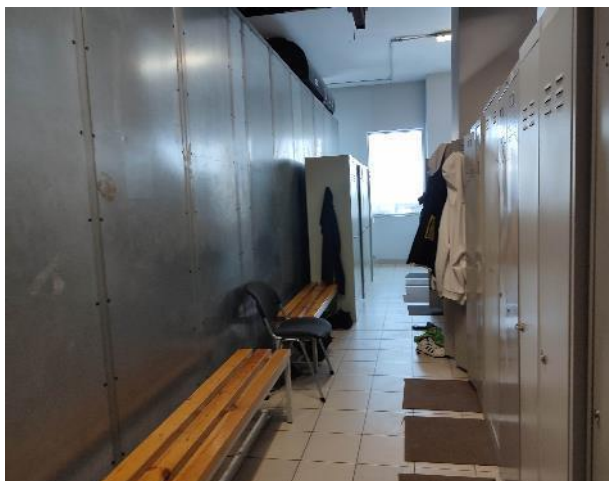
Фото 86. Внутренние помещения (14 этаж)
