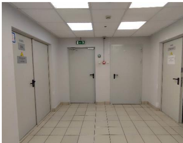
Фото 63. Внутренние помещения (14 этаж)
