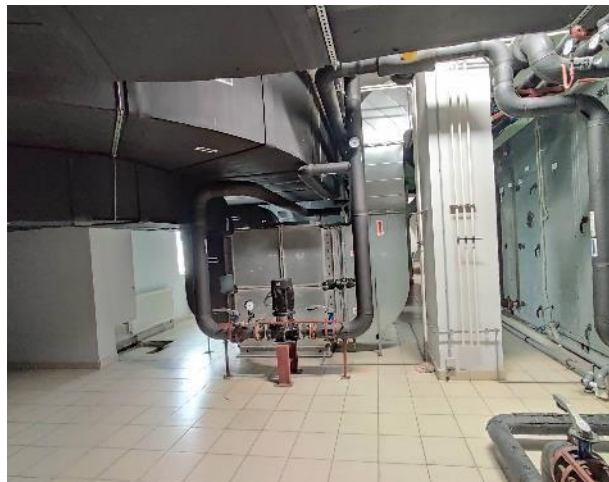
Фото 80. Внутренние помещения (14 этаж)
