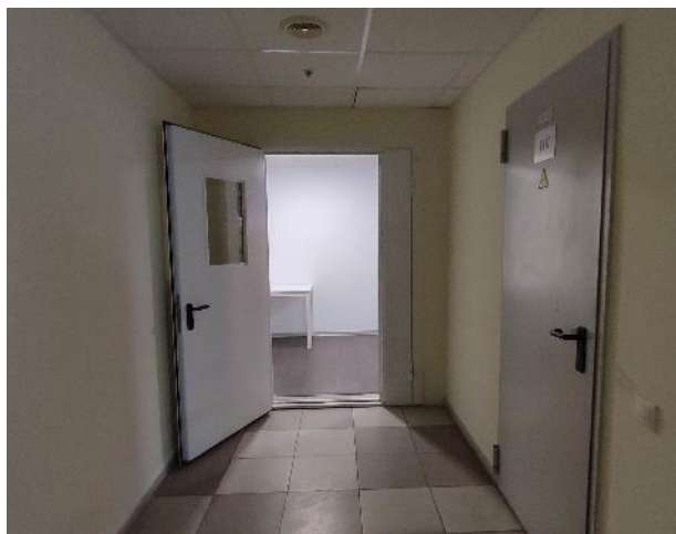
Фото 33. Внутренние помещения (1 этаж)
