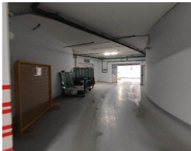
Фото 144. Внутренние помещения (-1 этаж)
