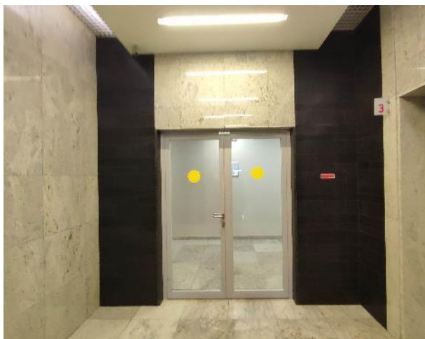
Фото 92. Внутренние помещения (21 этаж)
