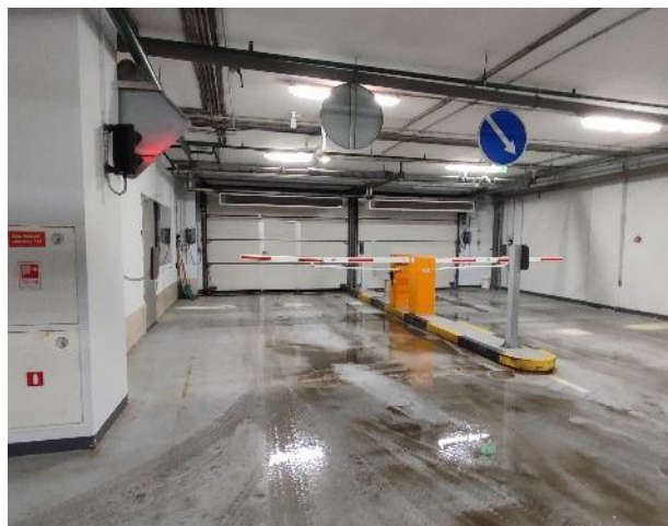
Фото 146. Внутренние помещения (-1 этаж)
