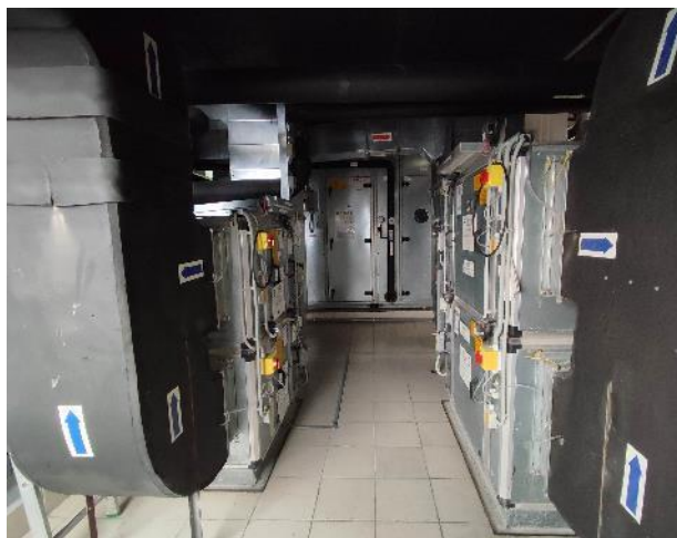
Фото 81. Внутренние помещения (14 этаж)
