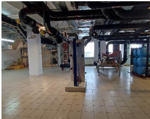
Фото 67. Внутренние помещения (14 этаж)
