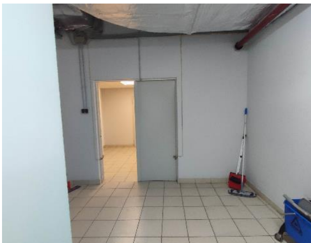
Фото 73. Внутренние помещения (14 этаж)
