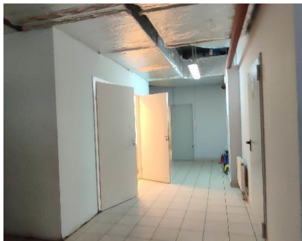
Фото 70. Внутренние помещения (14 этаж)
