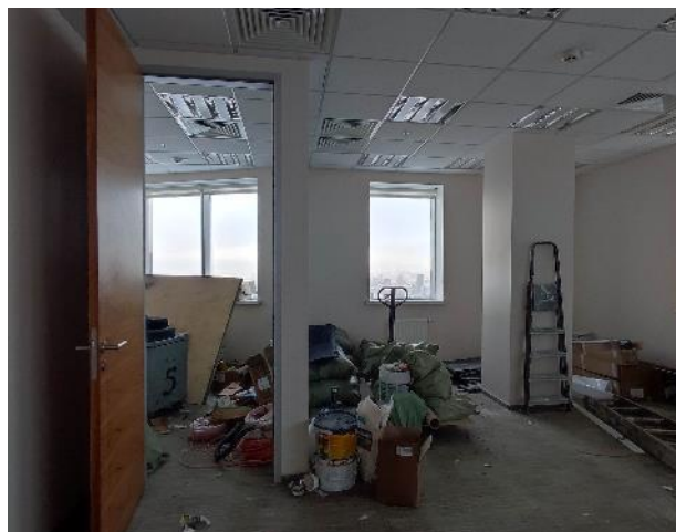
Фото 98. Внутренние помещения (21 этаж)
