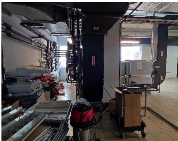
Фото 66. Внутренние помещения (14 этаж)
