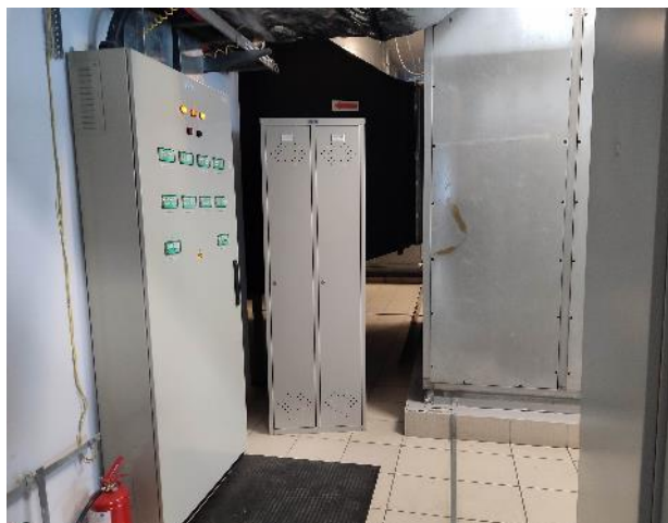
Фото 85. Внутренние помещения (14 этаж)
