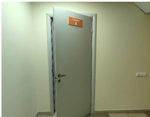
Фото 29. Внутренние помещения (1 этаж)
