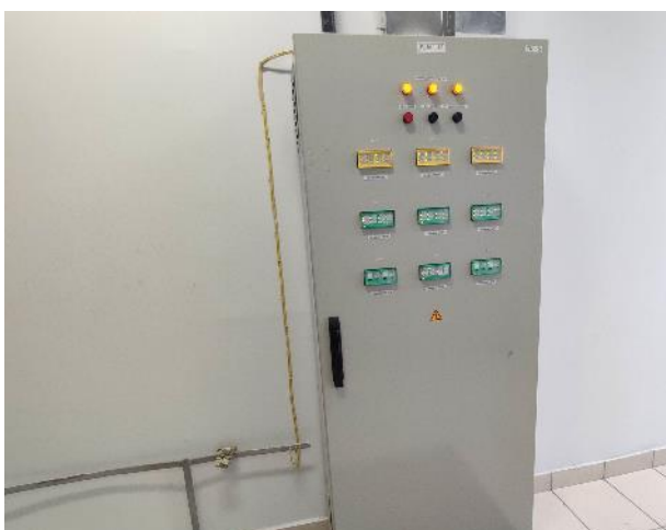
Фото 78. Внутренние помещения (14 этаж)
