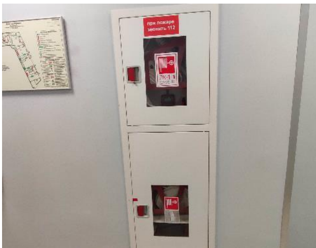
Фото 125. Внутренние помещения (-1 этаж)
