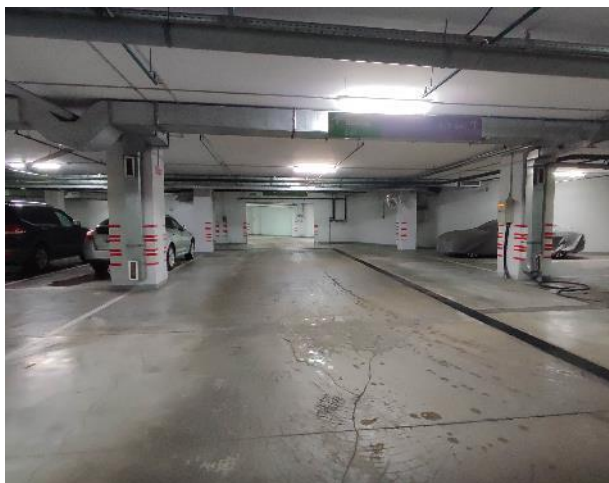
Фото 162. Внутренние помещения (-5 этаж)
