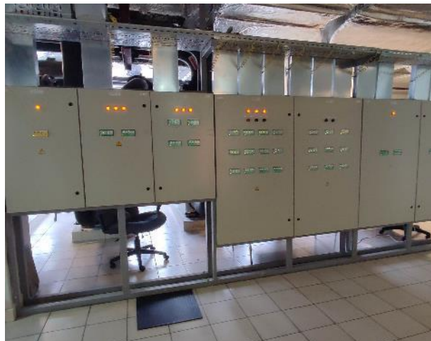
Фото 68. Внутренние помещения (14 этаж)
