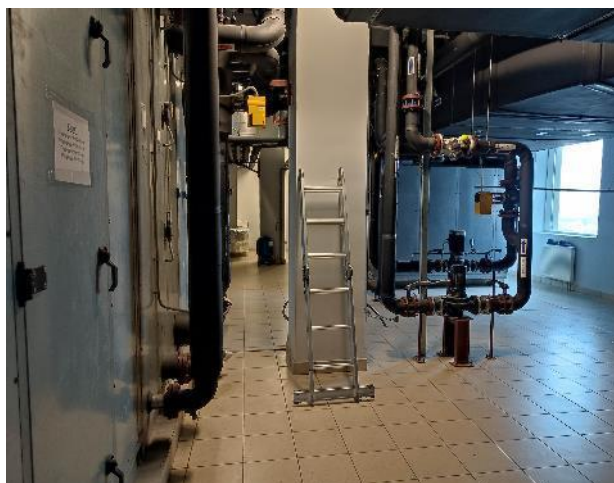
Фото 87. Внутренние помещения (14 этаж)
