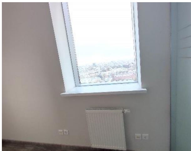
Фото 105. Внутренние помещения (21 этаж)
