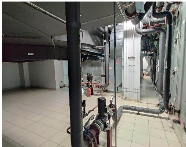
Фото 79. Внутренние помещения (14 этаж)
