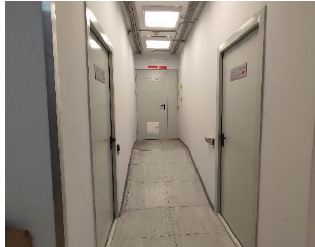
Фото 170. Внутренние помещения (-5 этаж)
