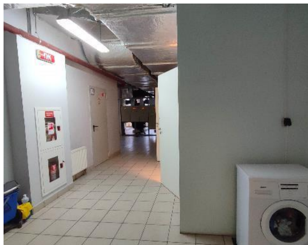
Фото 82. Внутренние помещения (14 этаж)
