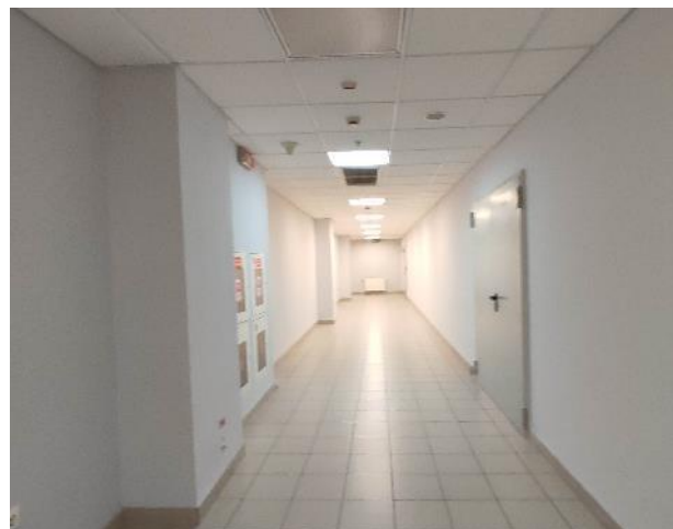
Фото 172. Внутренние помещения (-5 этаж)
