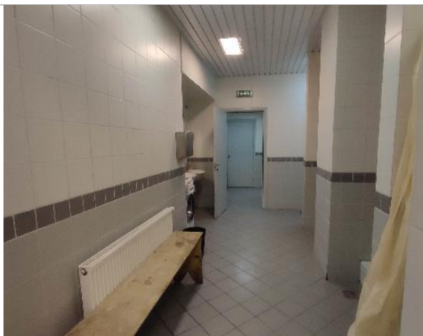
Фото 26. Внутренние помещения -3 этаж
