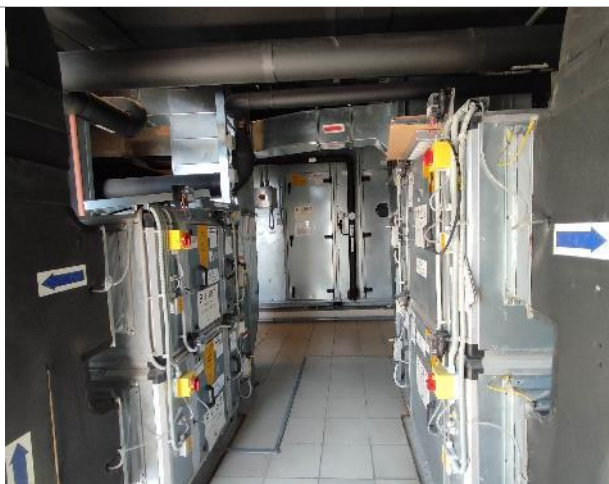
Фото 134. Внутренние помещения 14 этаж
