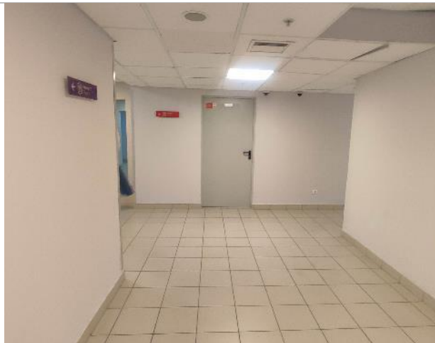
Фото 45. Внутренние помещения -5 этаж
