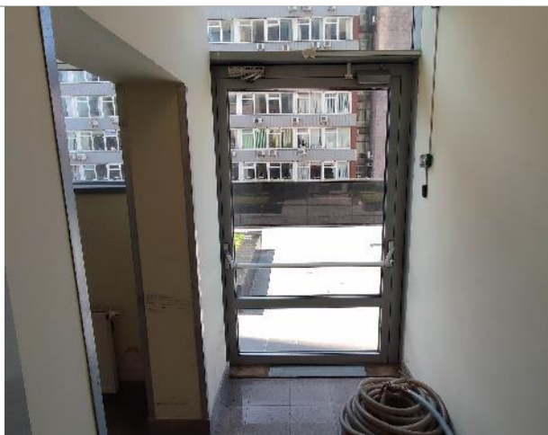
Фото 74. Внутренние помещения 2 этаж
