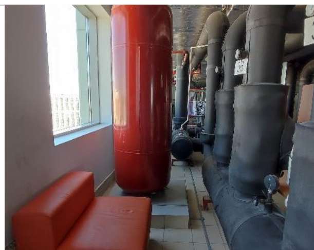
Фото 120. Внутренние помещения 14 этаж
