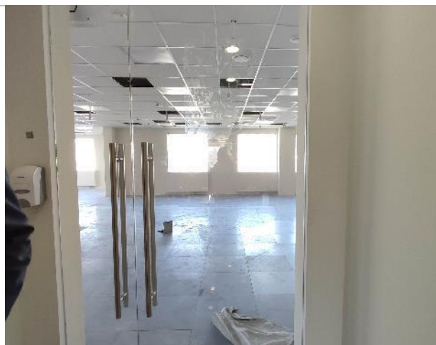
Фото 107. Внутренние помещения 10 этаж
