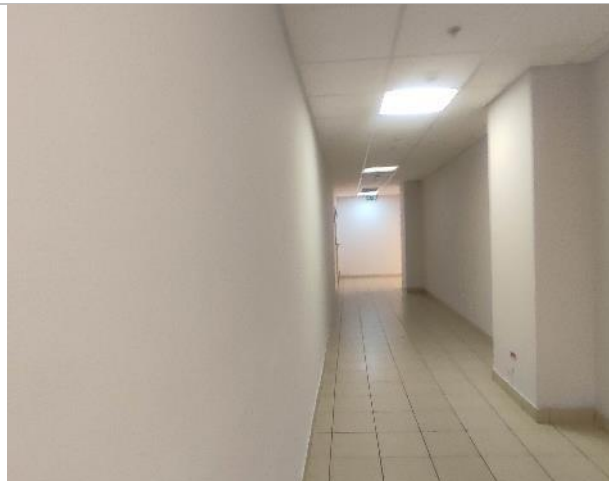
Фото 44. Внутренние помещения -5 этаж
