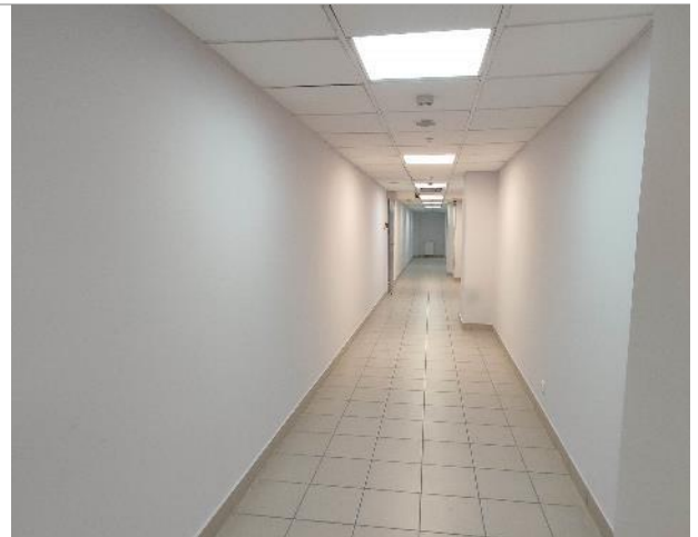
Фото 34. Внутренние помещения -4 этаж
