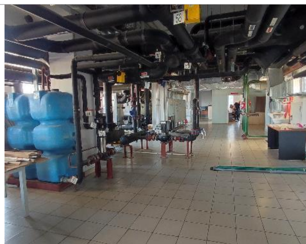
Фото 118. Внутренние помещения 14 этаж.
