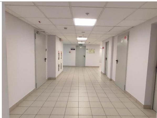
Фотография 3. Внутреннее состояние помещений -4 этажа
