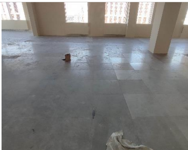
Фото 110. Внутренние помещения 10 этаж
