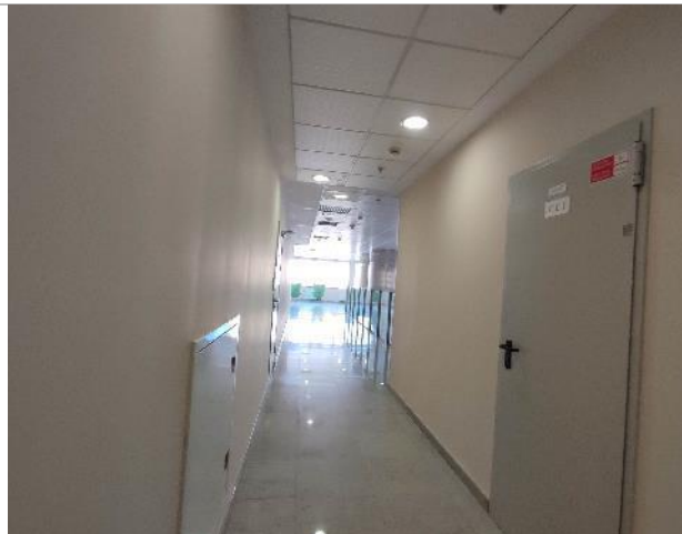
Фото 79. Внутренние помещения 3 этаж
