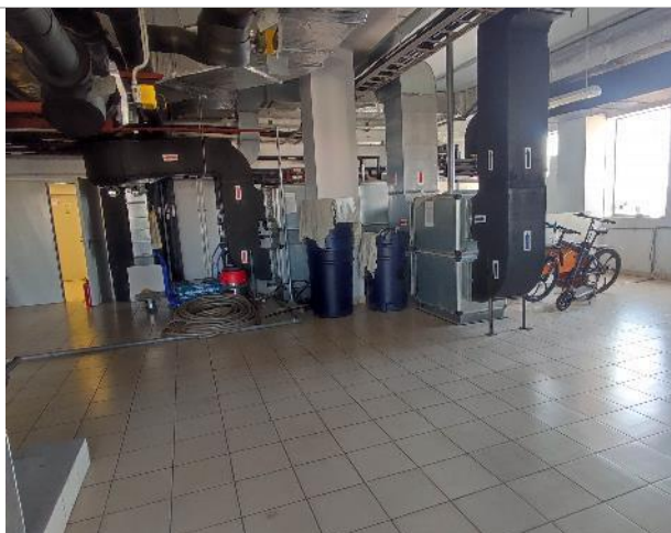
Фото 122. Внутренние помещения 14 этаж
