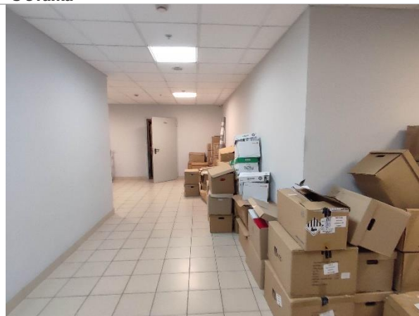
Фотография 4. Внутреннее состояние помещений -3 этажа
