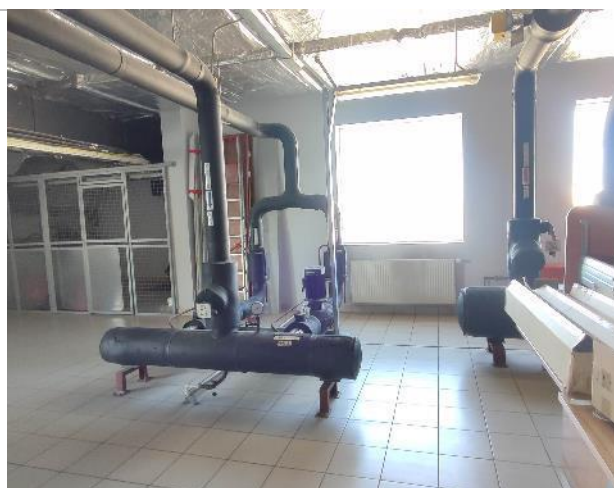
Фото 119. Внутренние помещения 14 этаж
