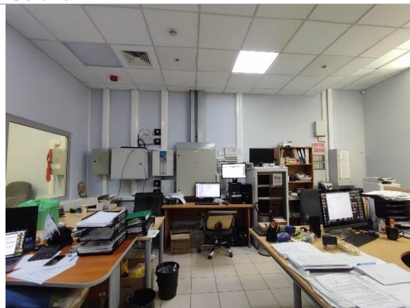
Фотография 6. Внутреннее состояние помещений -1 этажа
