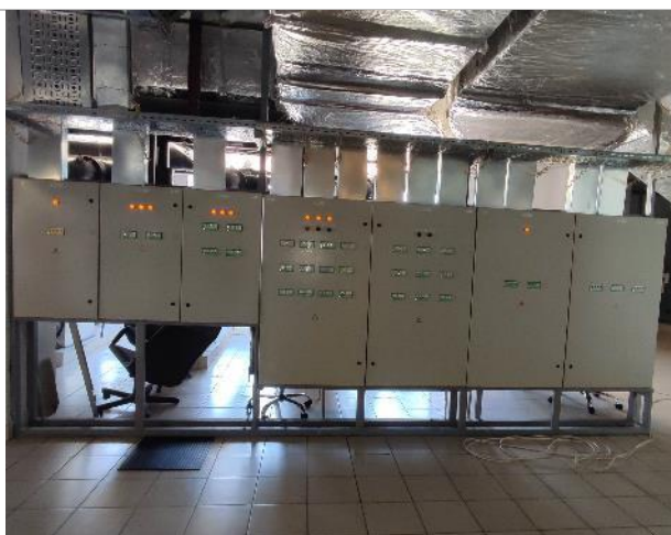
Фото 124. Внутренние помещения 14 этаж
