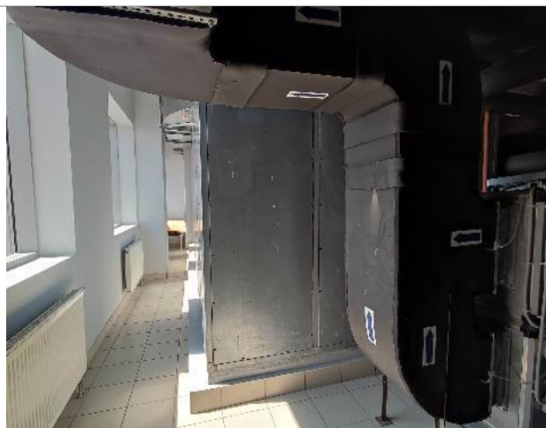
Фото 133. Внутренние помещения 14 этаж
