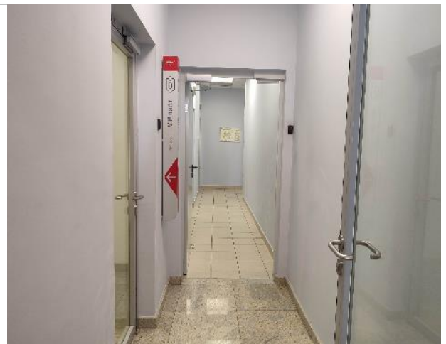
Фото 72. Внутренние помещения 2 этаж
