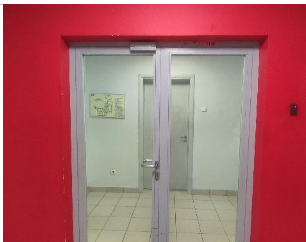
Фото 47. Внутренние помещения -5 этаж
