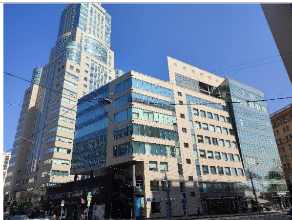
Фотография 1. Внешний вид здания
