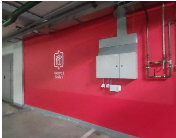
Фото 43. Внутренние помещения -5 этаж
