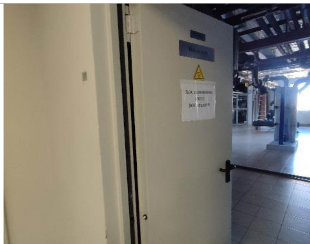
Фото 115. Внутренние помещения 14 этаж
