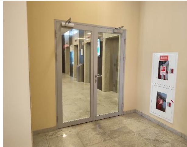
Фото 69. Внутренние помещения 2 этаж
