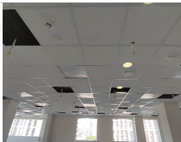
Фото 111. Внутренние помещения 10 этаж
