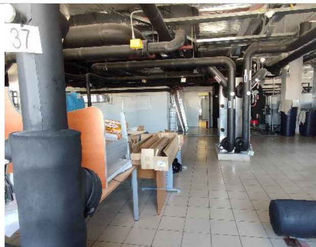
Фото 121. Внутренние помещения 14 этаж
