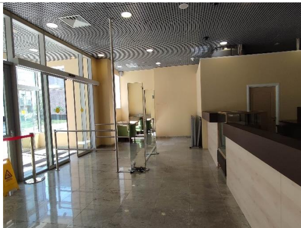
Фотография 8. Внутреннее состояние помещений 2 этажа
