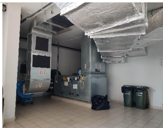
Фото 125. Внутренние помещения 14 этаж
