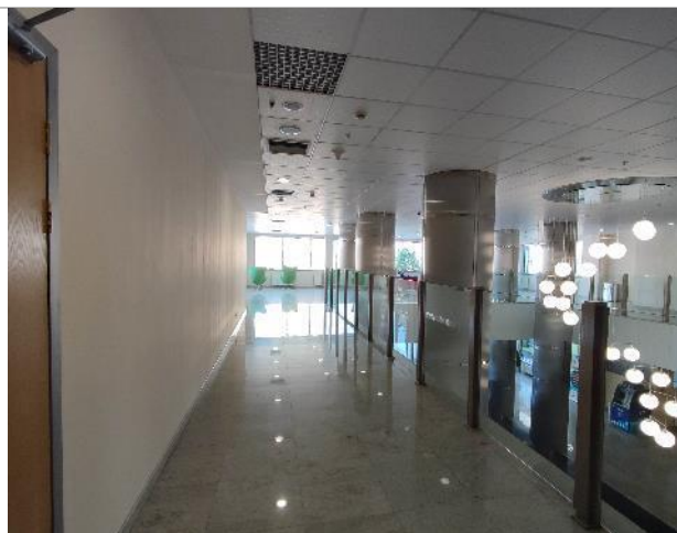
Фото 81. Внутренние помещения 3 этаж
