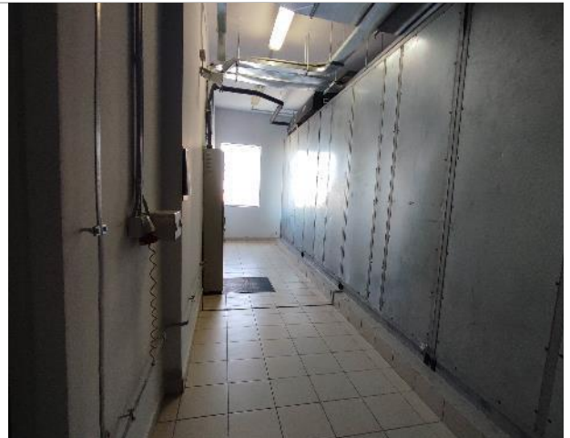
Фото 130. Внутренние помещения 14 этаж
