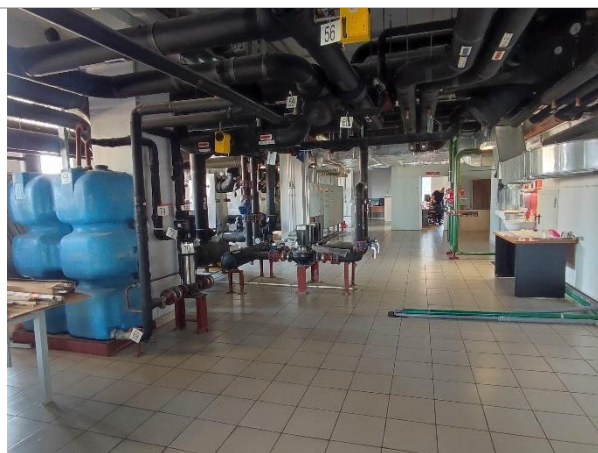
Фотография 13. Внутреннее состояние помещений 14 этажа
