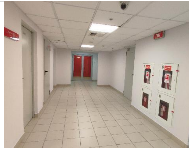
Фото 33. Внутренние помещения -4 этаж
