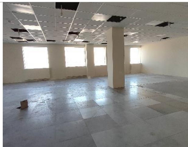
Фото 109. Внутренние помещения 10 этаж
