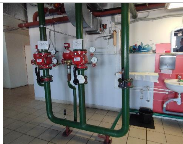
Фото 123. Внутренние помещения 14 этаж
