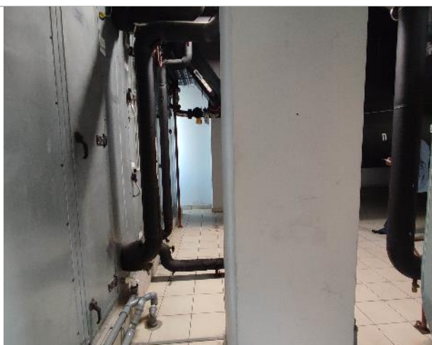
Фото 136. Внутренние помещения 14 этаж
