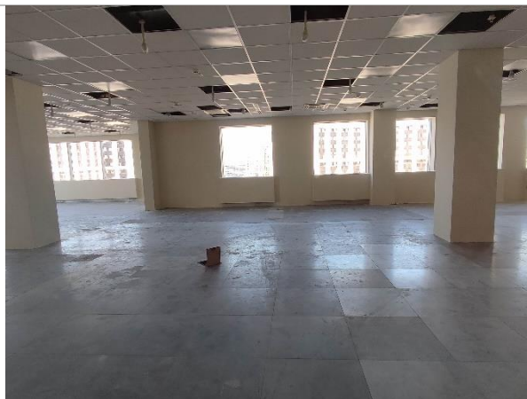
Фотография 12. Внутреннее состояние помещений 10 этажа
