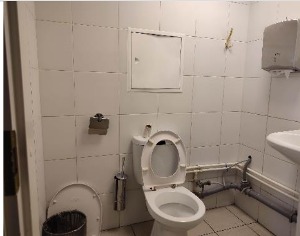
Фото 127. Внутренние помещения 14 этаж
