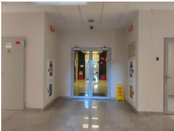
Фотография 11. Внутреннее состояние помещений 9 этажа
