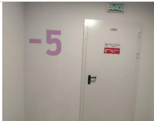
Фото 37. Внутренние помещения -5 этаж
