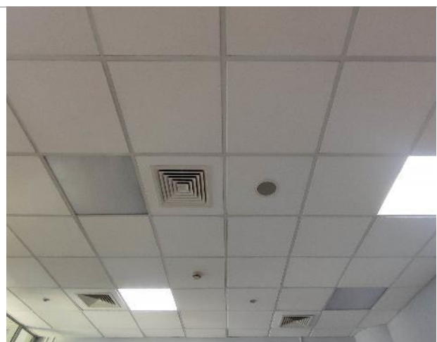
Фото 5. Внутренние помещения -1 этаж
