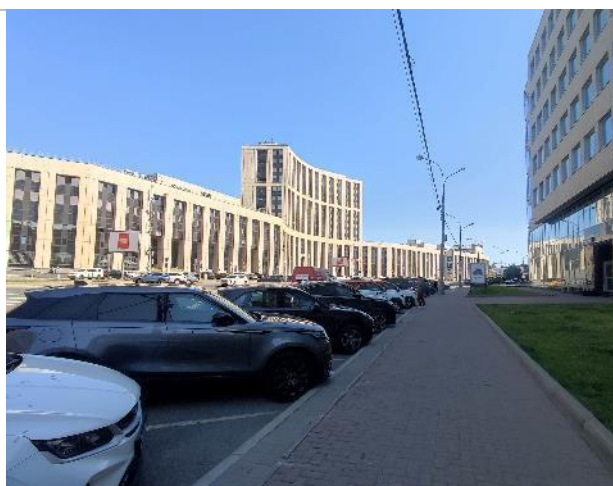
Фото 155. Подъездные пути, парковка
