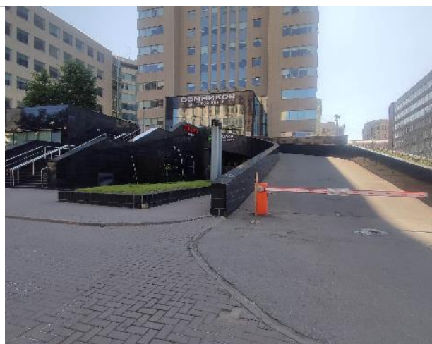
Фото 154. Подъездные пути, парковка
