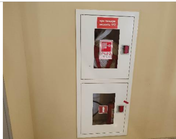
Фото 71. Внутренние помещения 2 этаж
