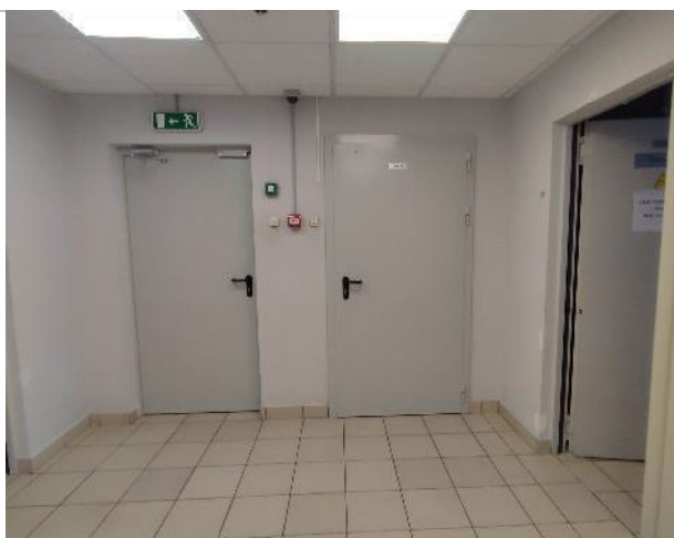
Фото 114. Внутренние помещения 14 этаж
