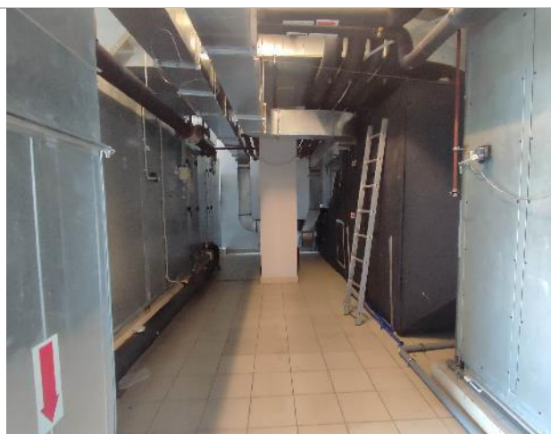
Фото 135. Внутренние помещения 14 этаж
