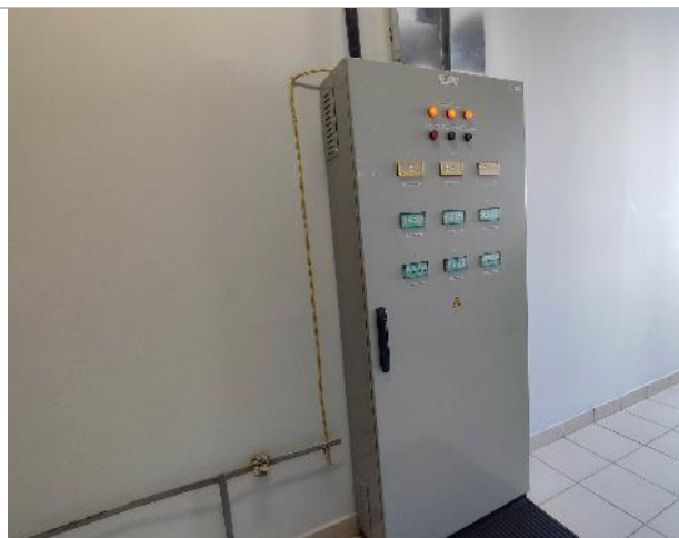
Фото 131. Внутренние помещения 14 этаж
