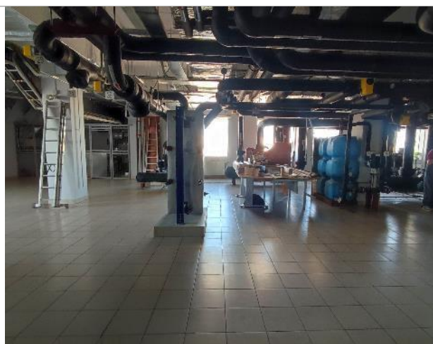
Фото 117. Внутренние помещения 14 этаж.
