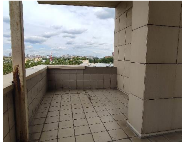
Фото 50. Внутренние помещения 7 этажа
