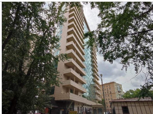
Фотография 3. Внешний вид здания
