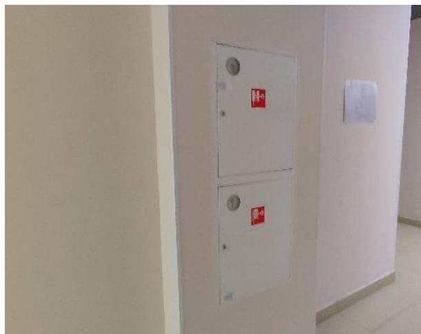
Фото 44. Внутренние помещения 3 этажа
