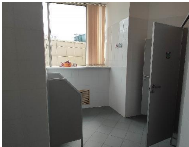
Фото 79. Внутренние помещения 8 этажа
