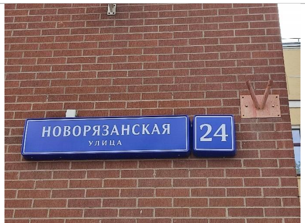
Фотография 14. Внешний вид здания
