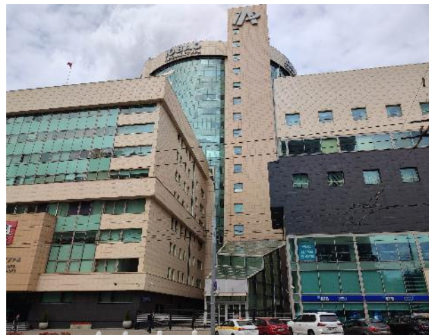
Фото 6. Подъездные пути и фасад здания
