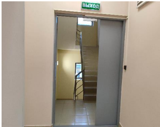
Фото 51. Внутренние помещения 3 этажа
