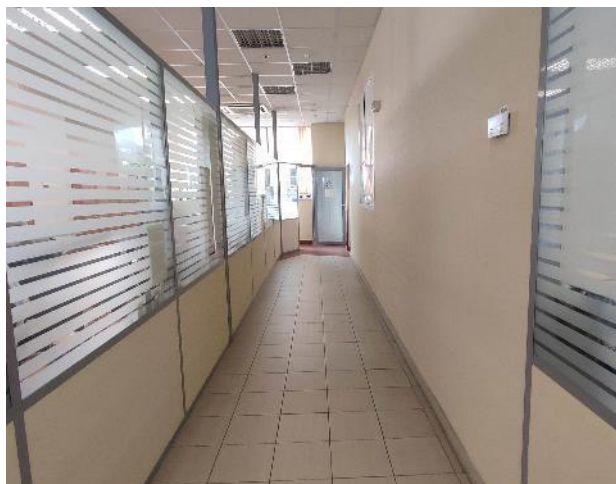
Фото 67. Внутренние помещения 7 этажа
