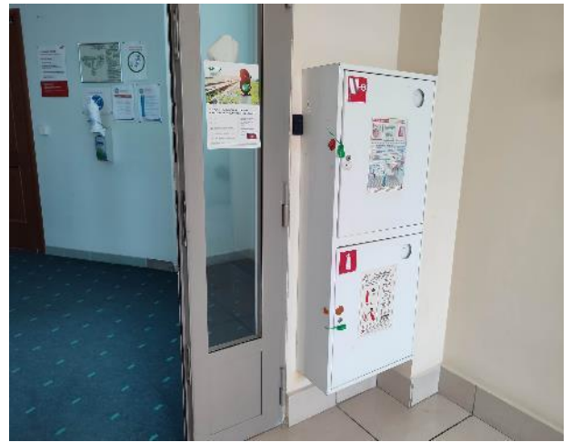
Фото 100. Внутренние помещения 9 этажа
