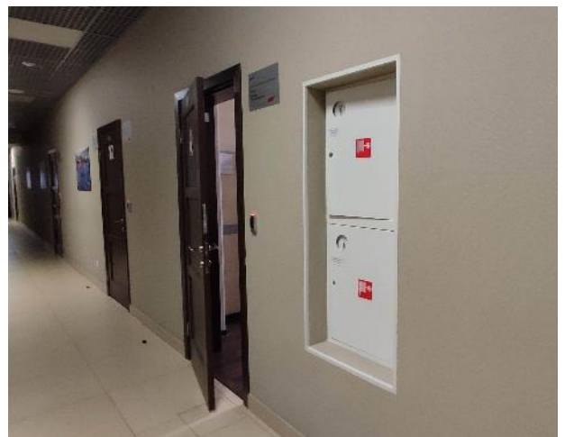
Фото 18. Внутренние помещения 2 этажа
