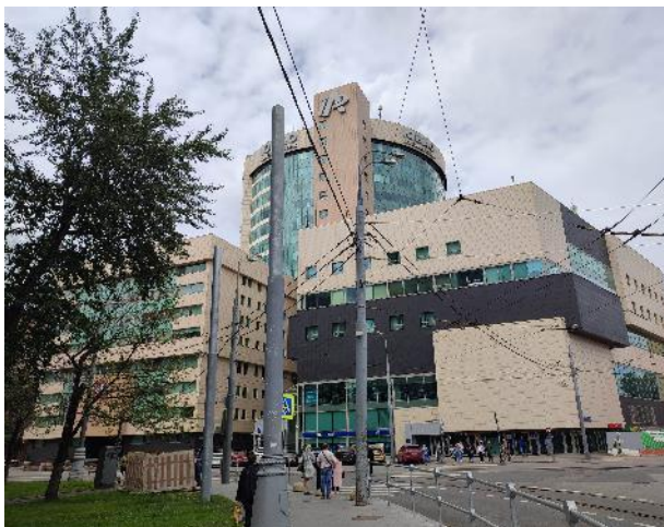
Фото 5. Подъездные пути и фасад здания
