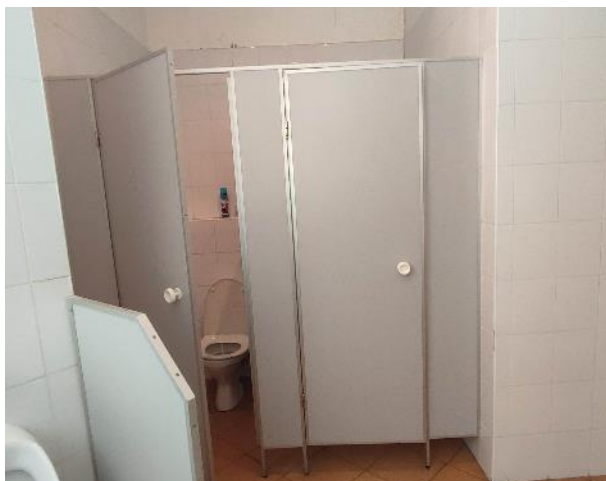
Фото 44. Внутренние помещения 6 этажа
