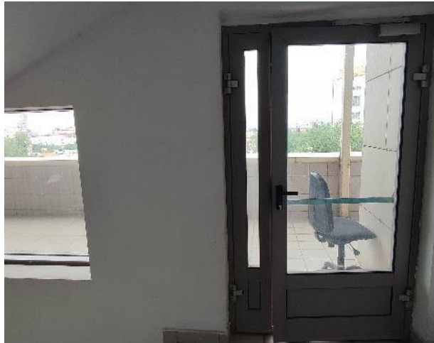
Фото 49. Внутренние помещения 7 этажа
