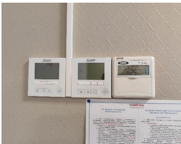
Фото 22. Внутренние помещения 2 этажа
