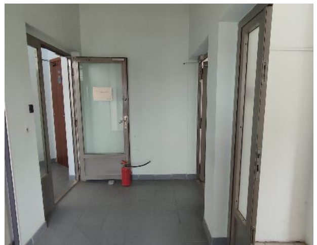
Фото 78. Внутренние помещения 8 этажа
