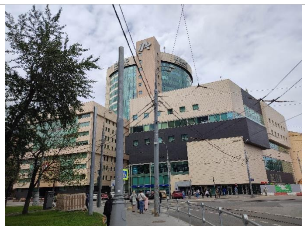
Фотография 2. Внешний вид здания
