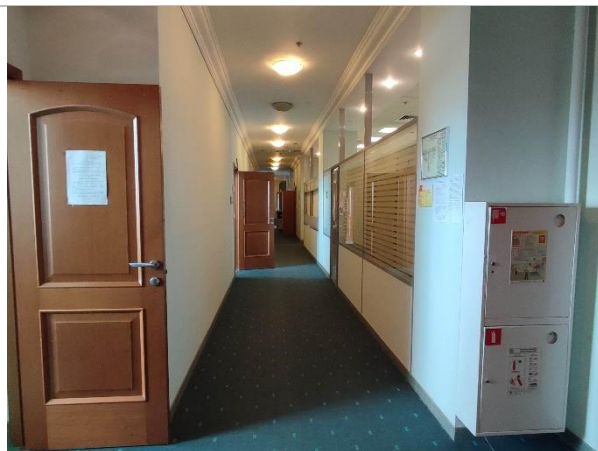
Фотография 11. Внутреннее состояние помещений — 9 этаж
