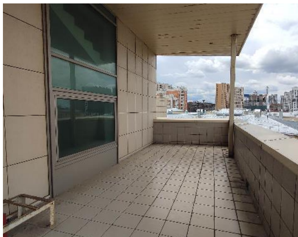
Фото 77. Внутренние помещения 8 этажа
