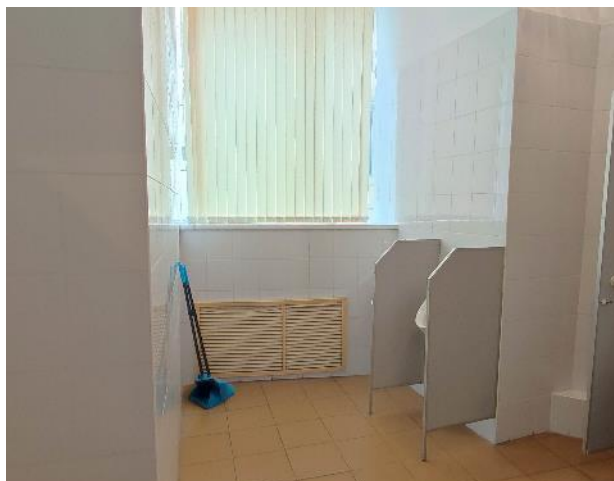
Фото 43. Внутренние помещения 6 этажа
