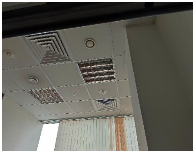
Фото 31. Внутренние помещения 6 этажа
