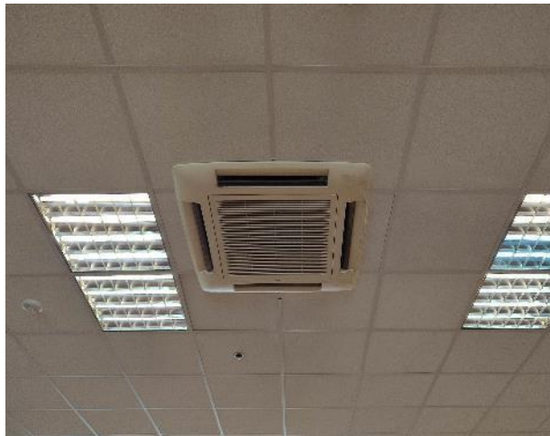
Фото 63. Внутренние помещения 7 этажа
