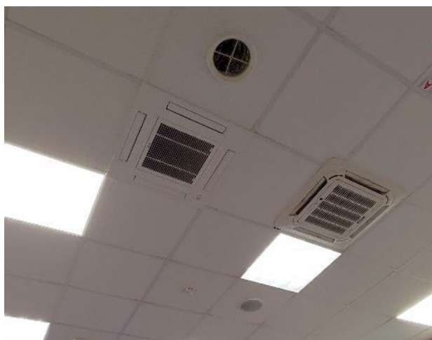
Фото 21. Внутренние помещения 2 этажа
