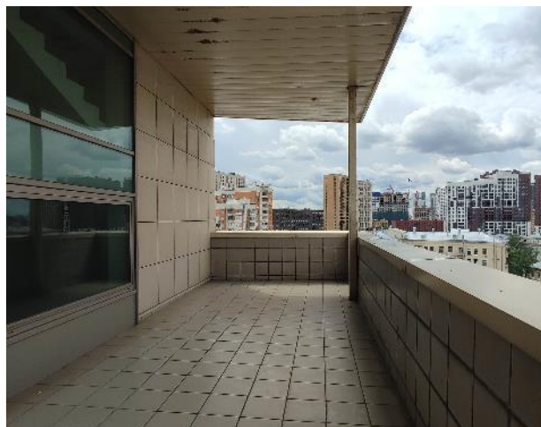
Фото 120. Внутренние помещения 9 этажа
