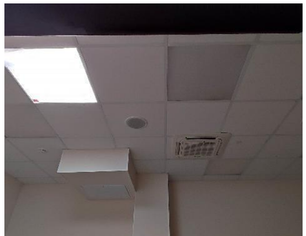
Фото 42. Внутренние помещения 3 этажа
