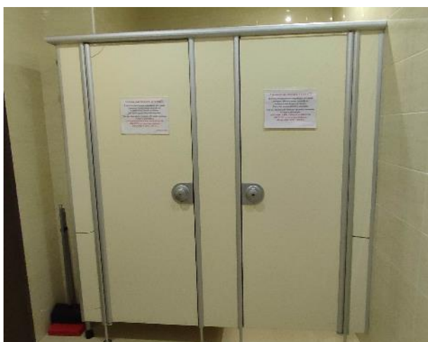
Фото 24. Внутренние помещения 2 этажа
