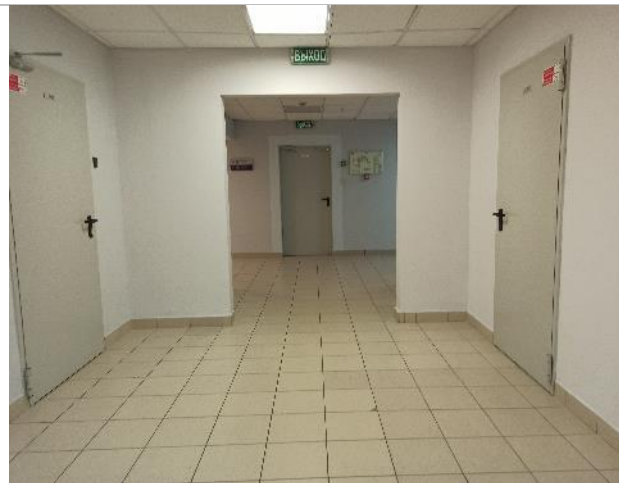
Фото 10. Внутреннее состояние помещений -5 этажа
