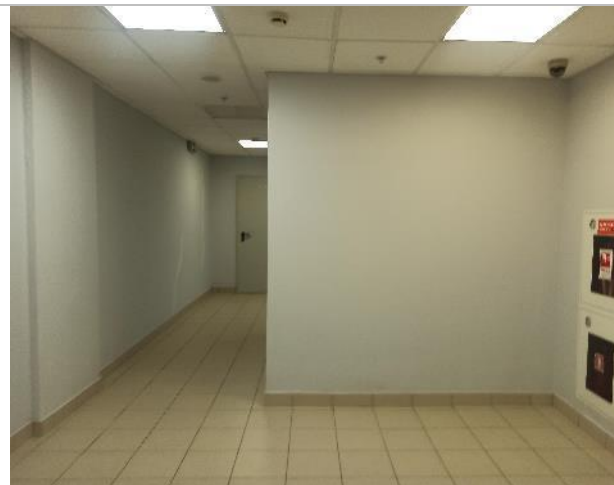
Фото 93. Внутреннее состояние помещений -2 этажа
