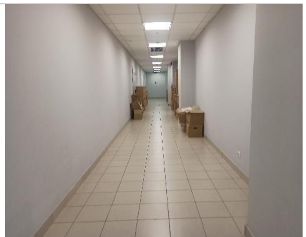
Фото 84. Внутреннее состояние помещений -3 этажа
