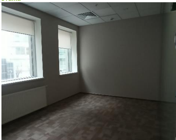
Фото 196. Внутреннее состояние помещений 3 этажа
