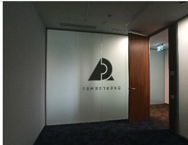
Фото 193. Внутреннее состояние помещений 3 этажа
