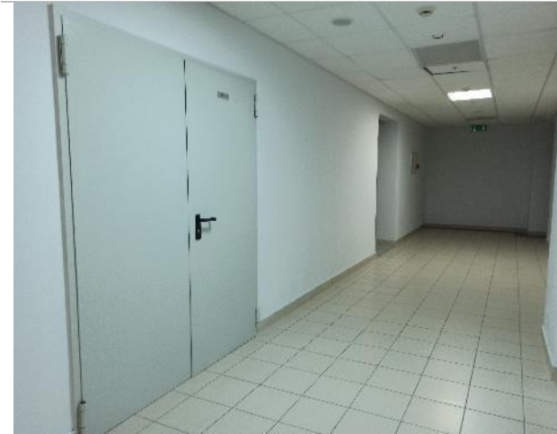
Фото 19. Внутреннее состояние помещений -5 этажа
