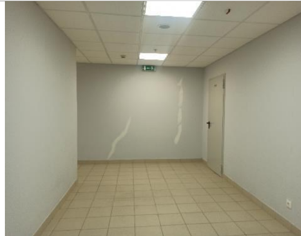
Фотография 5. Внутреннее состояние помещений -2 этажа
