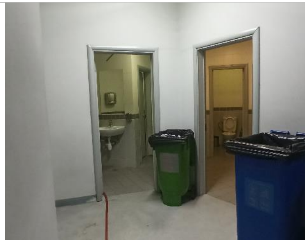
Фото 33. Внутреннее состояние помещений -4 этажа
