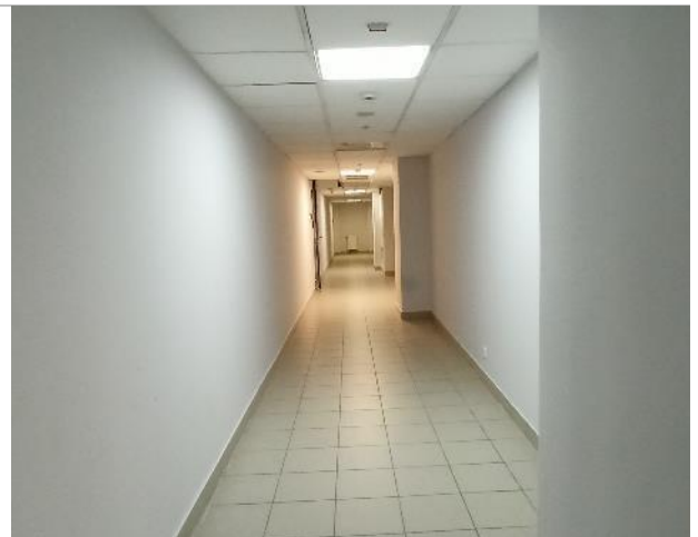
Фото 70. Внутреннее состояние помещений -4 этажа
