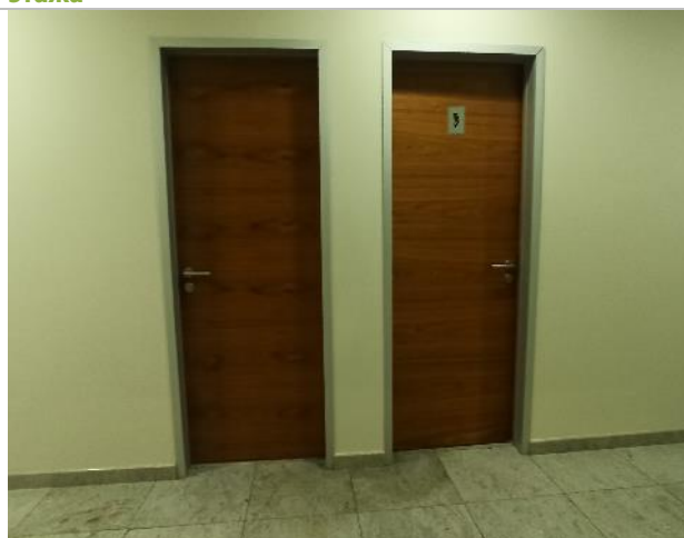
Фото 243. Внутреннее состояние помещений 17 этажа
