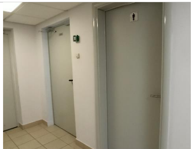
Фото 60. Внутреннее состояние помещений -4 этажа
