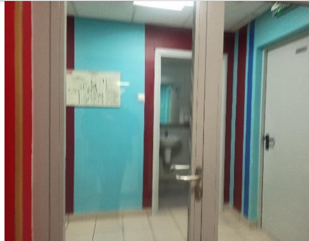
Фото 86. Внутреннее состояние помещений -2 этажа
