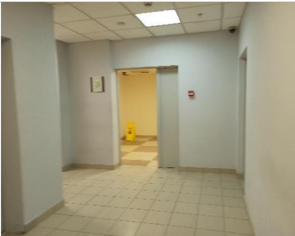
Фото 138. Внутреннее состояние помещений 1 этажа
