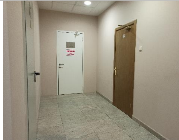
Фото 235. Внутреннее состояние помещений 10 этажа
