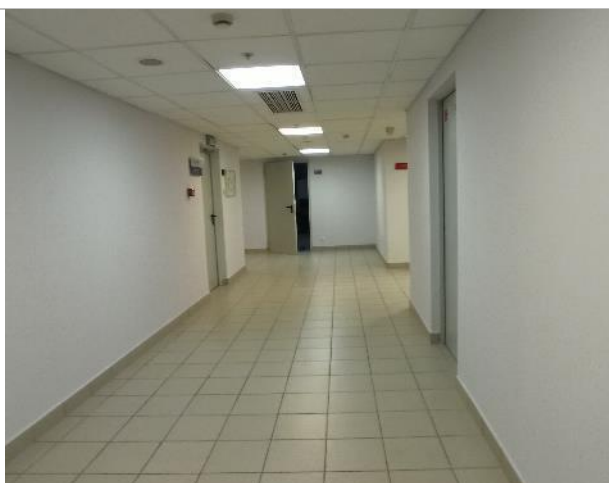
Фото 66. Внутреннее состояние помещений -4 этажа
