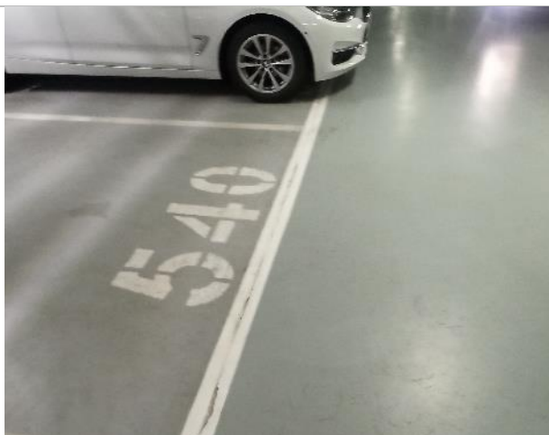
Фото 38. Внутреннее состояние помещений -4 этажа
