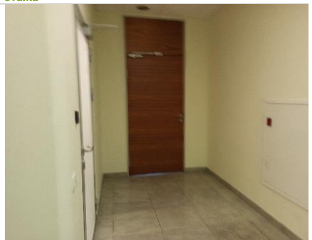
Фото 240. Внутреннее состояние помещений 17 этажа
