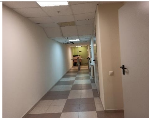
Фото 143. Внутреннее состояние помещений 1 этажа
