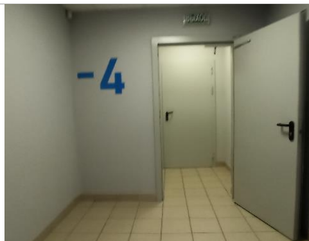
Фото 29. Внутреннее состояние помещений -4 этажа
