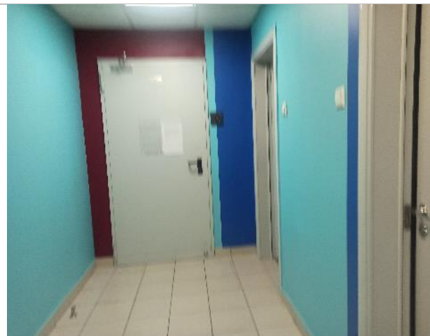
Фото 89. Внутреннее состояние помещений -2 этажа
