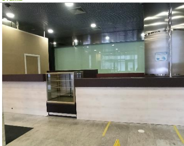
Фото 172. Внутреннее состояние помещений 2 этажа
