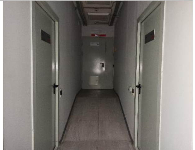
Фото 20. Внутреннее состояние помещений -5 этажа
