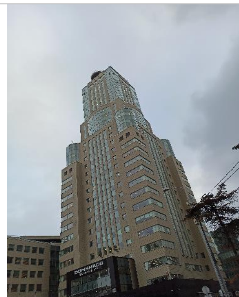
Фото 257. Внешний вид здания
