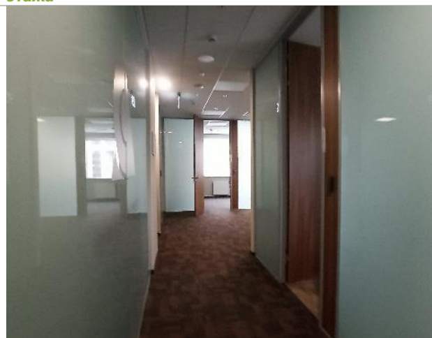
Фото 195. Внутреннее состояние помещений 3 этажа
