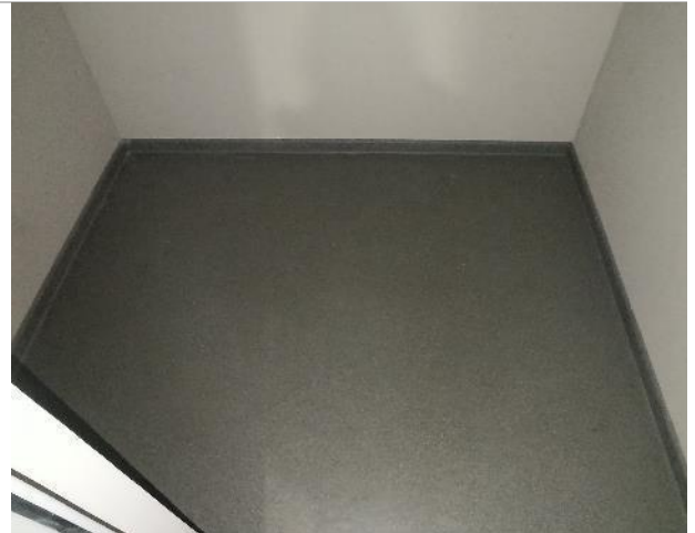
Фото 212. Внутреннее состояние помещений 3 этажа
