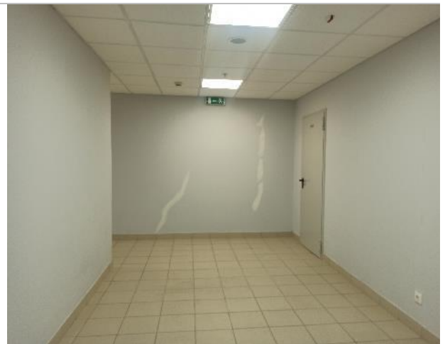
Фото 94. Внутреннее состояние помещений -2 этажа
