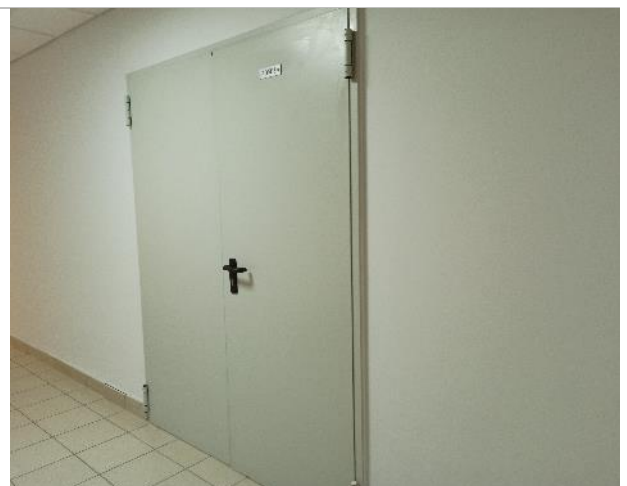
Фото 24. Внутреннее состояние помещений -5 этажа
