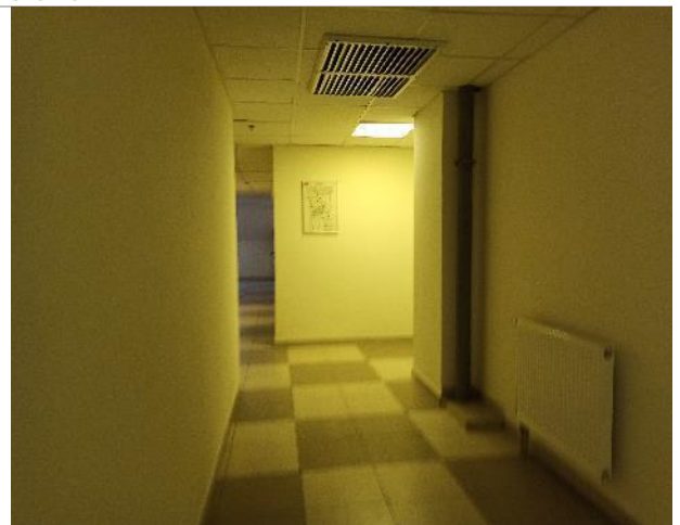
Фото 144. Внутреннее состояние помещений 1 этажа
