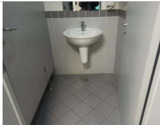
Фото 87. Внутреннее состояние помещений -2 этажа
