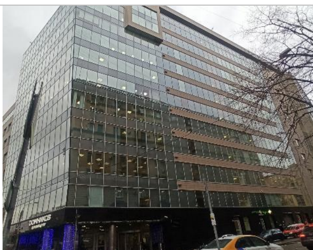
Фото 268. Внешний вид здания
