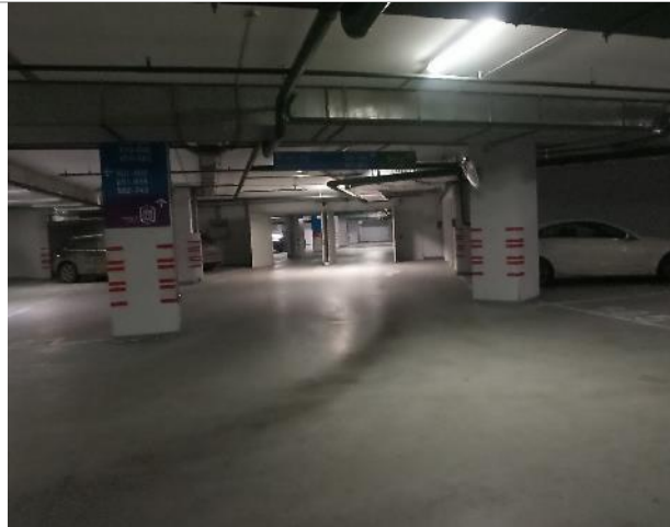
Фото 55. Внутреннее состояние помещений -4 этажа
