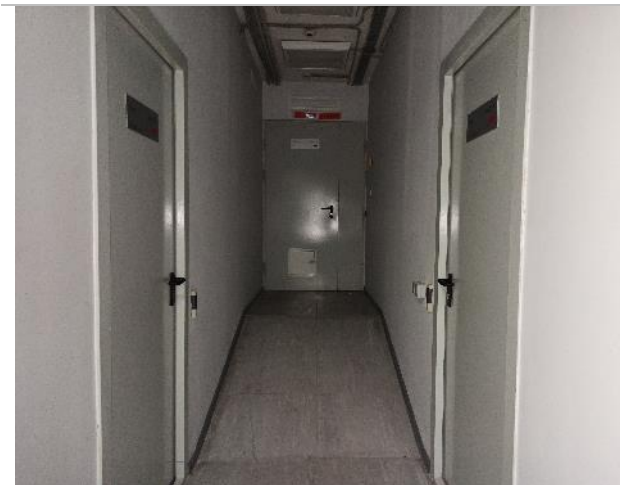
Фото 21. Внутреннее состояние помещений -5 этажа
