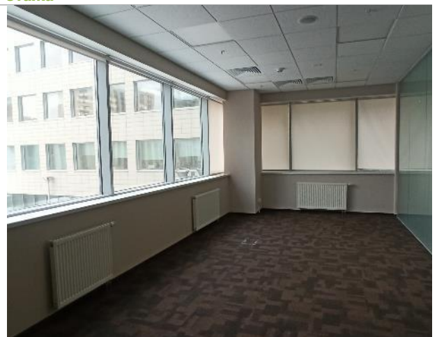
Фото 204. Внутреннее состояние помещений 3 этажа
