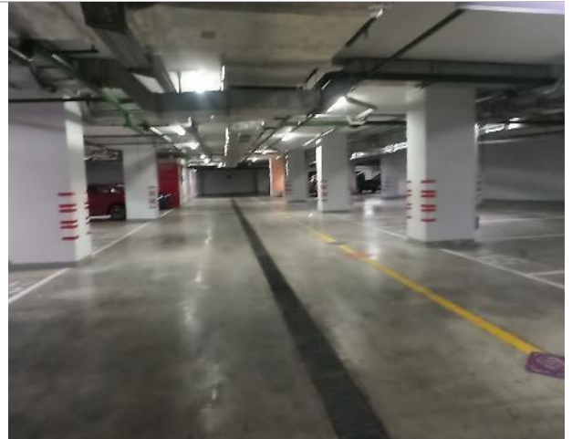
Фото 8. Внутреннее состояние помещений -5 этажа
