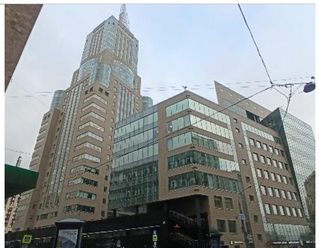
Фото 264. Внешний вид здания
