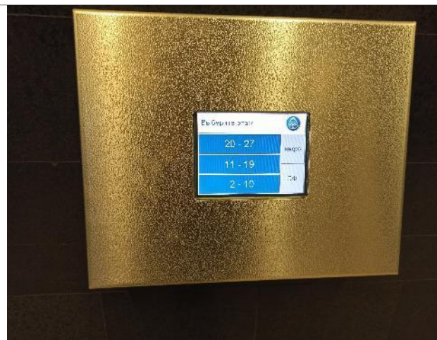
Фото 229. Внутреннее состояние помещений 10 этажа
