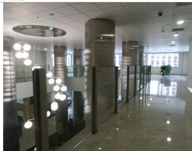
Фото 215. Внутреннее состояние помещений 3 этажа
