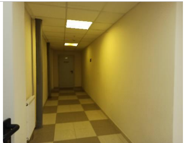
Фото 142. Внутреннее состояние помещений 1 этажа
