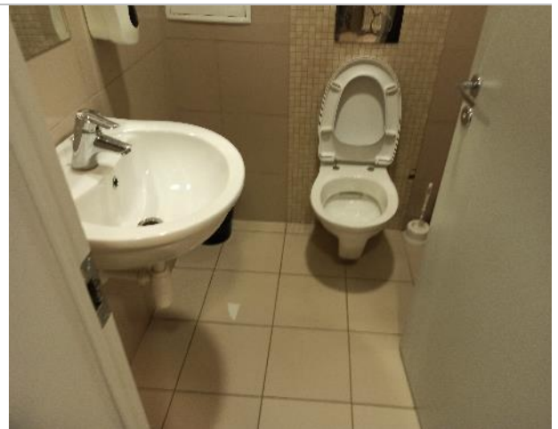
Фото 118. Внутреннее состояние помещений -1 этажа
