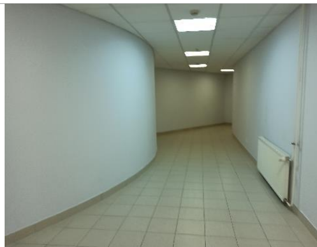
Фото 133. Внутреннее состояние помещений -1 этажа
