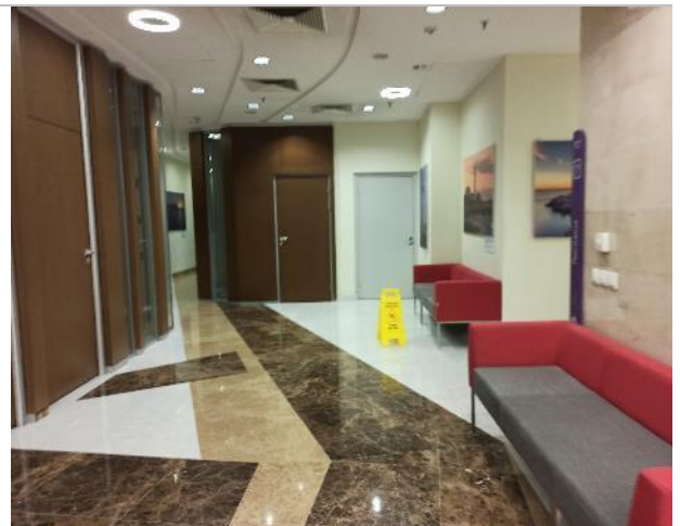
Фото 106. Внутреннее состояние помещений -1 этажа
