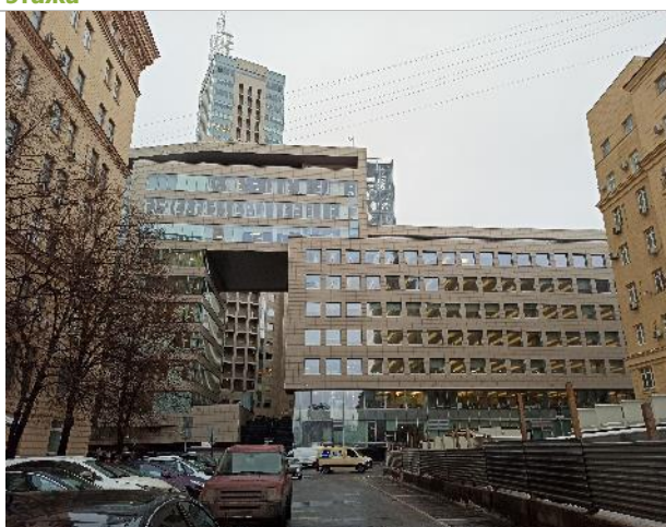
Фото 246. Внешний вид здания
