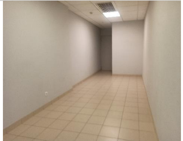
Фото 80. Внутреннее состояние помещений -3 этажа
