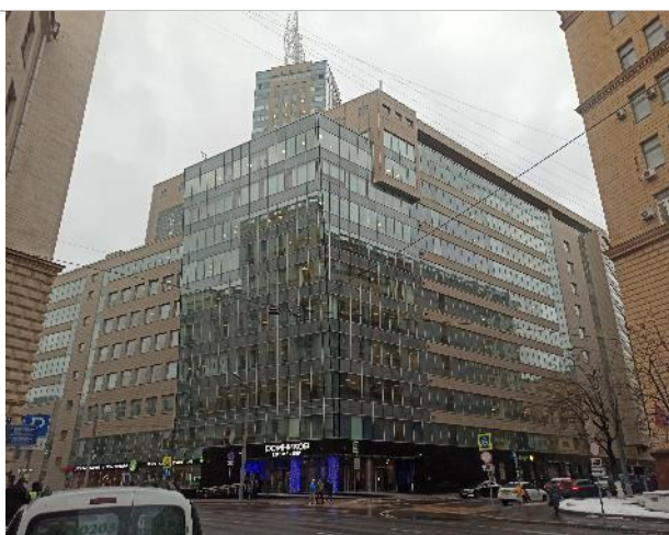
Фото 270. Внешний вид здания
