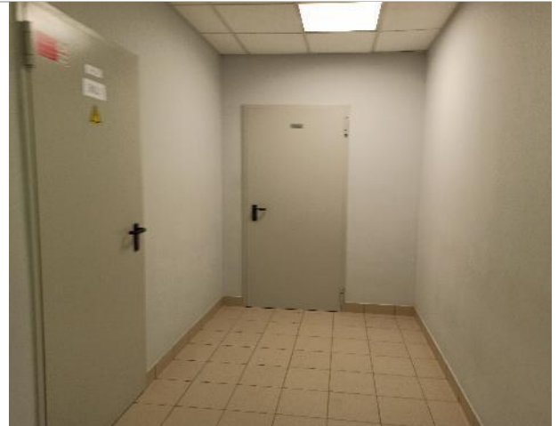
Фото 140. Внутреннее состояние помещений 1 этажа
