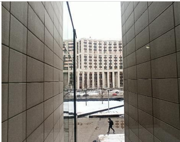
Фото 208. Внутреннее состояние помещений 3 этажа
