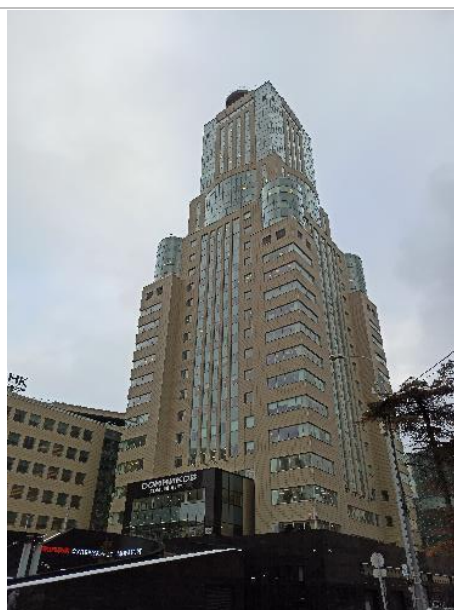
Фото 258. Внешний вид здания
