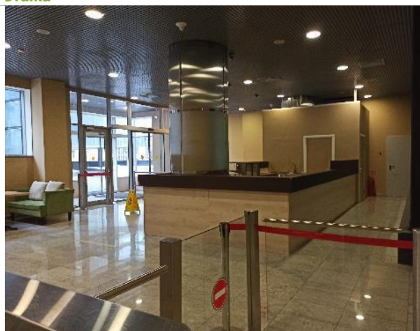
Фото 167. Внутреннее состояние помещений 2 этажа
