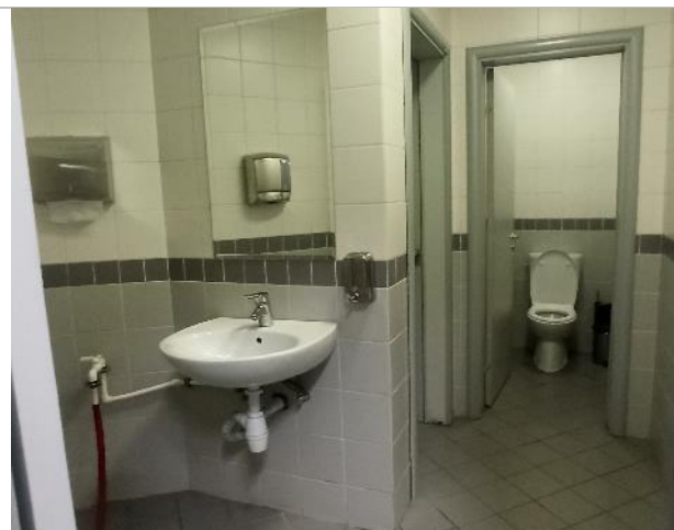
Фото 35. Внутреннее состояние помещений -4 этажа
