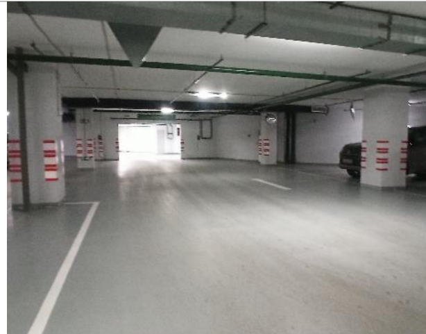
Фото 43. Внутреннее состояние помещений -4 этажа
