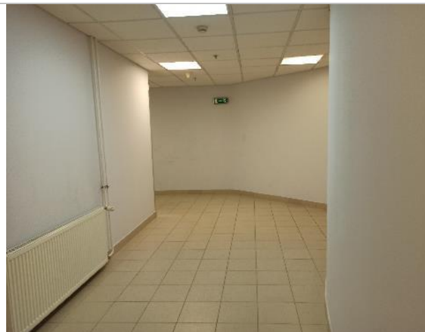
Фото 135. Внутреннее состояние помещений -1 этажа
