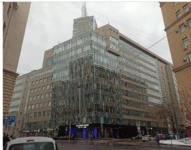
Фотография 1. Внешний вид здания
