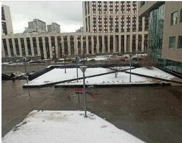
Фото 206. Внутреннее состояние помещений 3 этажа
