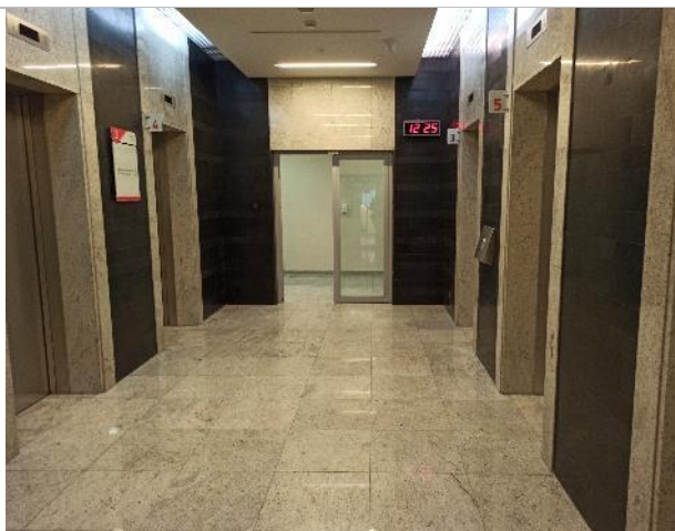
Фото 182. Внутреннее состояние помещений 3 этажа
