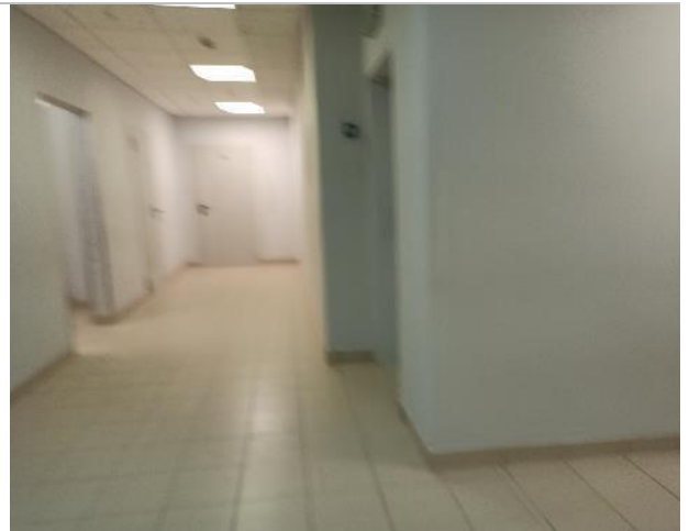
Фото 154. Внутреннее состояние помещений 1 этажа
