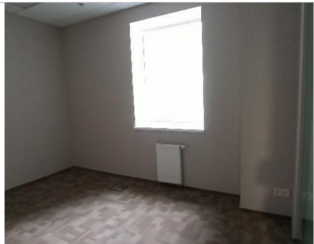
Фото 207. Внутреннее состояние помещений 3 этажа
