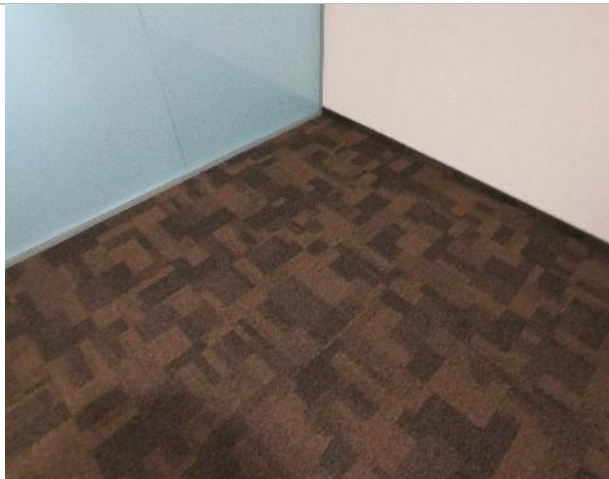
Фото 194. Внутреннее состояние помещений 3 этажа
