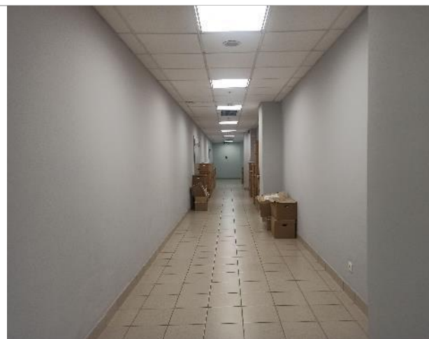
Фото 83. Внутреннее состояние помещений -3 этажа
