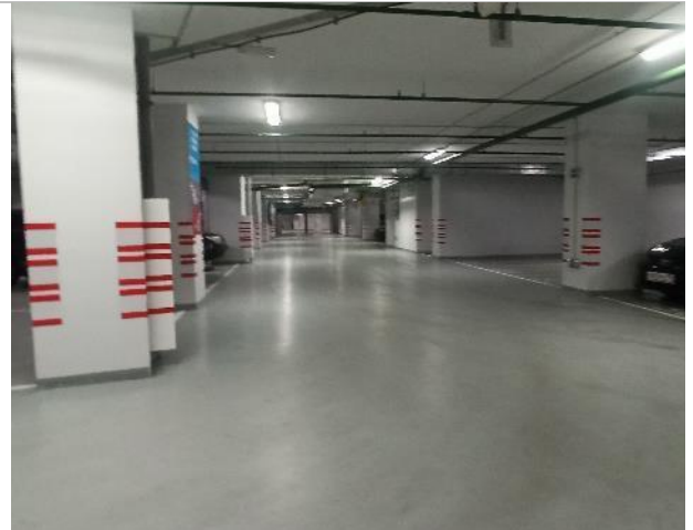
Фото 32. Внутреннее состояние помещений -4 этажа
