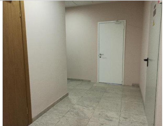
Фото 236. Внутреннее состояние помещений 10 этажа
