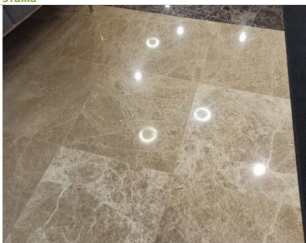
Фото 102. Внутреннее состояние помещений -1 этажа
