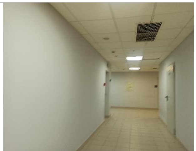
Фото 96. Внутреннее состояние помещений -2 этажа
