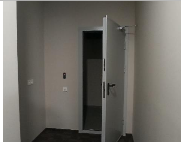
Фото 211. Внутреннее состояние помещений 3 этажа
