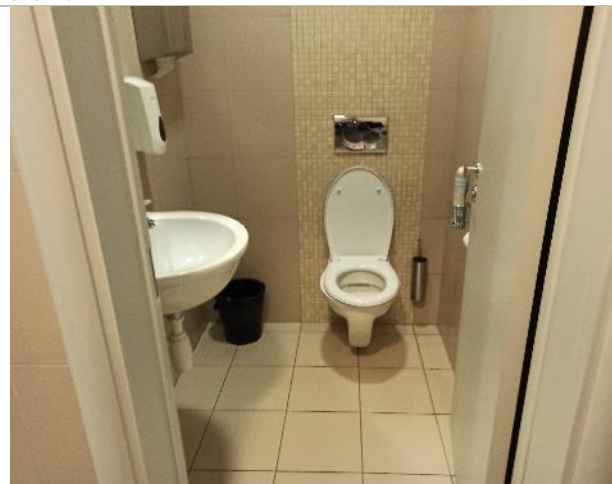
Фото 119. Внутреннее состояние помещений -1 этажа
