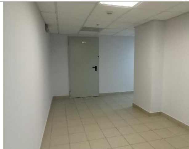
Фото 69. Внутреннее состояние помещений -4 этажа
