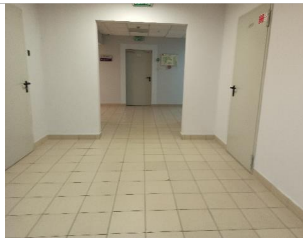
Фото 11. Внутреннее состояние помещений -5 этажа
