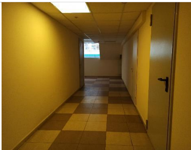
Фото 146. Внутреннее состояние помещений 1 этажа
