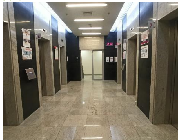
Фото 227. Внутреннее состояние помещений 4 этажа
