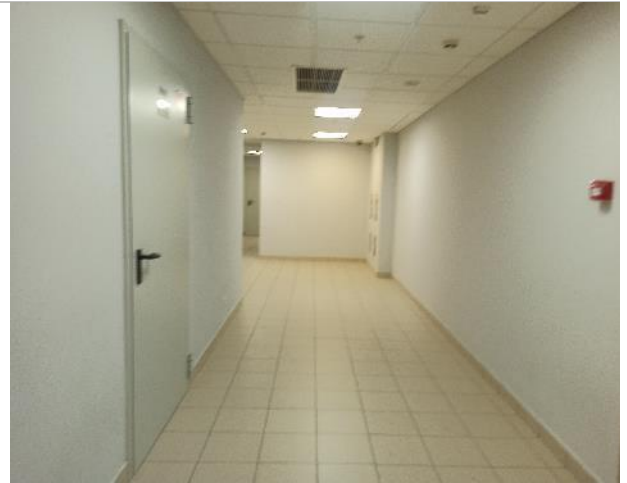
Фото 92. Внутреннее состояние помещений -2 этажа
