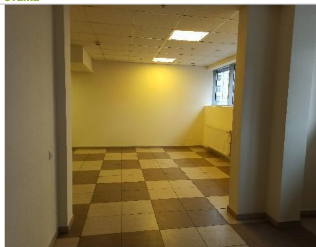
Фото 147. Внутреннее состояние помещений 1 этажа
