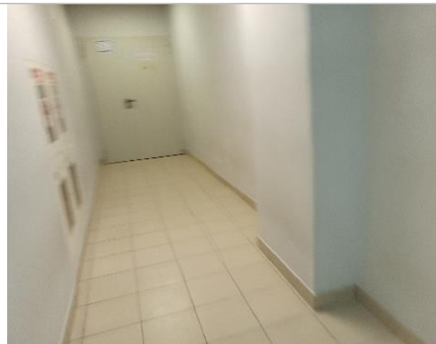
Фото 141. Внутреннее состояние помещений 1 этажа
