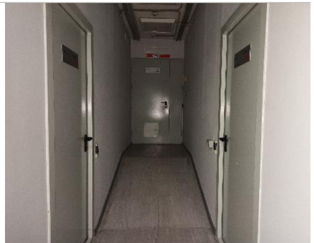
Фото 22. Внутреннее состояние помещений -5 этажа
