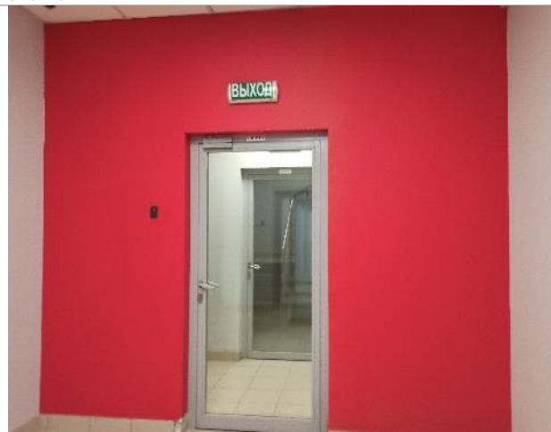
Фото 125. Внутреннее состояние помещений -1 этажа
