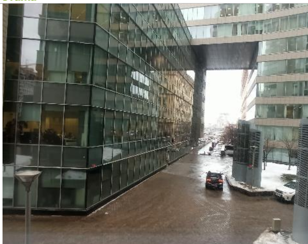
Фото 198. Внутреннее состояние помещений 3 этажа
