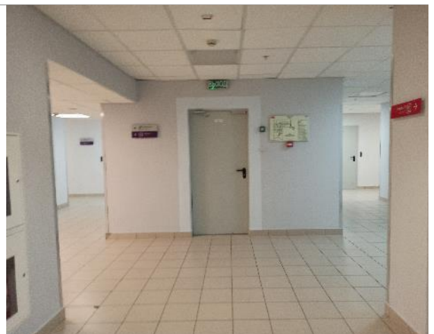
Фото 12. Внутреннее состояние помещений -5 этажа
