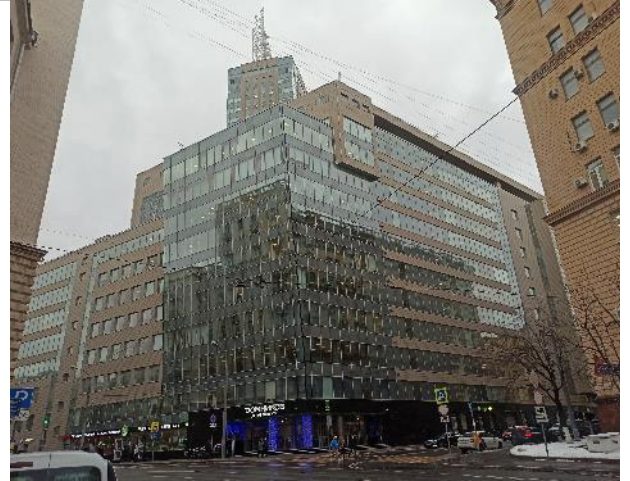
Фото 272. Внешний вид здания
