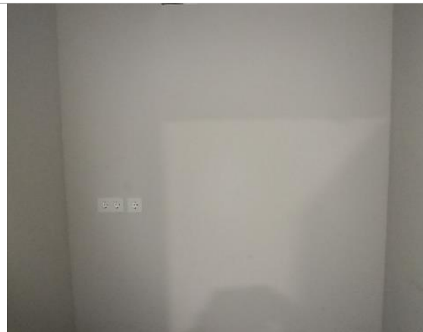
Фото 213. Внутреннее состояние помещений 3 этажа
