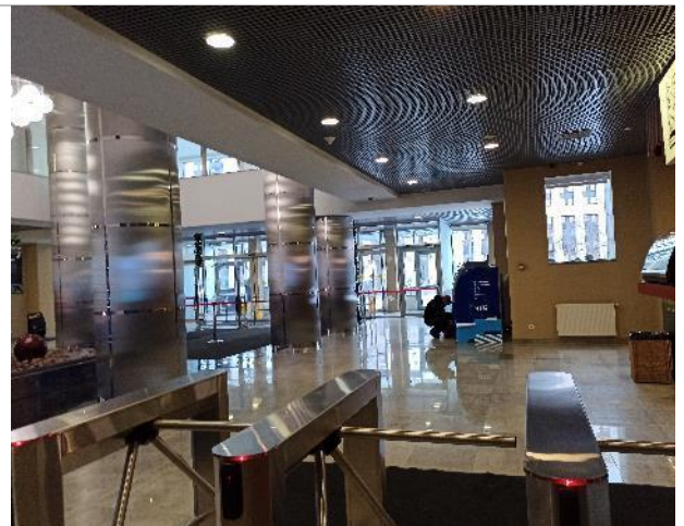
Фото 178. Внутреннее состояние помещений 2 этажа
