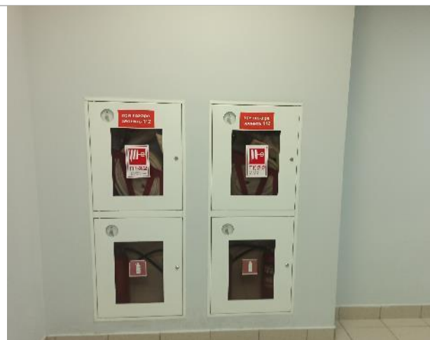
Фото 95. Внутреннее состояние помещений -2 этажа
