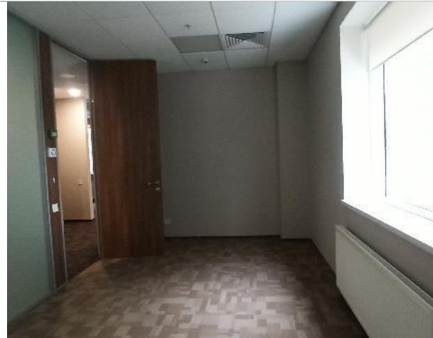
Фото 199. Внутреннее состояние помещений 3 этажа
