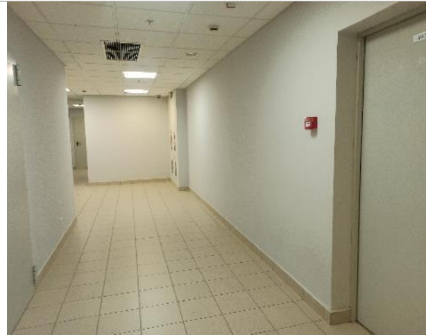
Фото 91. Внутреннее состояние помещений -2 этажа
