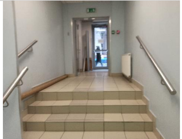
Фото 116. Внутреннее состояние помещений -1 этажа
