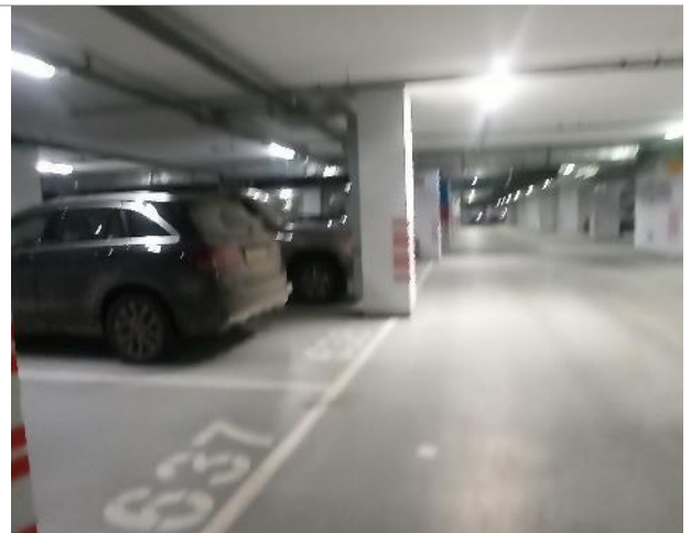
Фото 48. Внутреннее состояние помещений -4 этажа
