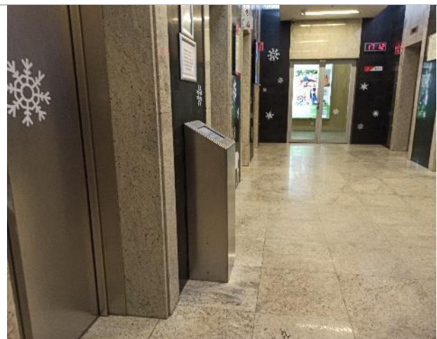
Фото 157. Внутреннее состояние помещений 2 этажа
