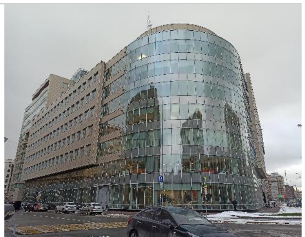
Фото 252. Внешний вид здания
