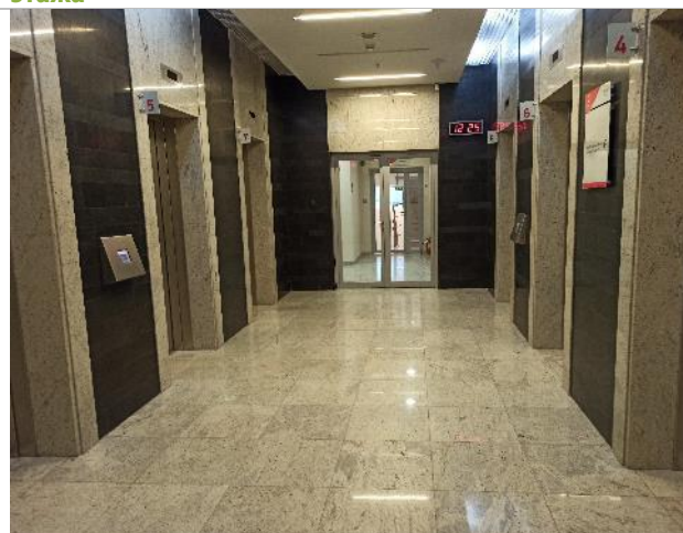
Фото 185. Внутреннее состояние помещений 3 этажа
