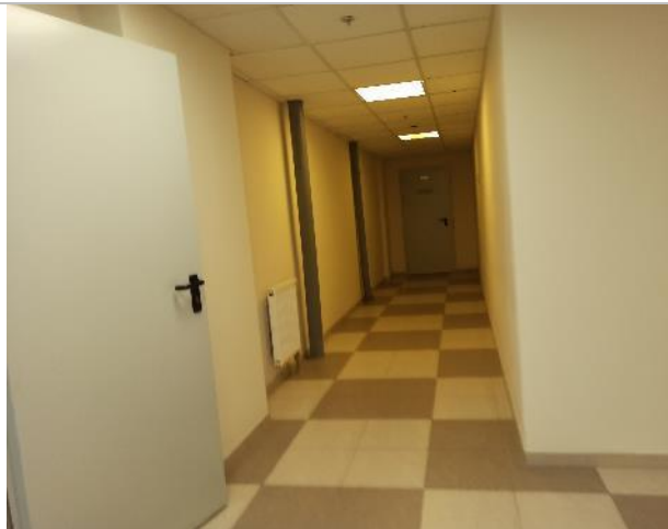
Фото 153. Внутреннее состояние помещений 1 этажа
