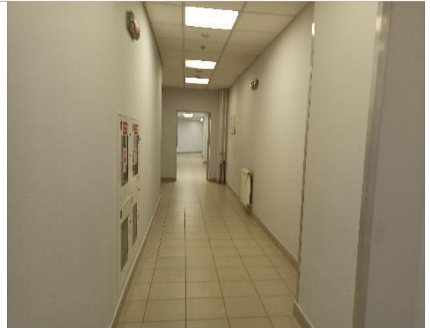
Фото 128. Внутреннее состояние помещений -1 этажа
