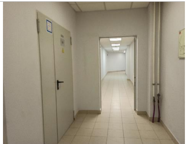
Фото 130. Внутреннее состояние помещений -1 этажа
