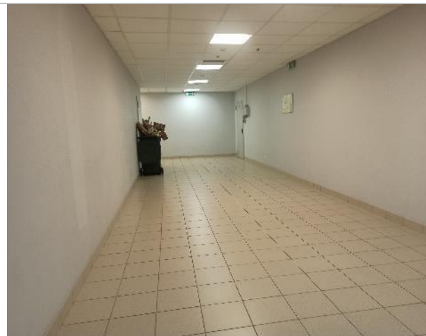
Фото 81. Внутреннее состояние помещений -3 этажа
