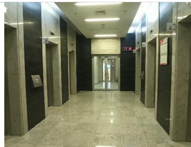
Фото 217. Внутреннее состояние помещений 3 этажа
