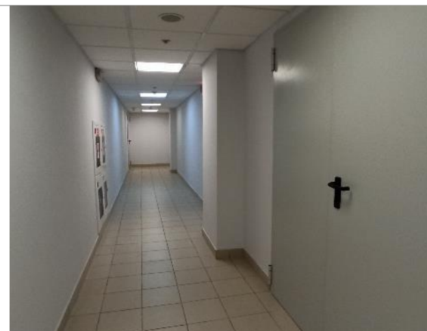
Фото 63. Внутреннее состояние помещений -4 этажа
