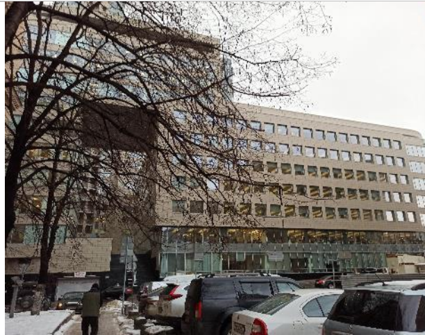
Фото 247. Внешний вид здания
