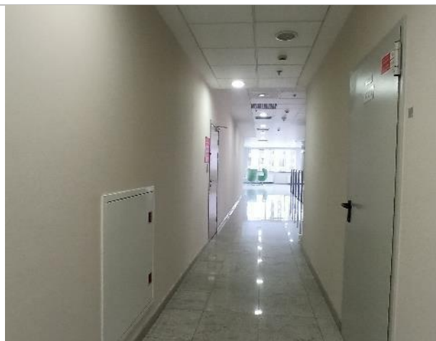
Фото 218. Внутреннее состояние помещений 4 этажа
