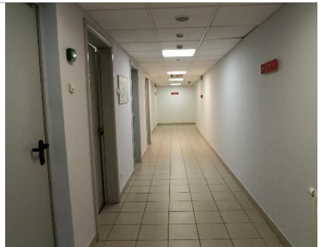
Фото 58. Внутреннее состояние помещений -4 этажа
