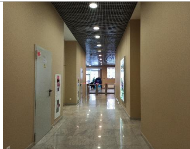
Фото 177. Внутреннее состояние помещений 2 этажа
