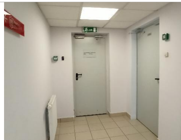
Фото 61. Внутреннее состояние помещений -4 этажа
