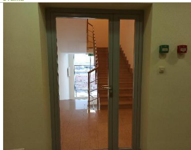
Фото 239. Внутреннее состояние помещений 17 этажа
