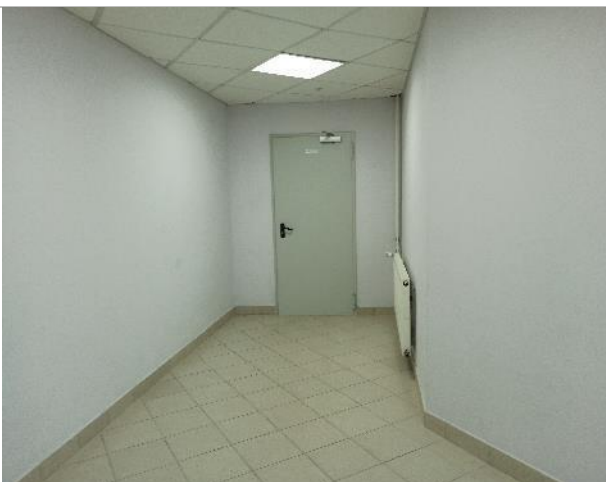
Фото 134. Внутреннее состояние помещений -1 этажа
