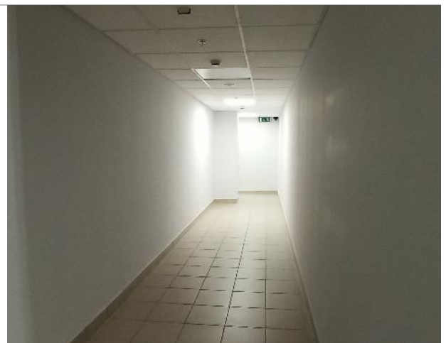
Фото 72. Внутреннее состояние помещений -4 этажа
