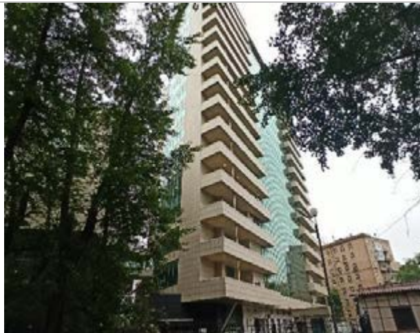
Фотография 3. Внешний вид здания
