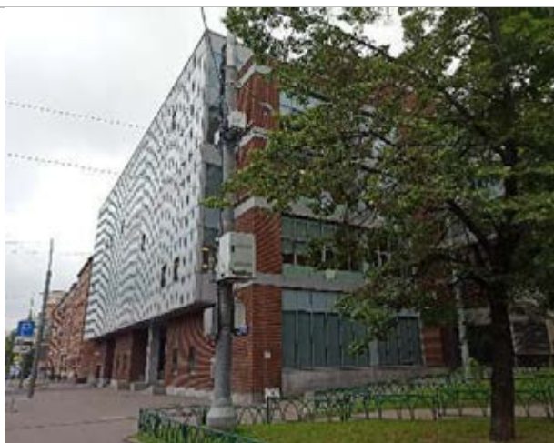
Фотография 24. Внешний вид здания
