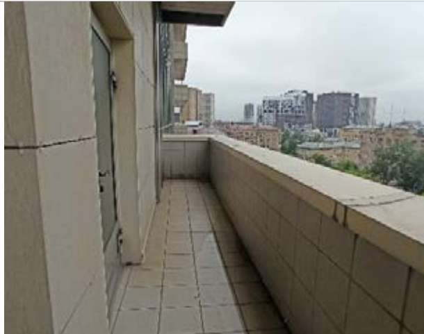
Фотография 13. Внутреннее состояние помещений — 8 этаж
