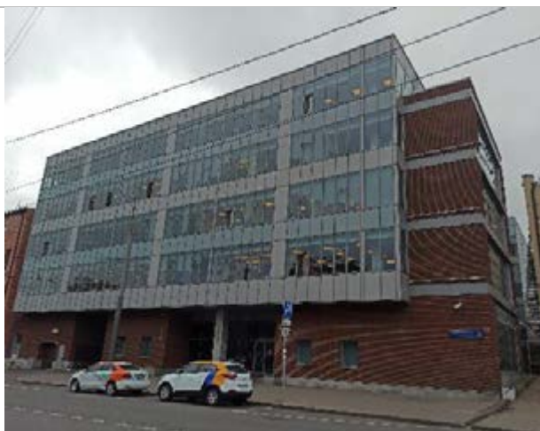
Фотография 22. Внешний вид здания
