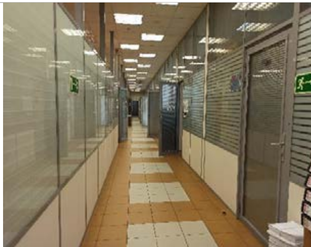
Фотография 5. Внутреннее состояние помещений — 6 этаж
