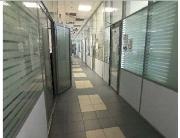
Фотография 14. Внутреннее состояние помещений — 8 этаж
