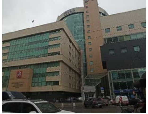
Фотография 2. Внешний вид здания
